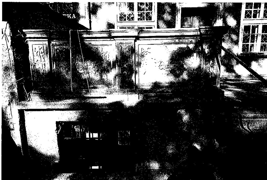
Widok na fragment balustrady przedproża nr 113. Widoczne zniszczenia tynków na murze działowym, pokryte glonami nakrywy, nawarstwienia na płycinach balustrady. Poniżej przemieszczenie płyty z kula, flankującą schody na sąsiednim przedprożu.
