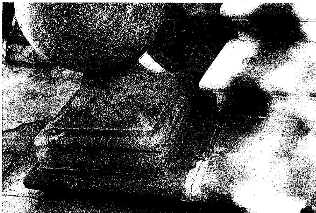
Widok na fragment balustrady przedproża nr 113. Widoczne zniszczenia tynków na murze działowym, pokryte glonami nakrywy, nawarstwienia na płycinach balustrady. Poniżej przemieszczenie płyty z kula, flankującą schody na sąsiednim przedprożu.
