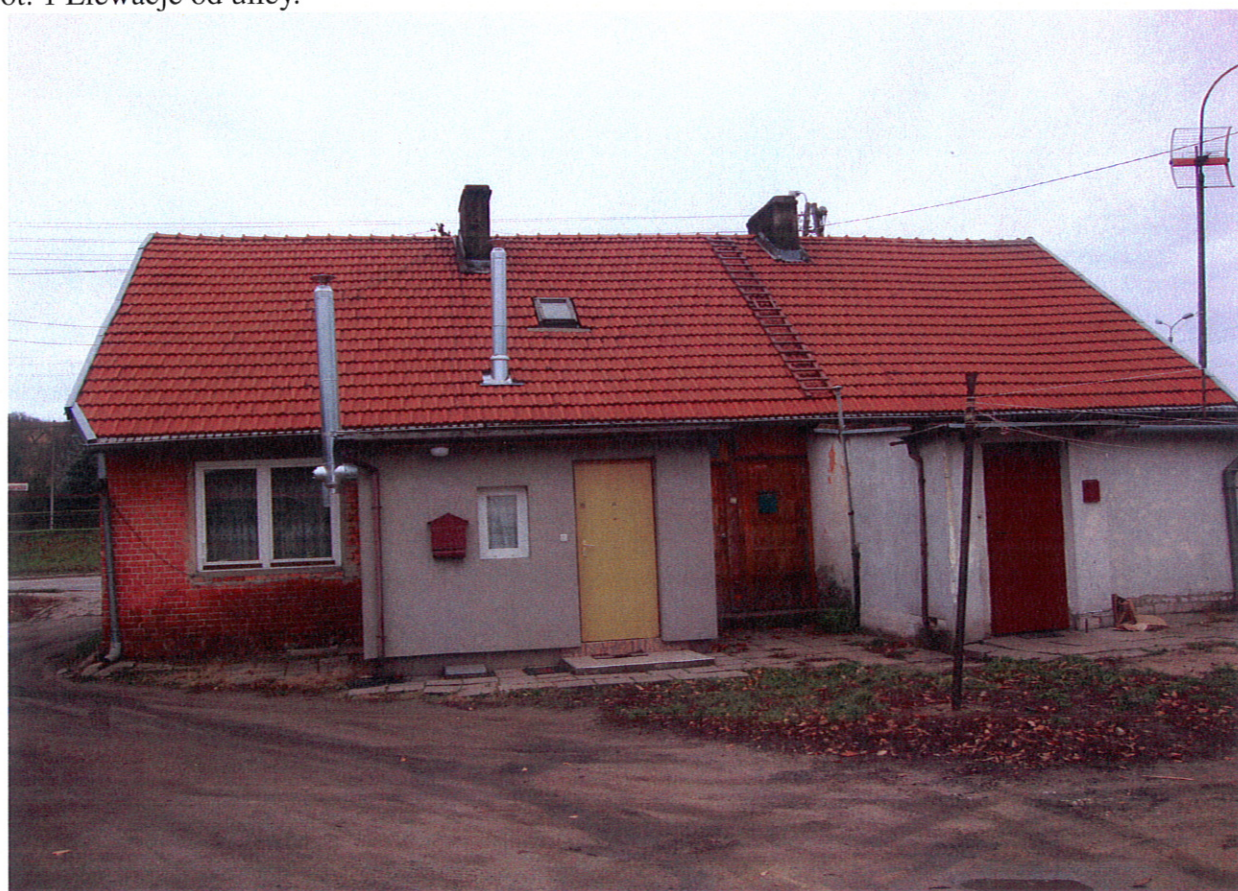
Fot. 2 Elewacje od podwórza.
