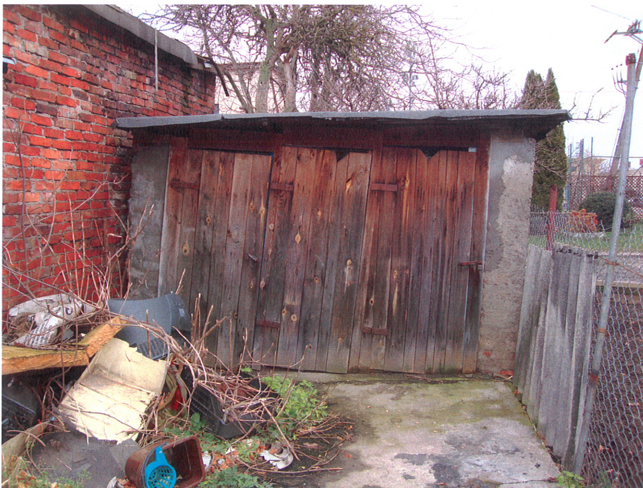
Fot. 9 Pomieszczenie WC na podwórzu (dot. lok. 3,4,5)
