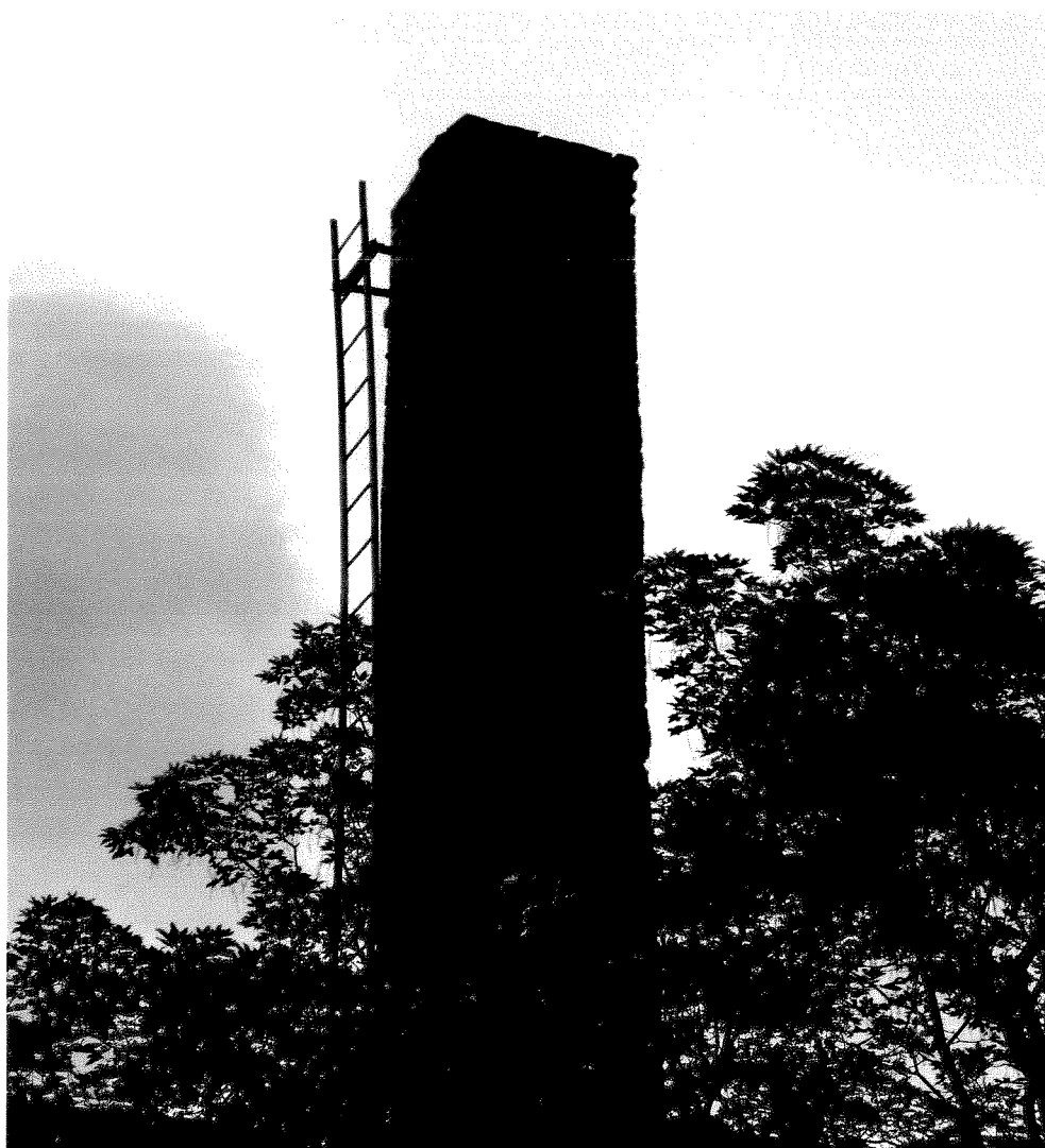
Fot. 4 Komin odchylony od pionu.
