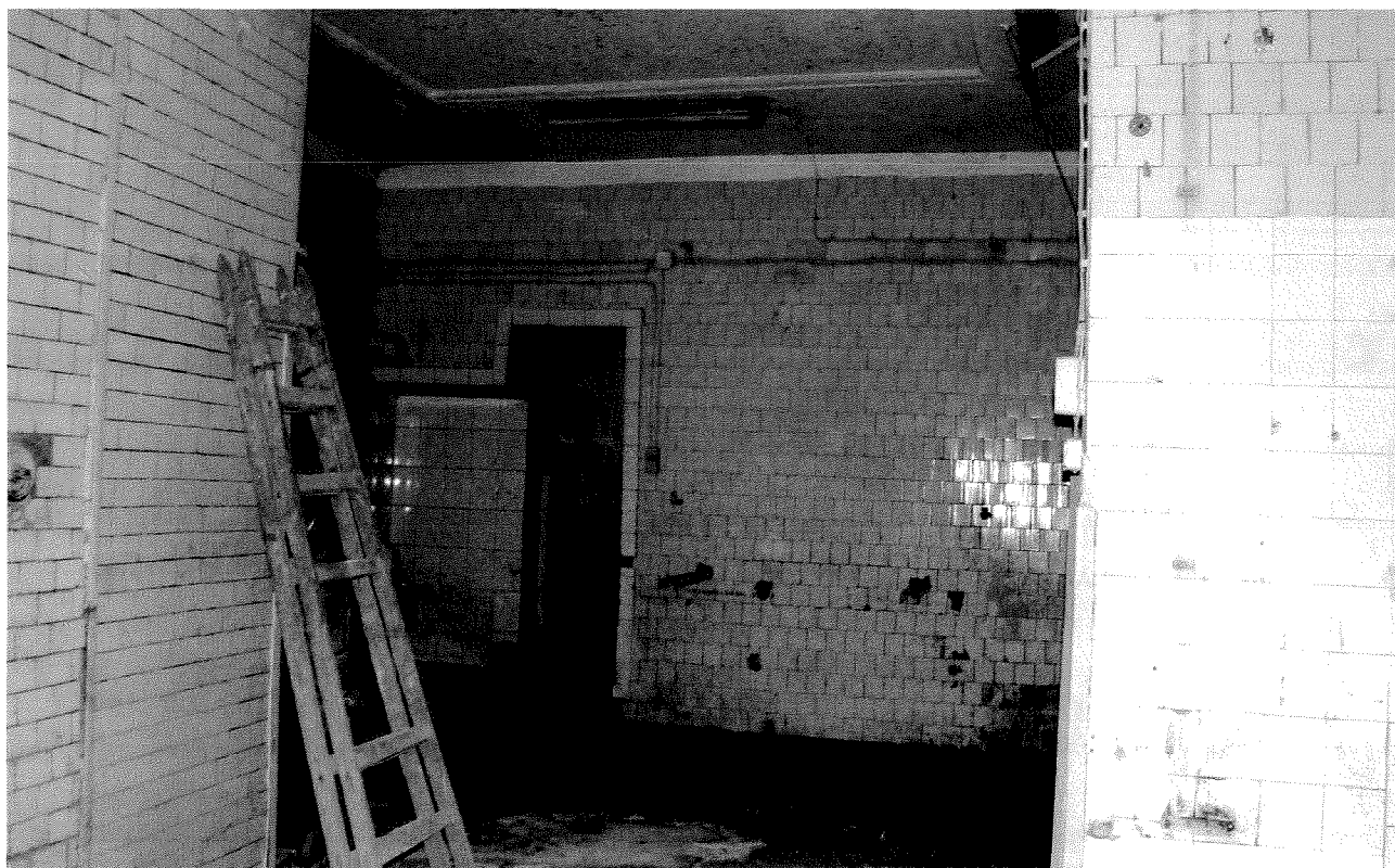
Fot. 11 Parter – pomieszczenie po byłej piekarni.
