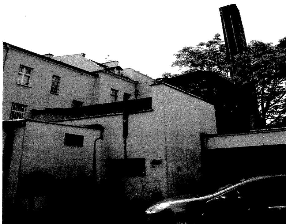
Fot 2. Elewacja boczna od podwórza – widoczny przylegający garaż.
