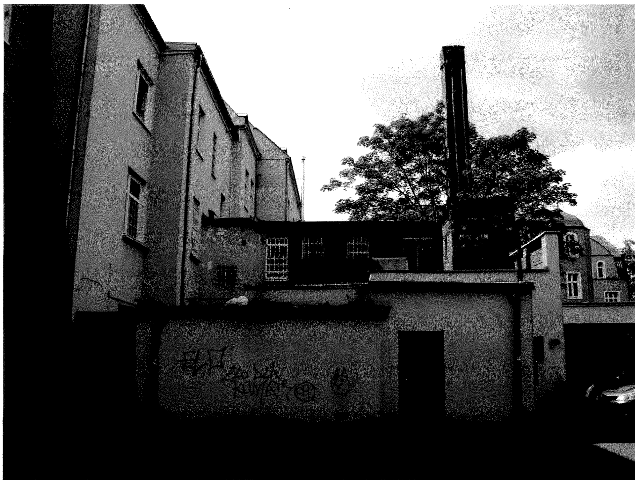
Fot.1 Elewacja wejściowa od podwórza – widoczny przylegający bud. 2A
