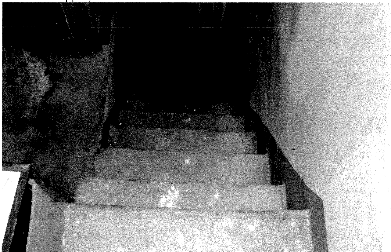
Fot. 22 Schody na I p.
