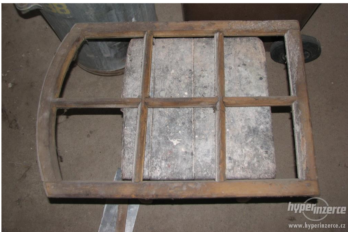
fot. 33 Analogia: skrzydło okna krosnowego ze szprosami konstrukcyjnymi.
