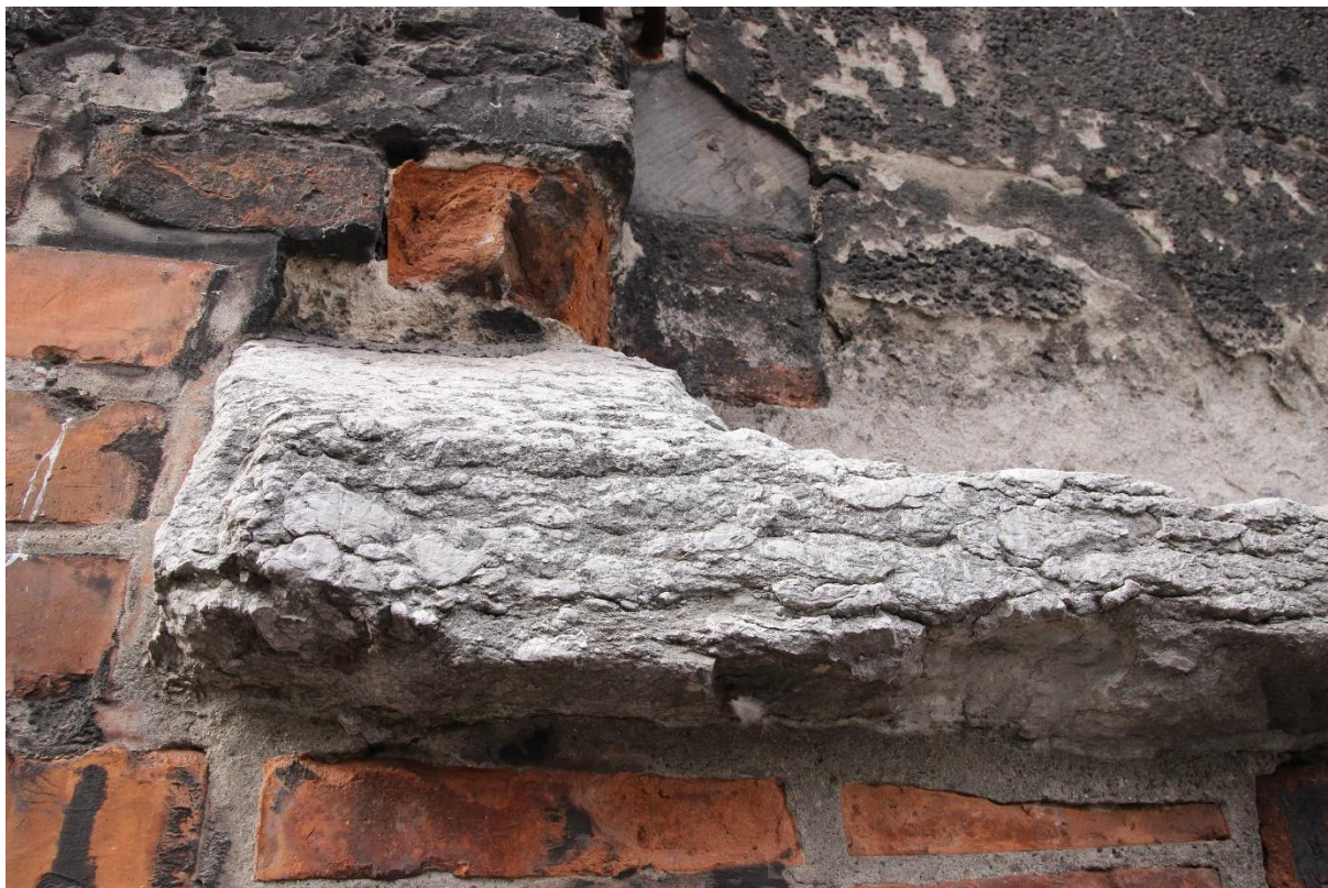
fot. 21 Widoczny kamienny parapet okienny w kondygnacji przyziemia, wykonany z wapiennej brekcji ordowickiej pochodzenia organicznego.
