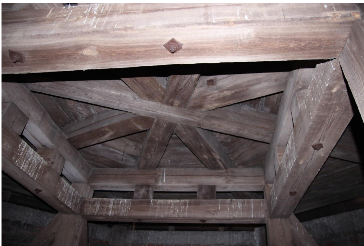
fot. 32 Widok na więźbę dachową.
