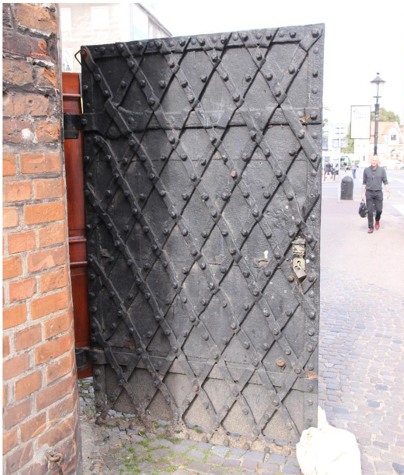
fot. 17 Awers kutych drzwi stalowych.
