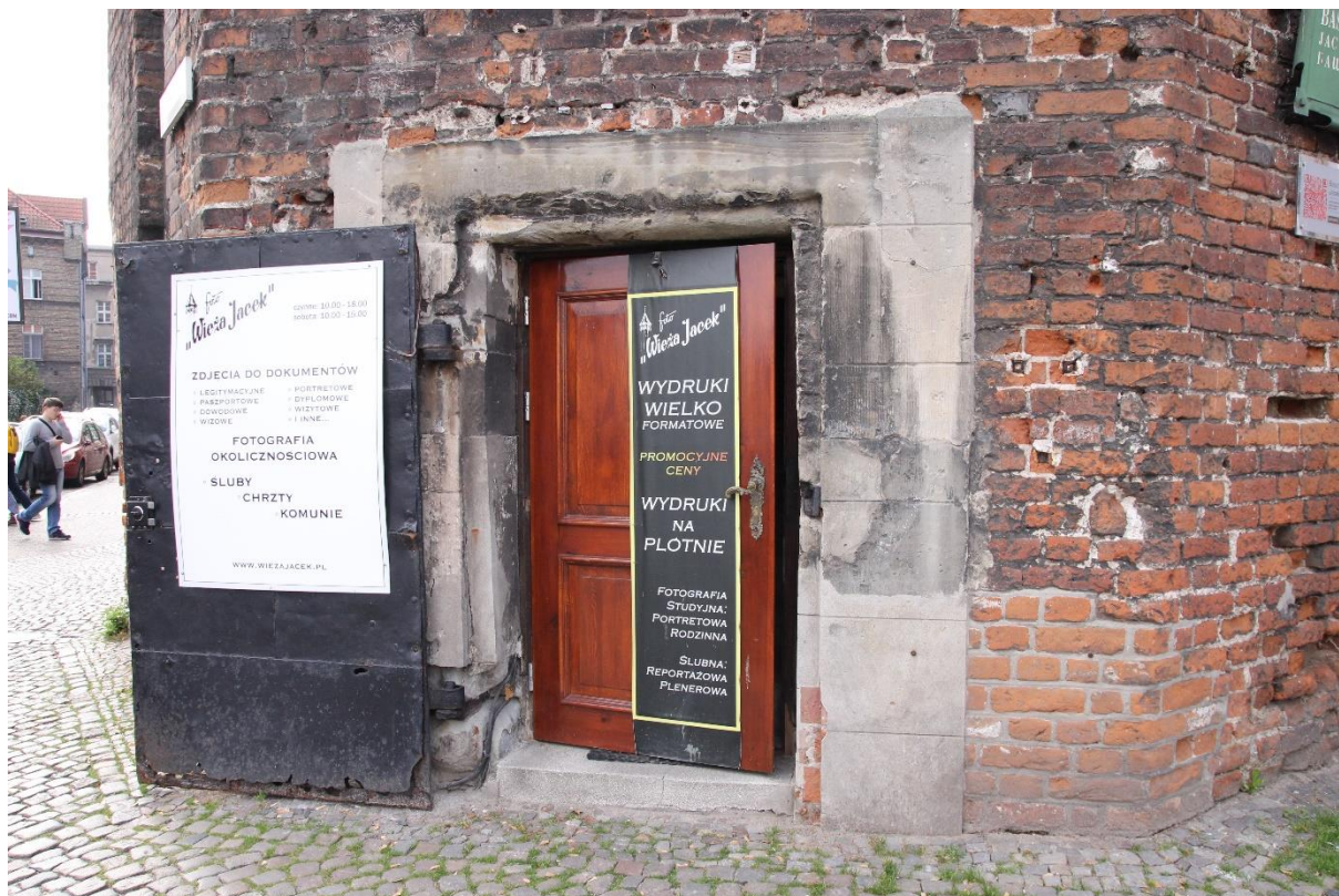
fot. 15 Widok na wejście do Baszty Jacek, widoczne historyczne drzwi stalowe, wtórne drzwi drewniane oraz portal z wapienia gotlandzkiego.
