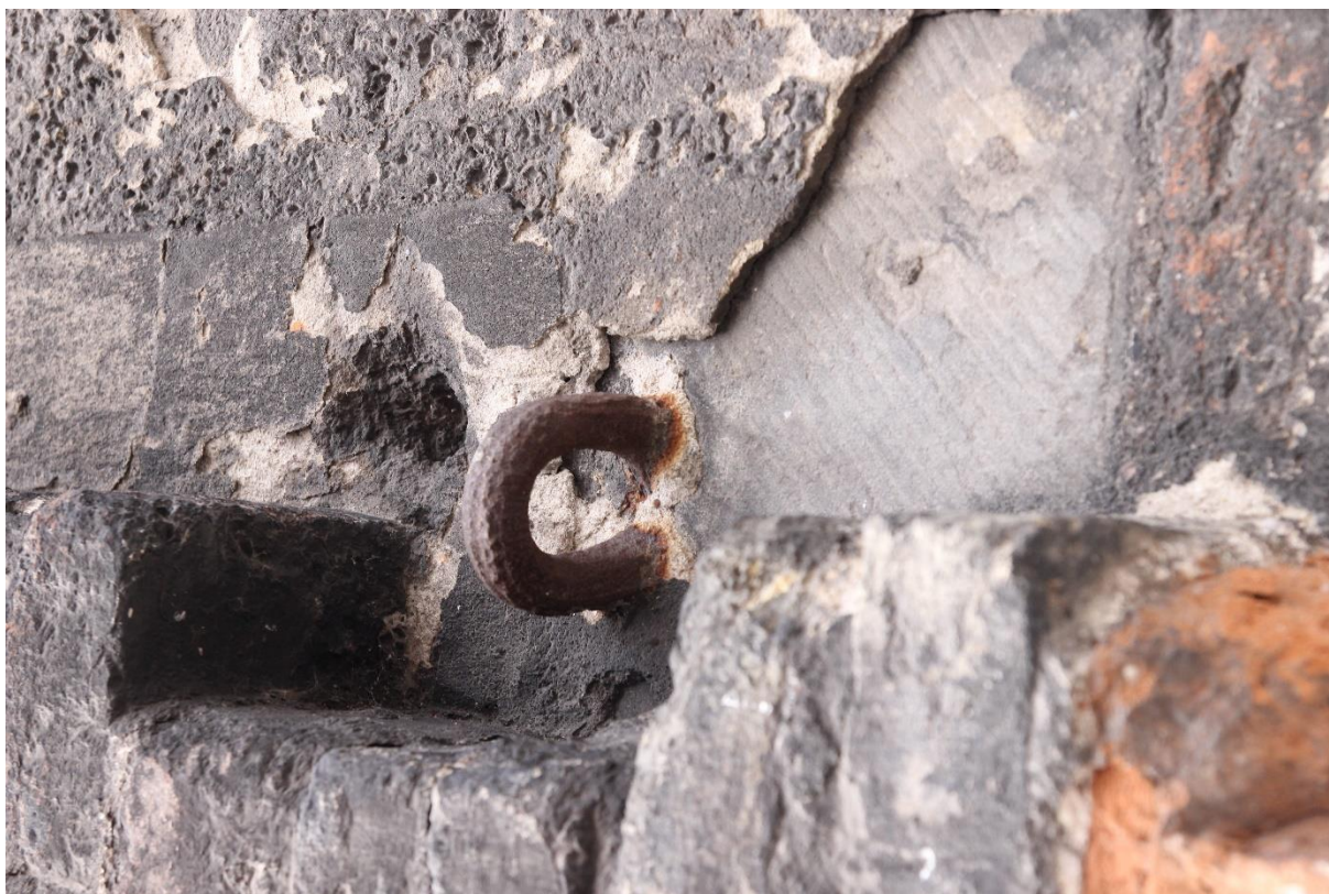
fot. 20 Widoczny fragment ciosu kamiennego z wapienia gotlandzkiego oraz ogniwo – pozostałość po okuciach zabezpieczających dawny otwór okienny.
