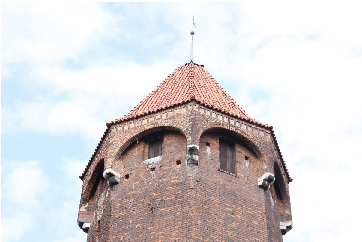
fot. 3 Widoczna górna część baszty, stan obecny.
