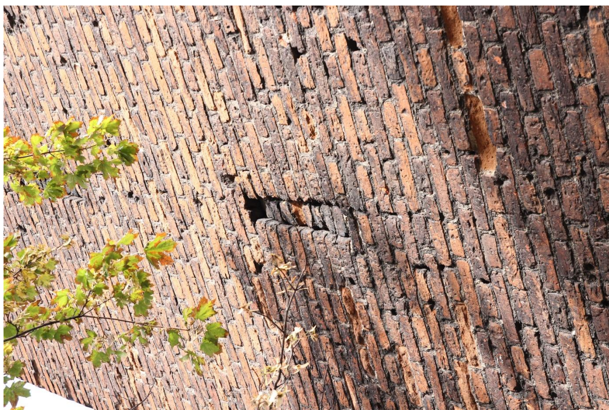
fot. 14 Widoczny zamurowany otwór strzelniczy.
