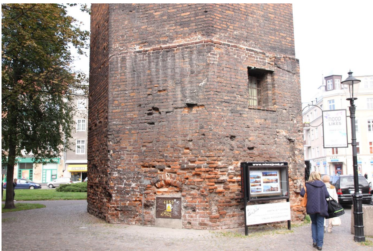
fot. 4 Partia przyziemia Baszty Jacek, stan obecny. Widok od strony południowo-wschodniej.
