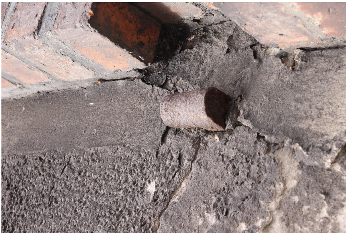
fot. 22 Widoczne zróżnicowanie w sposobie opracowania tynku na powierzchni wnęki okiennej oraz dolna część zawiasu hakowego - pozostałość po okuciach dawnego zabezpieczenia okna.
