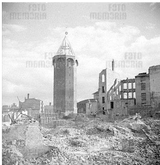
Ryc. 4 Baszta Jacek, 1947, za: www.fotomemoria.pl . Widoczna wiecha na nowej wieźbie dachowej, ustawionej na miejscu spalonej w 1945 r.
