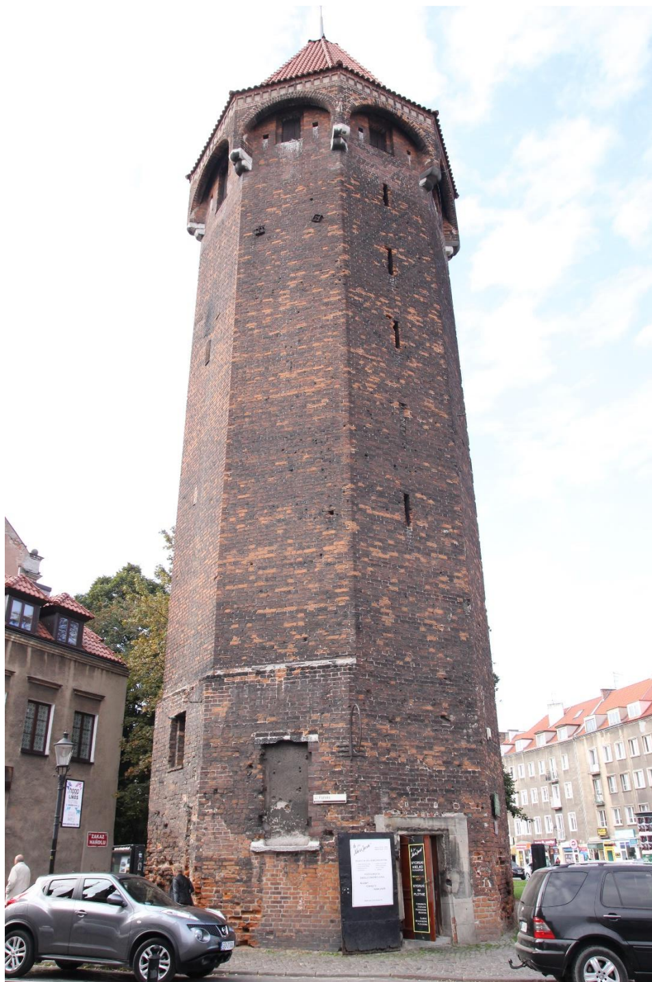
fot. 2 Baszta Jacek – widok od strony północno-wschodniej, stan obecny.
