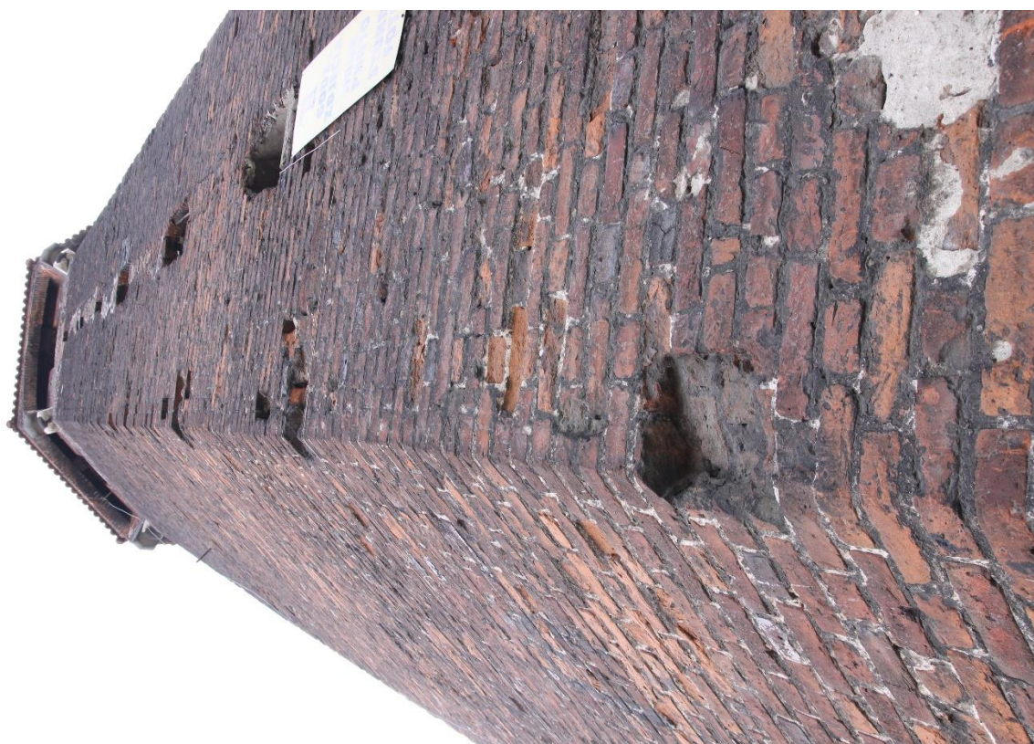
fot. 6 Widok na ścianę północną i północno-wschodnią, stan obecny.
