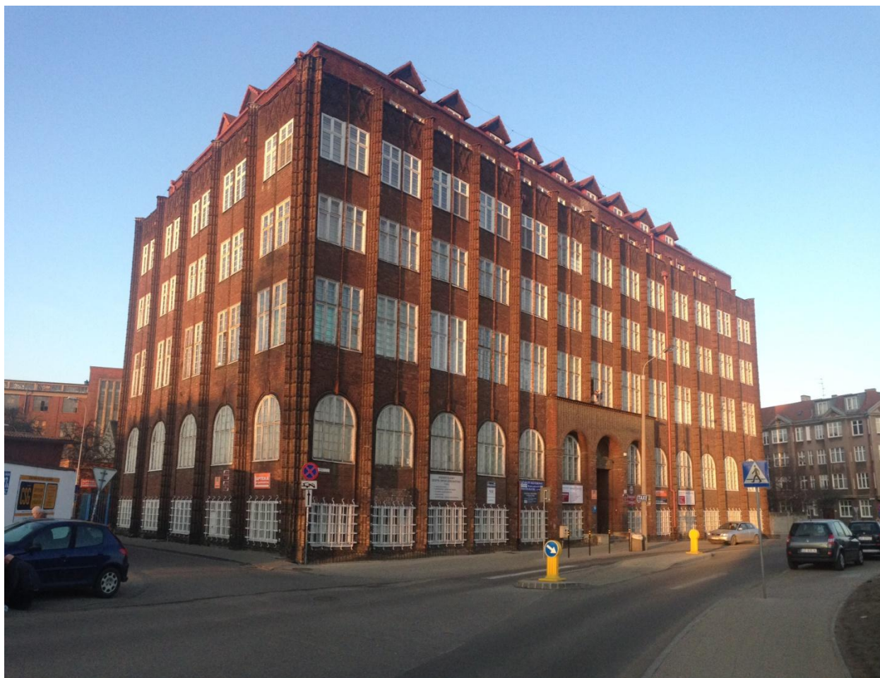
Fot. 1. Budynek przychodni lekarskiej w Gdańsku przy ul. Wałowej 27. Widok od strony frontowej (pd.) i zachodniej
