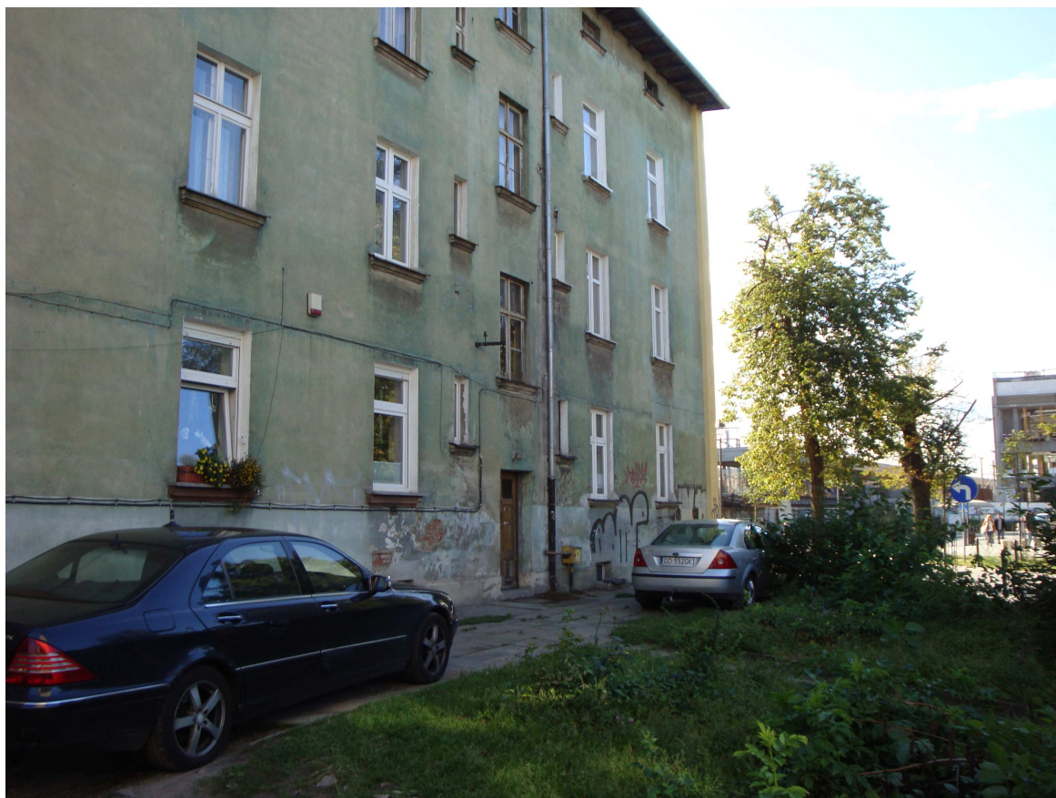
fot.11– widok od strony podwórza elewacja C fot. autor opracowania
