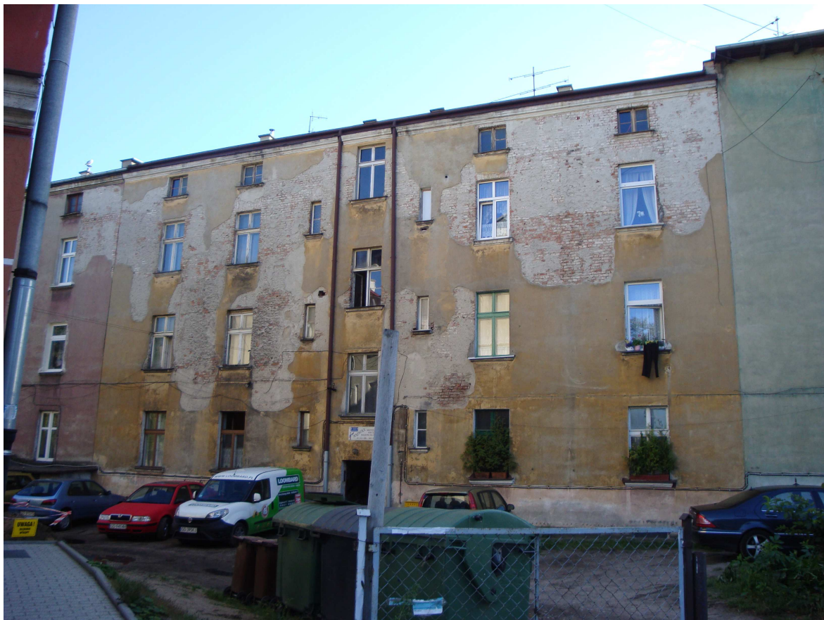
fot.10– widok od strony podwórza elewacja osi B fot. autor opracowania
