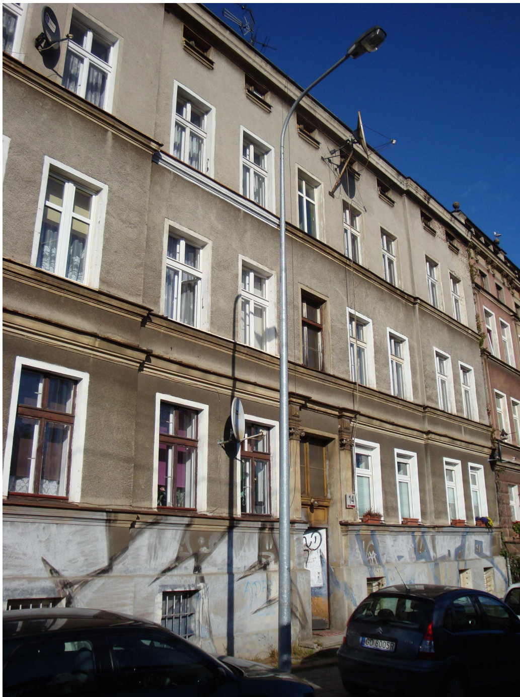
fot.9– widok od strony ulicy Białej elewacja osi C fot. autor opracowania
