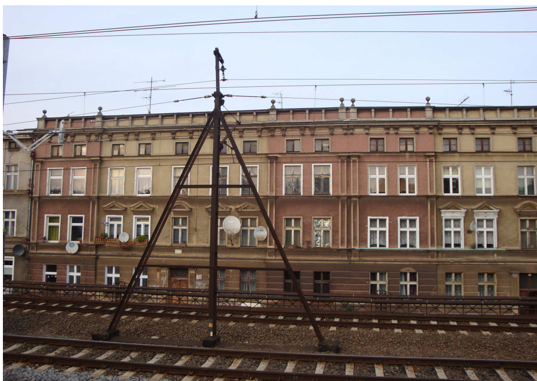
fot.13– widok od strony ulicy Białej elewacja osi B fot. autor opracowania
