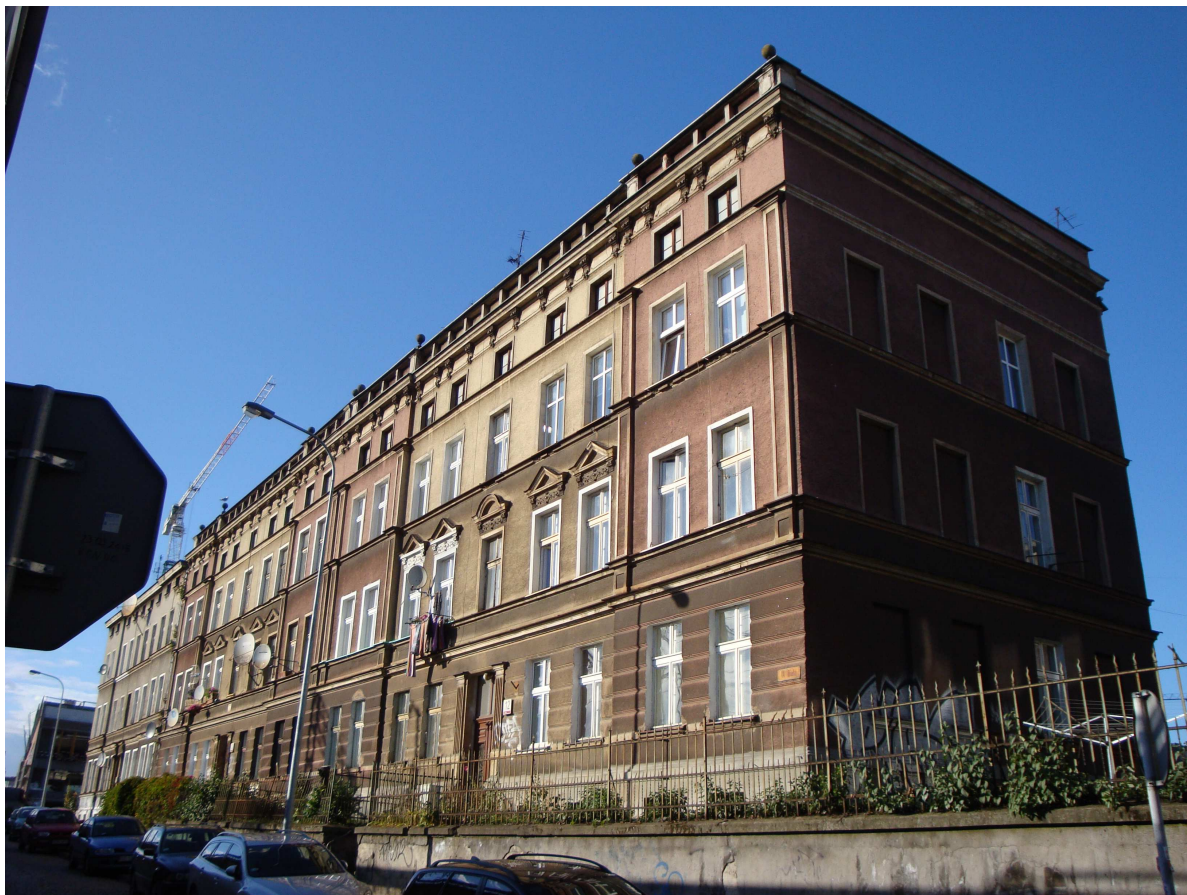
fot. 7 – widok od strony ulicy Białej elewacja osi A i B oraz szczytowa południowo-wschodnia fot. autor opracowania
