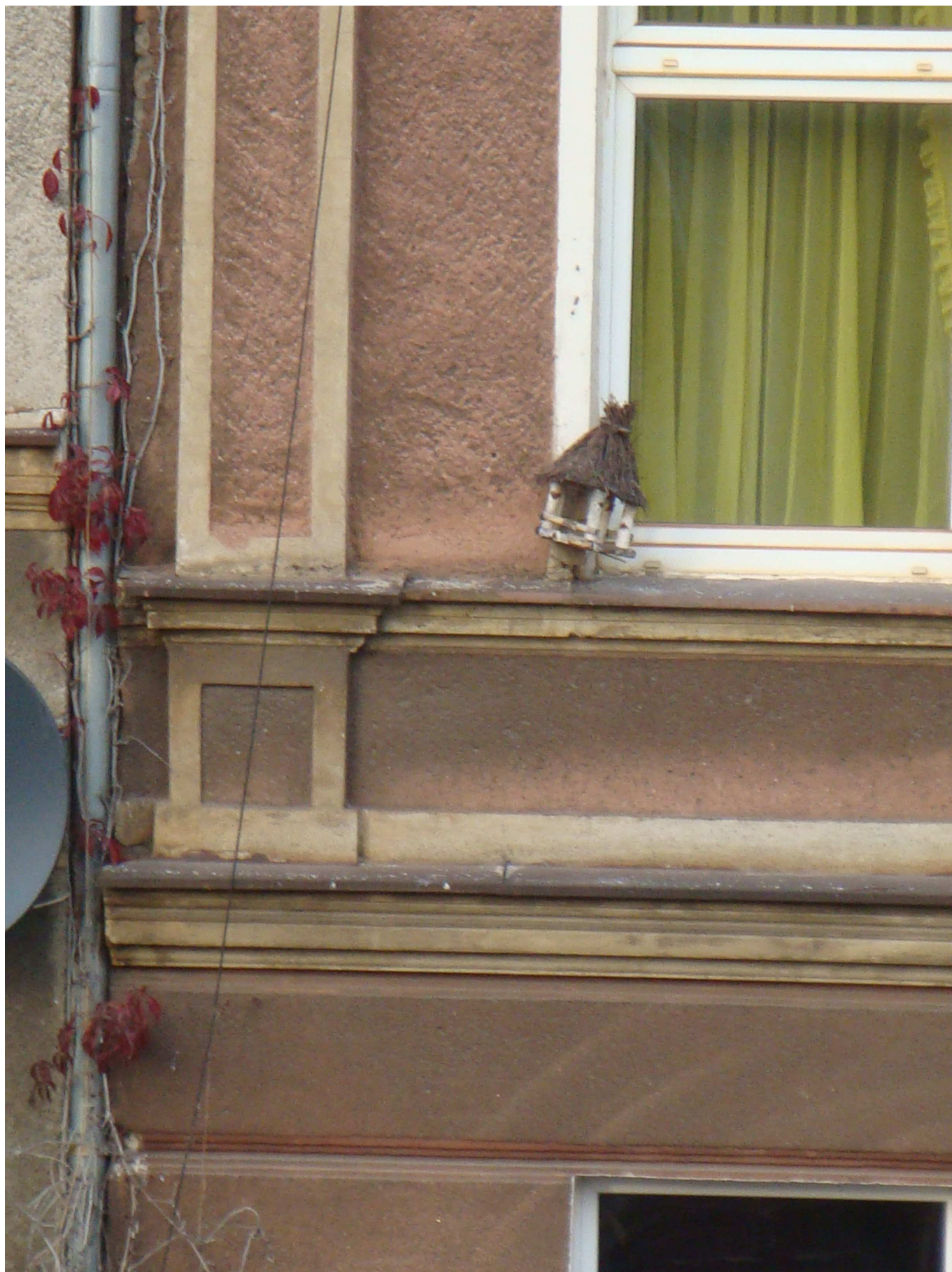
fot.16 – widok struktury tynku - elewacja od strony ulicy Białej elewacja osi B fot. autor opracowania
