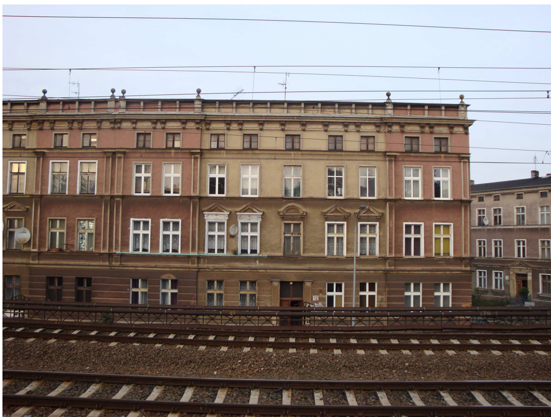
fot.12– widok od strony ulicy Białej elewacja osi A fot. autor opracowania
