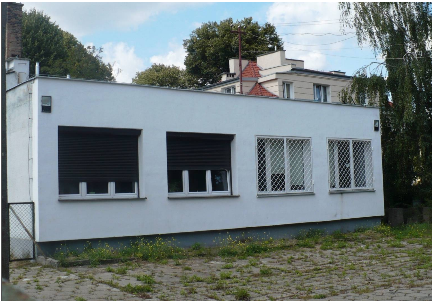
Fot. nr 4 Widok elewacji tylnej NE - część parterowa
