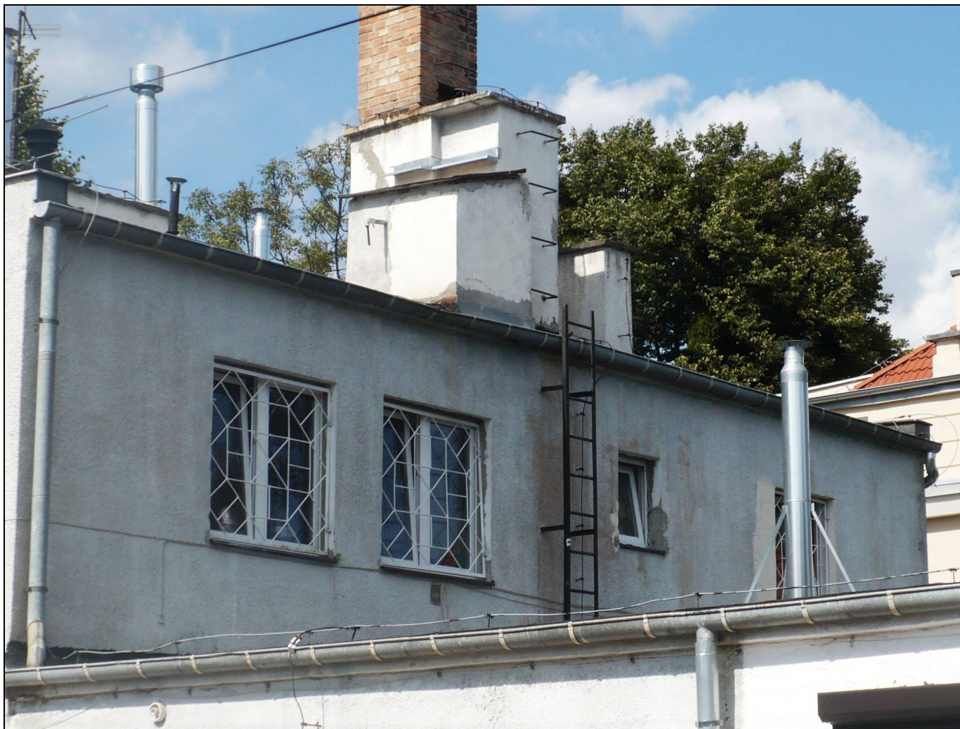
Fot. nr 5 Widok elewacji tylnej NE - część 2-kondygnacyjna
