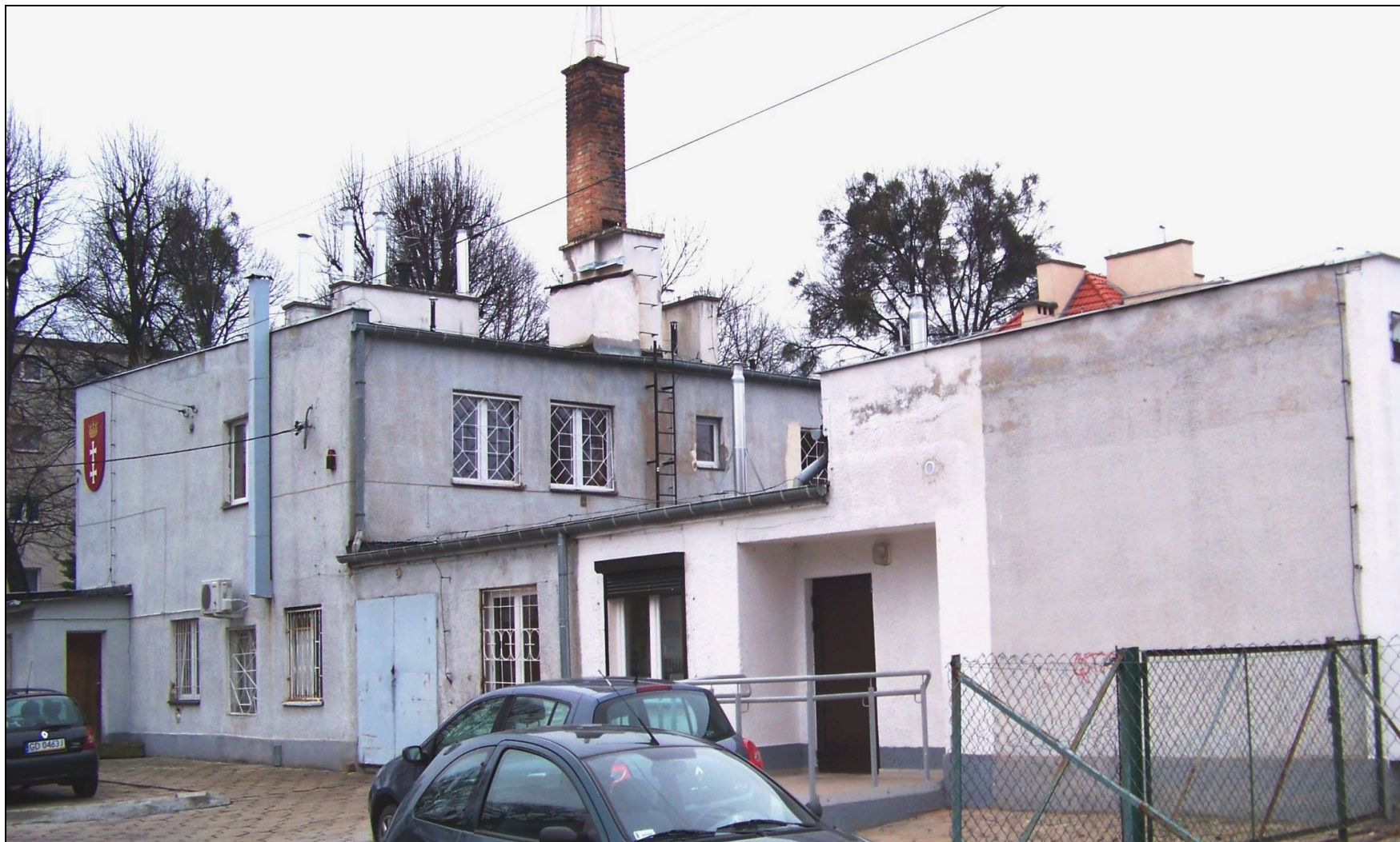
Fot. nr 3 Widok elewacji bocznej SE
