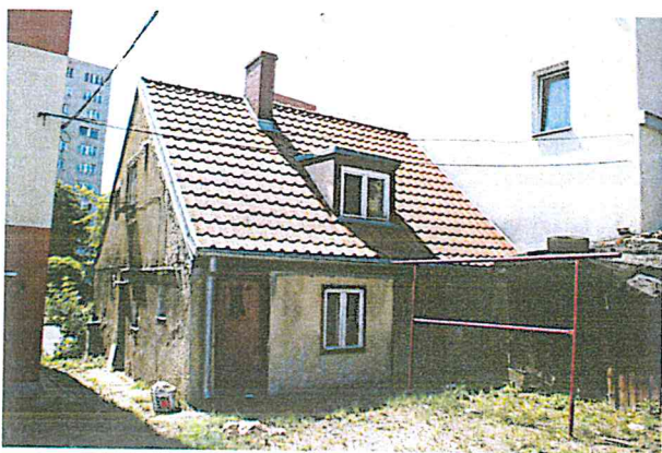
Widok na budynek mieszkalny od podwórza w stronę ul. Kartuskiej.
