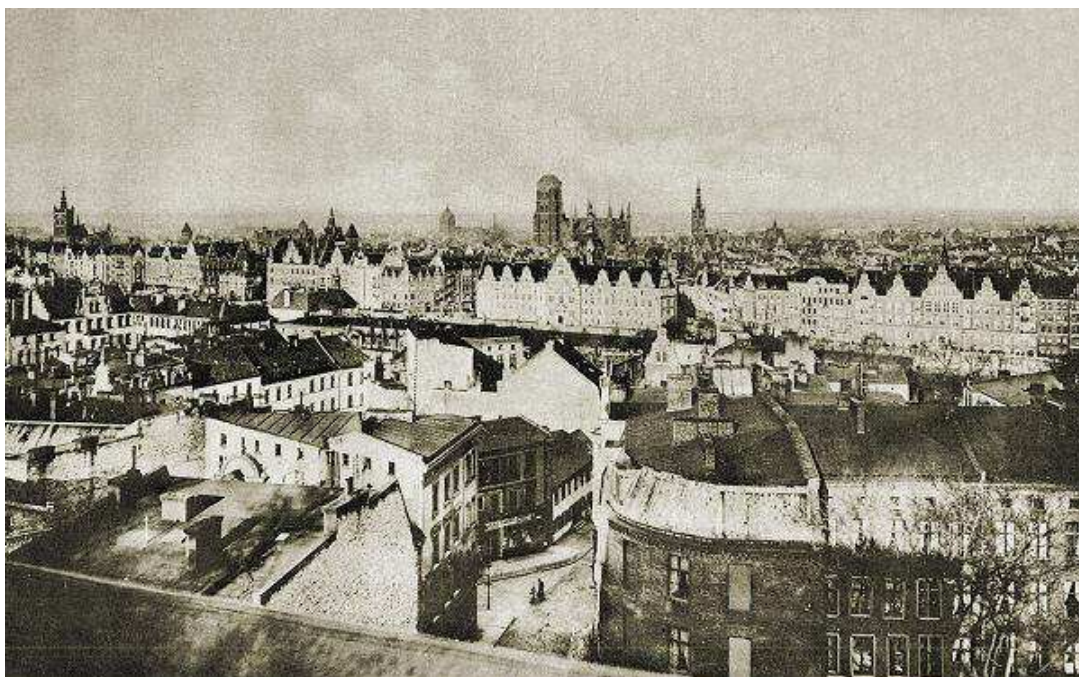
Fot. na pierwszym planie dach omawianej kamienicy – początek XX wieku
