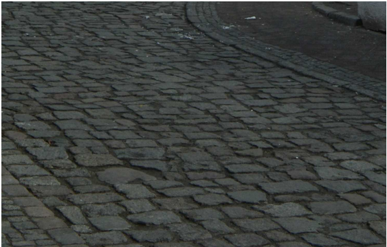
Kostka brukowa nieregularna, gr. 8cm, różnokolorowa, identyczna z nawierzchnią ul. Podgarbary
