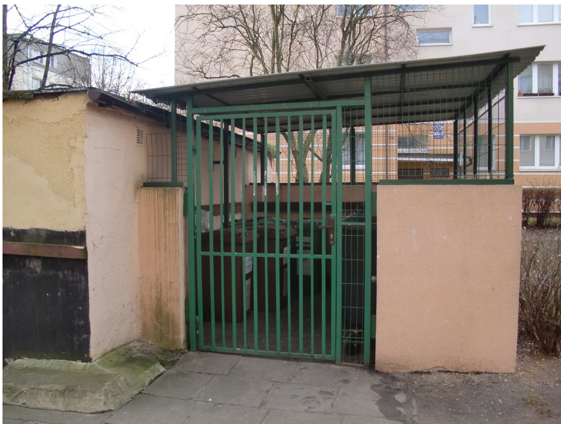
Istniejąca osłona śmietnikowa – przewiduje się przeniesienie wejścia na drugą stronę
