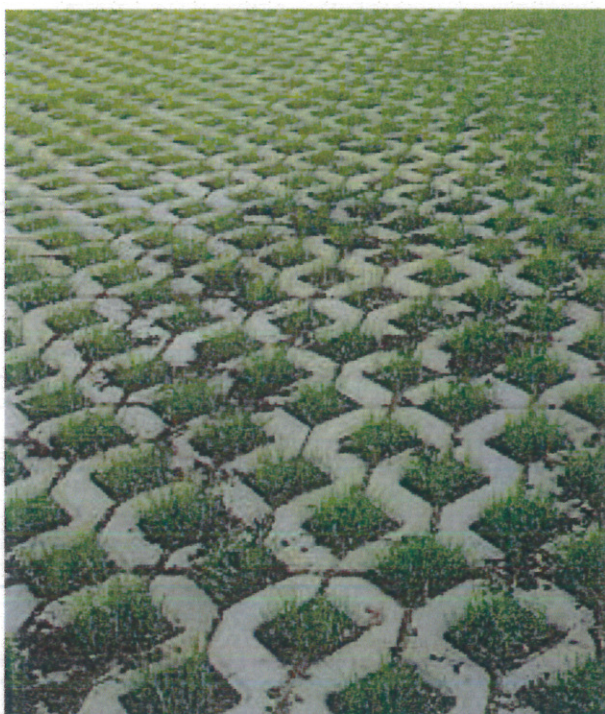
Rys. 8 Nawierzchnia z płyty meba, obsiana trawą
