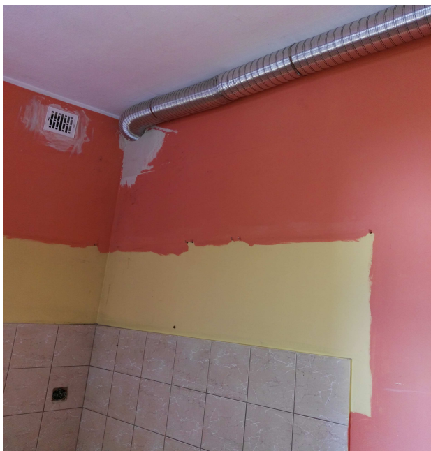
Istniejąca wentylacja grawitacyjna łazienki – rura spiro i kuchni
