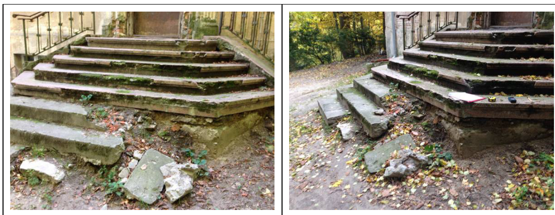
Zniszczona konstrukcja schodów pierwotnych i dobudowanych.
