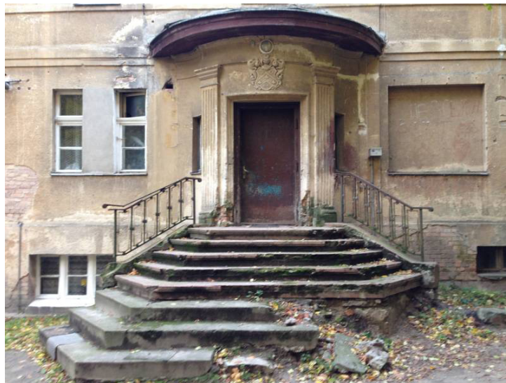
Widok frontowy schodów nr 1
