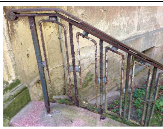
Widoczne zawilgocenie murów budynku i konstrukcji schodów.
