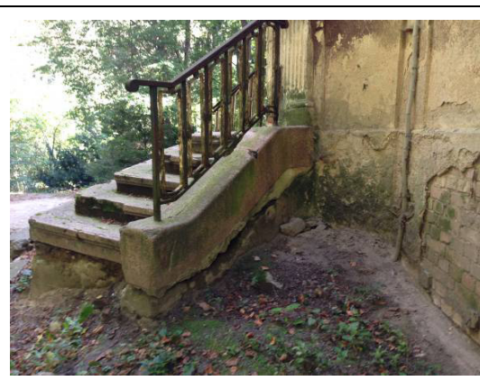
Widoczne zawilgocenie murów budynku i konstrukcji schodów.
