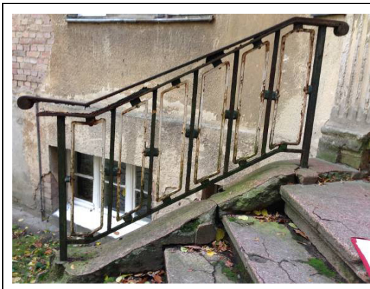
Zniszczona niekonserwowana oryginalna balustrada.
