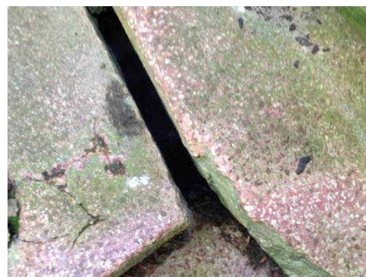
Widoczne odspojenia i szczeliny konstrukcji i warstw wykończeniowych z lastryka.
