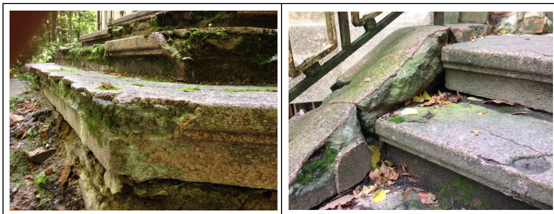
Zniszczona konstrukcja schodów pierwotnych i dobudowanych.
