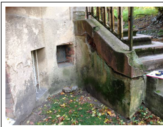
Widoczne zawilgocenie murów budynku i konstrukcji schodów.
