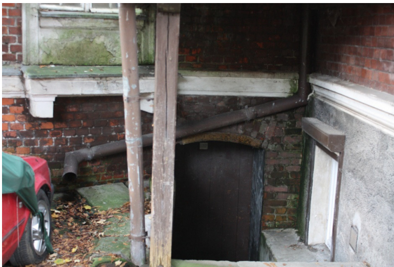
Fot. nr 44: Odprowadzenie wody opadowej.
