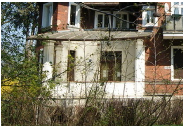
Fot. nr 46: Rok 2011 – widok na zadaszenie nad tarasem w chwili obecnej
