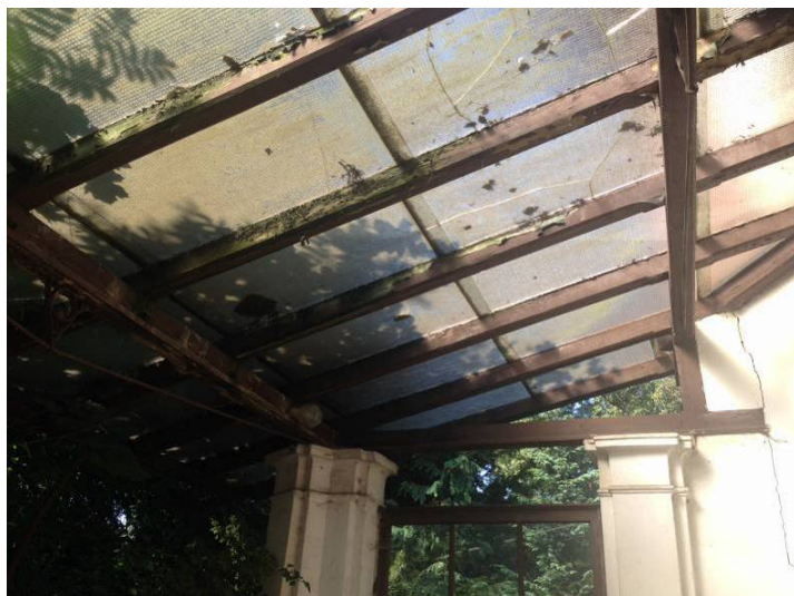
Fot. nr 48: Widok ogólny na dach nad tarasem
