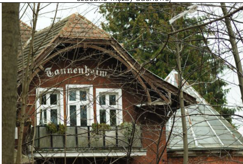
Fot. nr 20: Widok na szczyt z półkolistą oprawą ciesielską okapu dachu. Widoczny oryginalny napis „Tannenheim”
