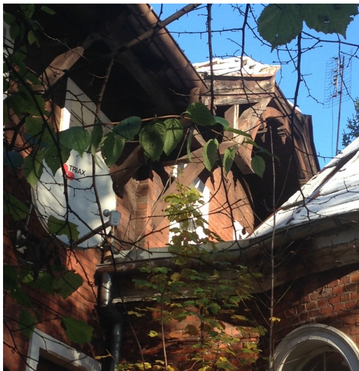
Fot. nr 32 i 33. Widok na miejsce połączenia dachu nad rotundą z dachem nad łącznikiem
