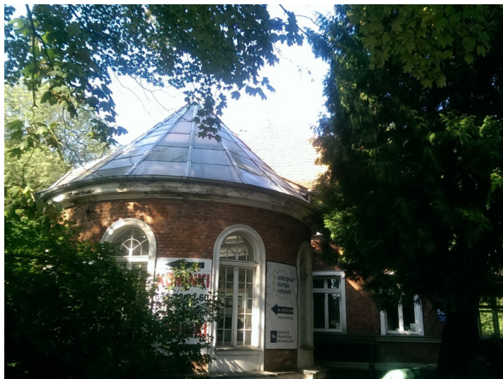
Fot. 25 Dach nad rotundą – widok od strony południowej
