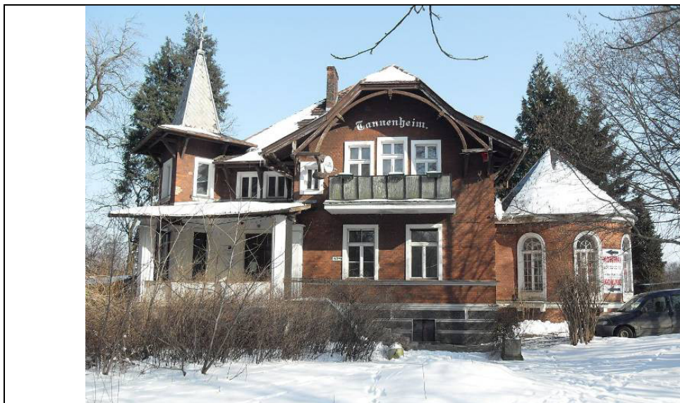
Fot. nr 18: Widok na dachy od strony zachodniej
