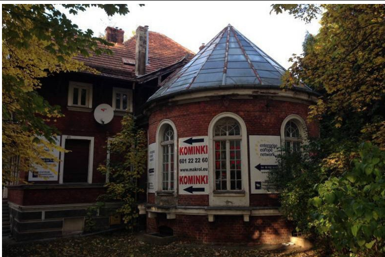
Widok na rotundę i jej zewnętrzne zadaszenie od strony południowo - zachodniej
