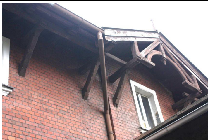
Fot. 7. Elewacja wschodnia
