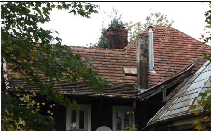
Fot. 19 Dach budynku głównego – widok od strony południowej, kominy i elementy ozdobne wieżby dachowej
