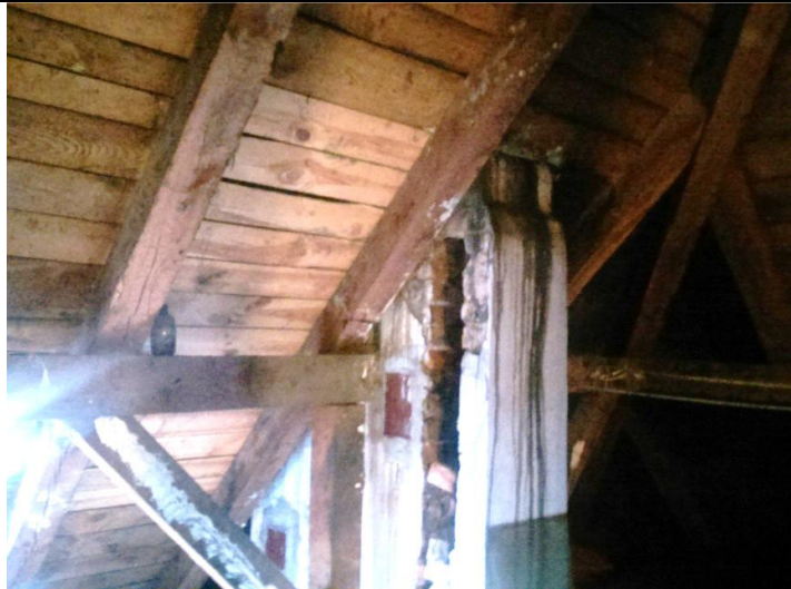
Fot. 21 Kominy murowane widok w przestrzeni strychu
