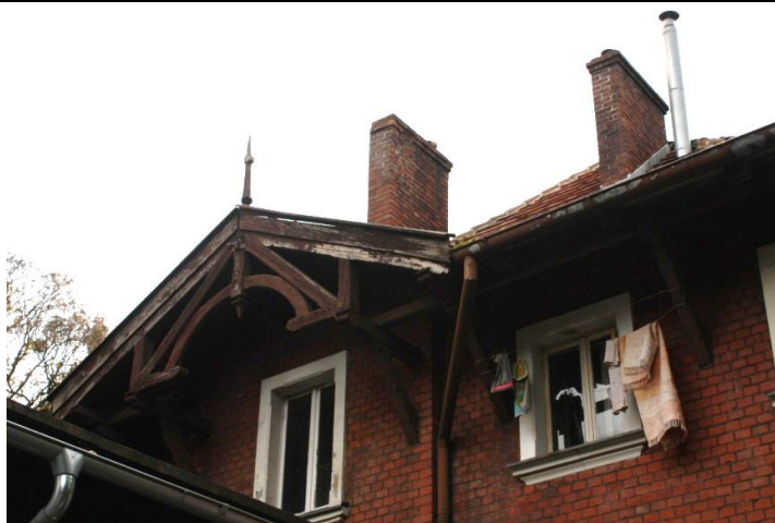
Fot. 8. Elewacja wschodnia
