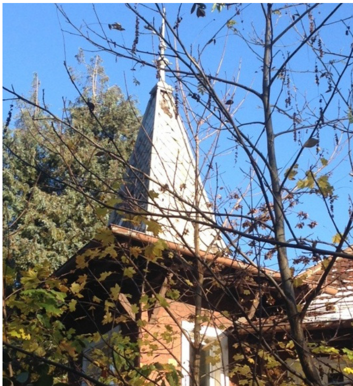
Fot. nr 22: Hełm nad ryzalitem kryty metalowymi płytkami
