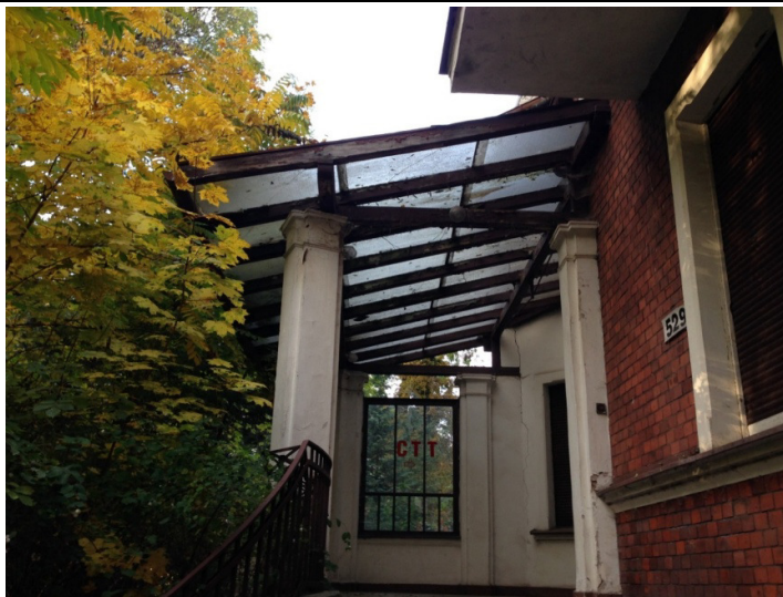
Fot. 47 Dach nad tarasem widok ogólny.
