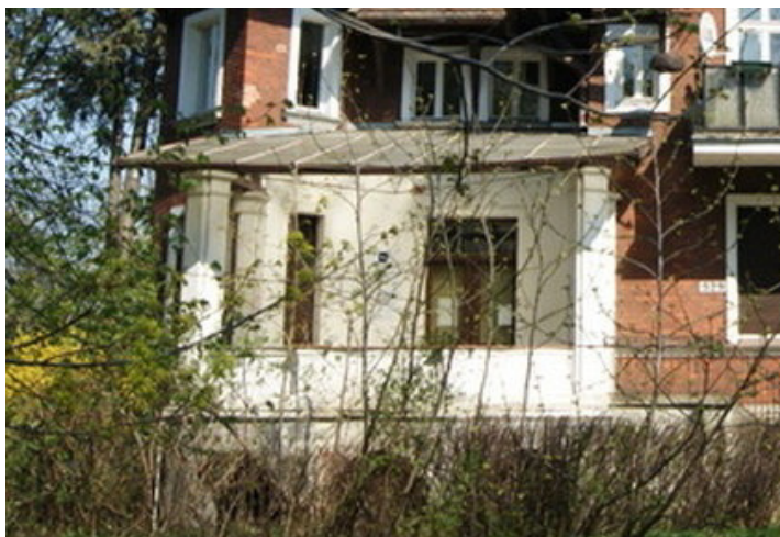
Widok na zadaszenie nad tarasem w chwili obecnej
