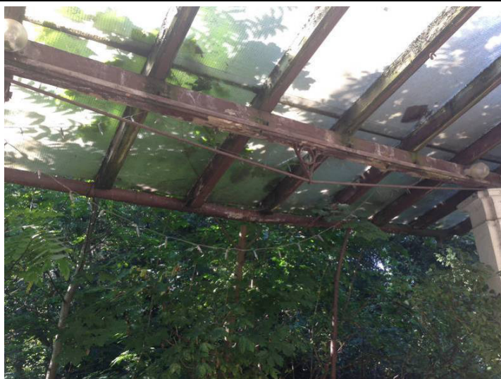
Fot. nr 53: Widok w kierunku części okapowej dachu z opuszczoną rynną
