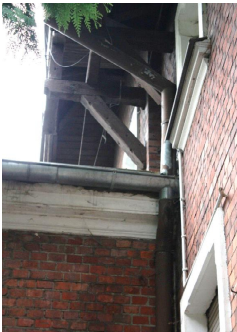
Fot. 3 Rury spustowe na połączeniu rotundy z budynkiem głównym od strony
