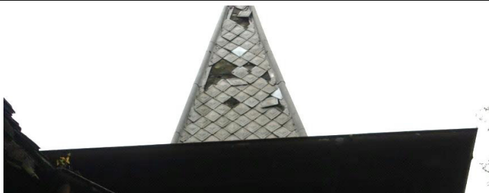
Fot. 23 Elewacja zachodnia – hełm nad ryzalitem, ubytki w pokryciu
