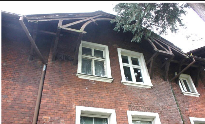
Fot. 10. Elewacja północna z widocznym przemurowaniem
