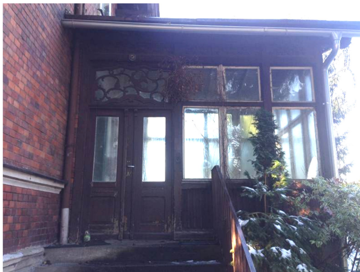
Fot. 56 Ganek wejściowy – widok ogólny
