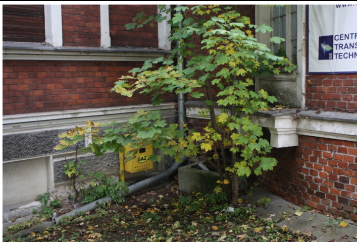
Fot. 5 Rury spustowe na elewacji południowej od strony zachodniej
