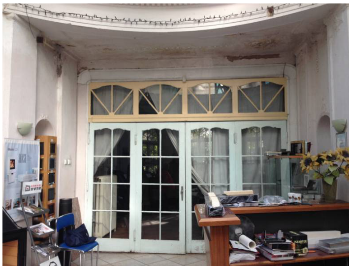
Widok na wnętrze łącznika pomiędzy rotundą a pozostałą częścią budynku. Otwierana na całą szerokość przejścia oryginalna ściana działowa o secesyjnym wystroju
