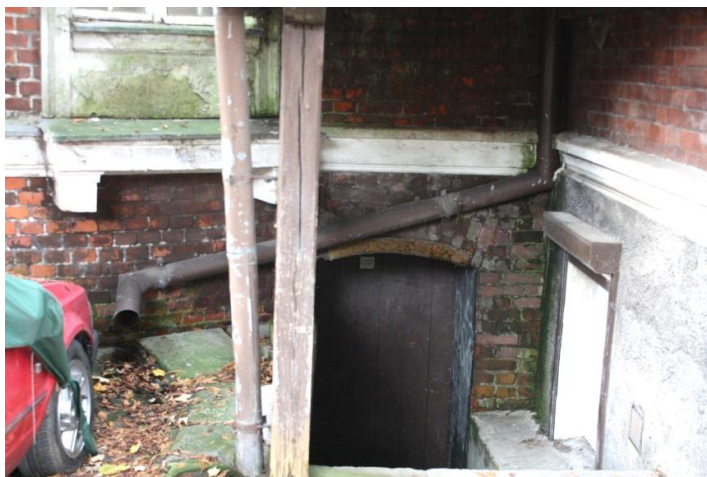
Fot. 4 Rury spustowe na połączeniu rotundy z budynkiem głównym od strony wschodniej – odprowadzenie wody gruntowej w strefie budynku
