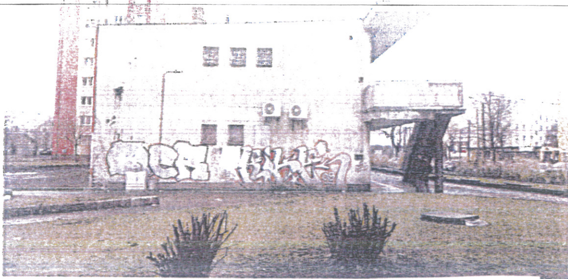
Fot.3 Widok ogólny od strony wsch.
