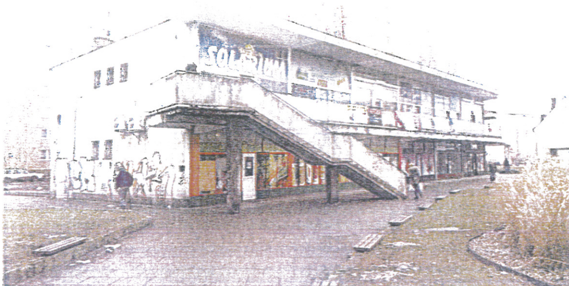
Fot.1 Widok ogólny od strony pn-wsch
