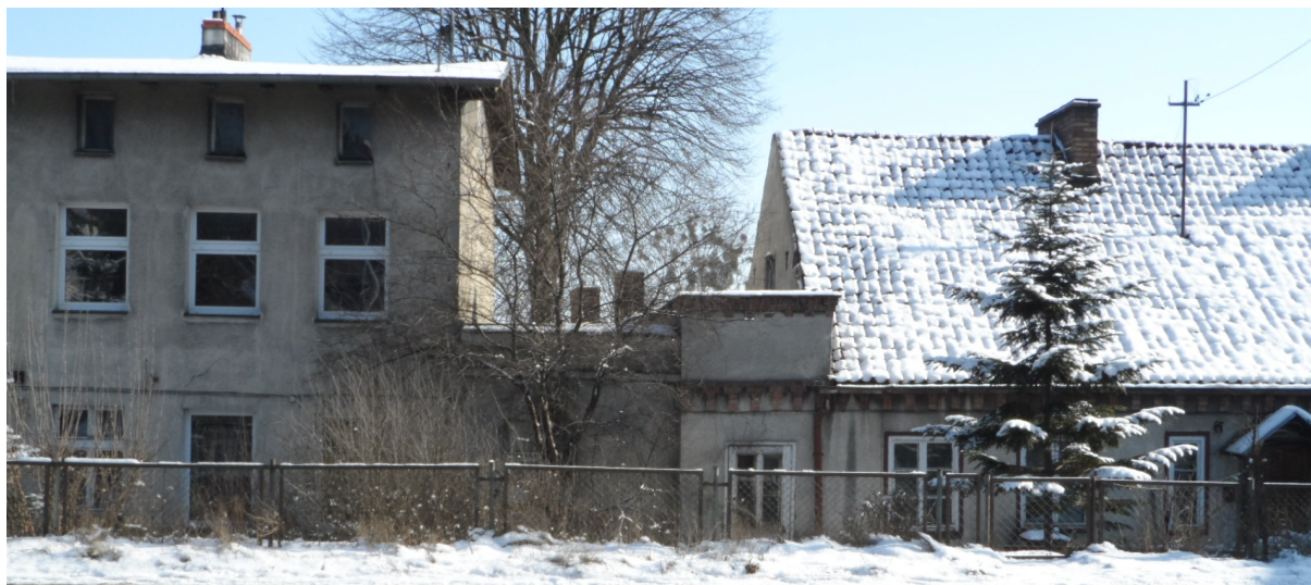
Elewacje zachodnie, od strony ul. Trakt Św. Wojciecha – po lewej budynek pod nr 175, po prawej budynek pod nr 177, w środku przybudówka
