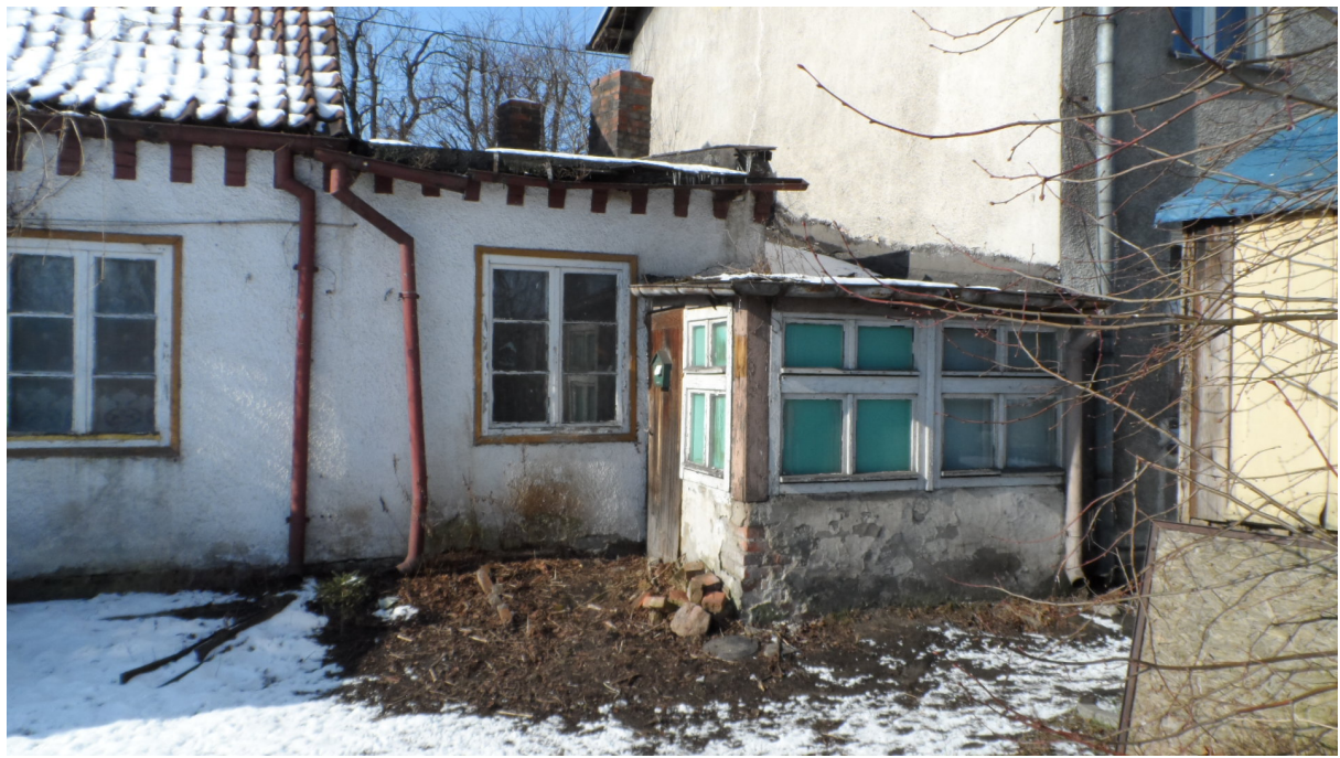
Widok przybudówki od strony wschodniej (od podwórza) – po lewej stronie budynek pod nr 177, po prawej stronie widoczna ściana szczytowa budynku pod nr 175
