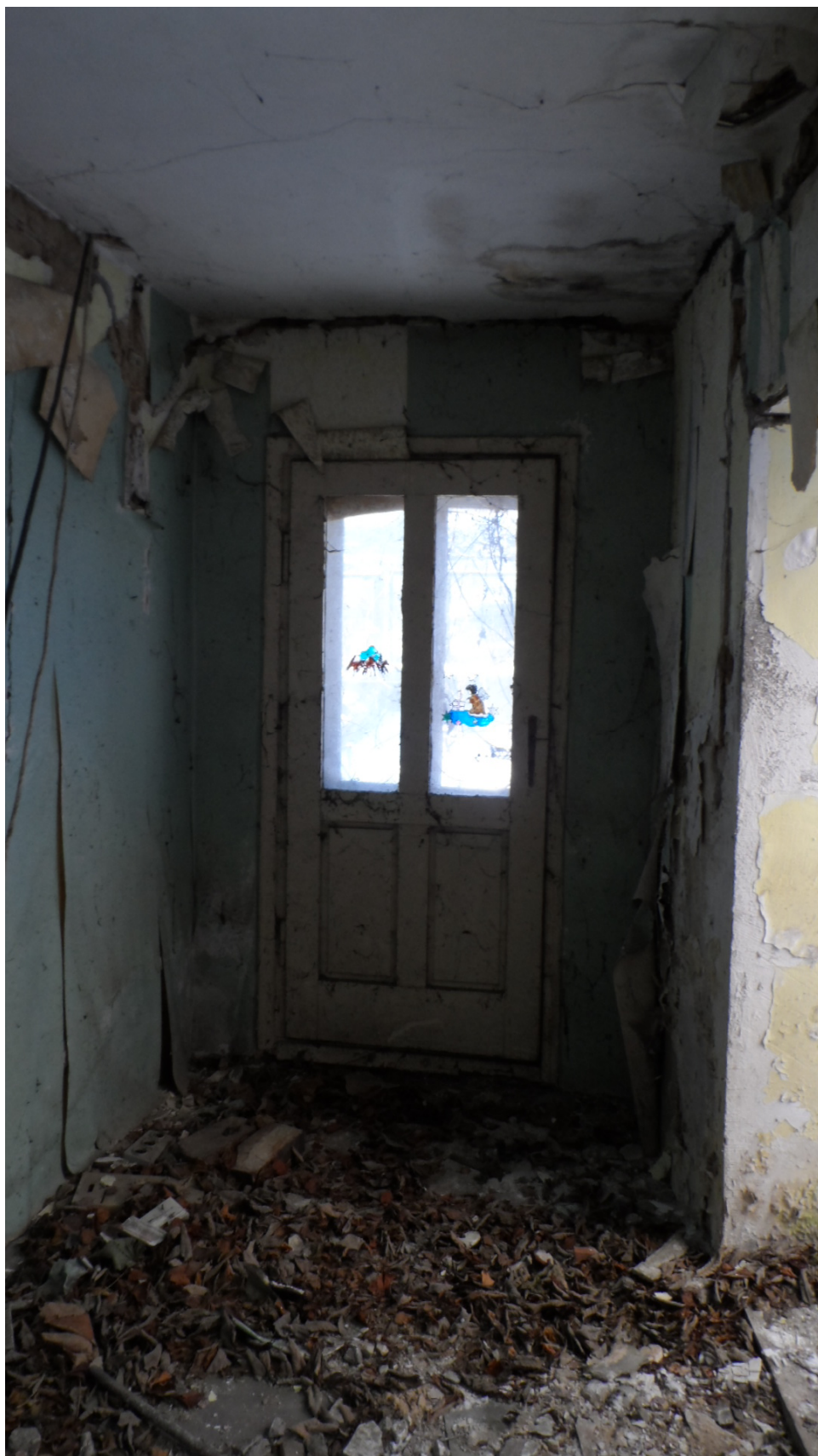
Widok na drzwi wejściowe od strony zachodniej(pom. 01)
