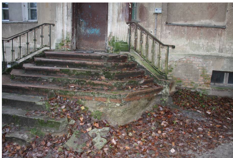
Fot. nr 20. Schody zewnętrzne frontowe od strony północnej – widok ogólny
