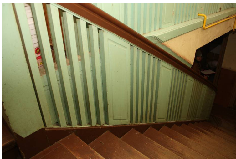
Fot. nr 25. Schody wewnętrzne – bieg wiodący z parteru na piętro
