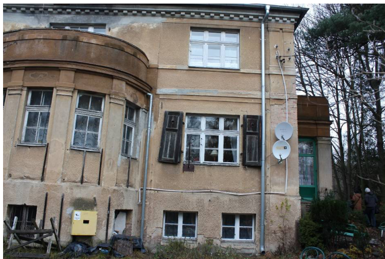
Fot. nr 11. Elewacja południowa – drewniana okiennica
