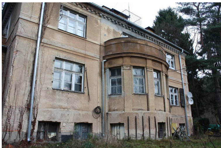
Fot. nr 9. Elewacja południowa – widok ogólny
