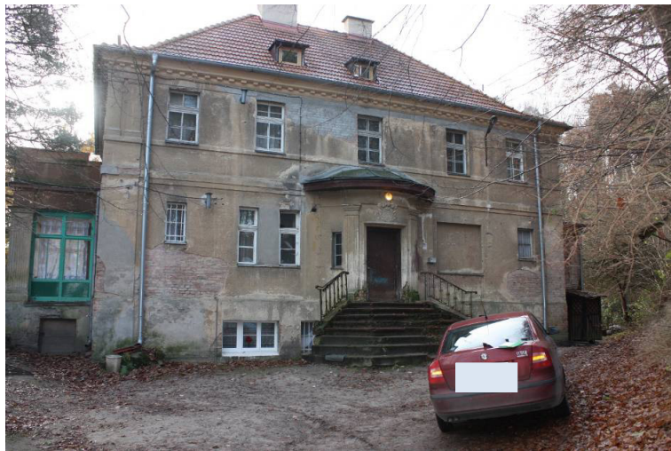
Fot. nr 1. Elewacja frontowa – północna – widok ogólny
