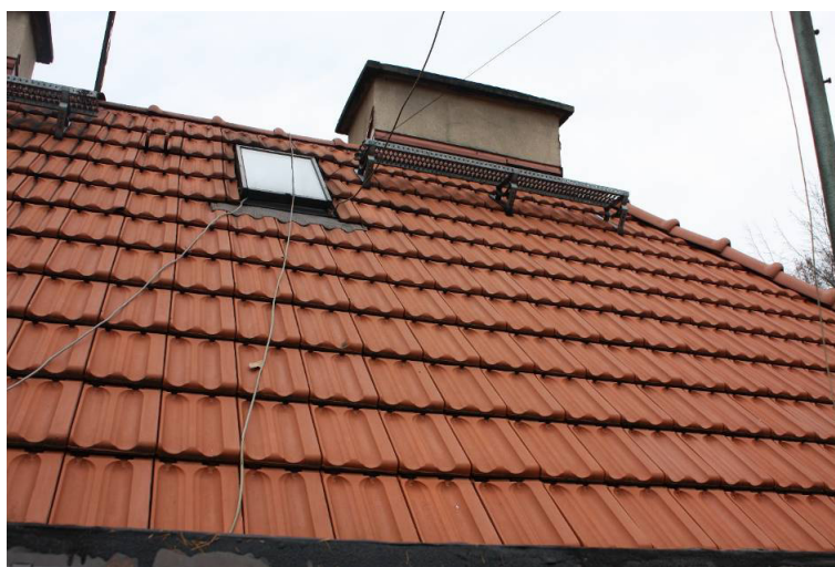
Fot. nr 18. Pokrycie dachu – widok fragmentu południowej połaci
