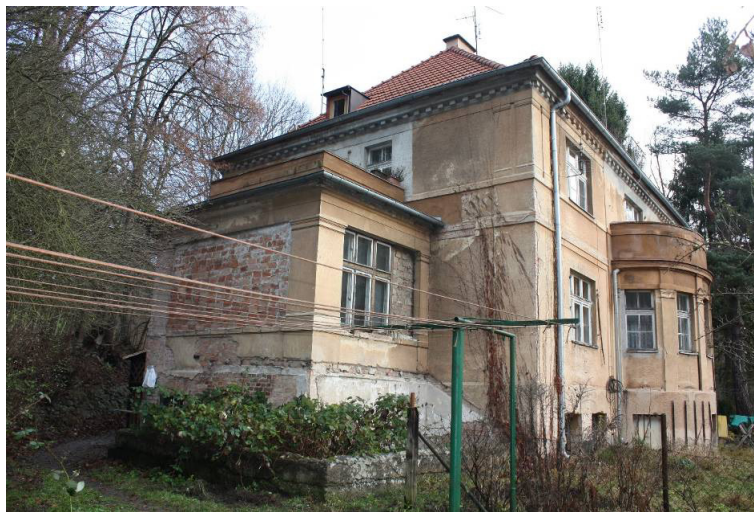
Fot. nr 6. Elewacja zachodnia – widok ogólny
