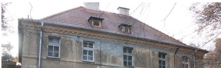
Fot. nr 15. Dach budynku – widok ogólny od strony północnej
