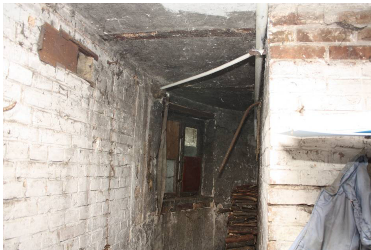
Fot. nr 14. Belki stalowe stropu nad piwnicą
