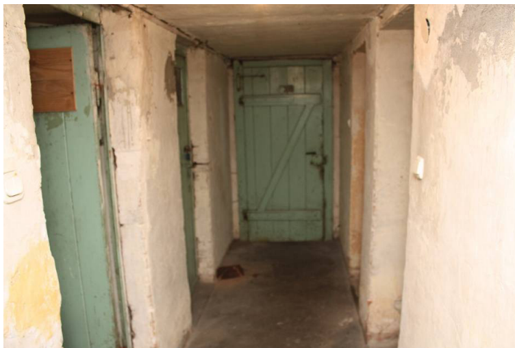
Fot. nr 26. Korytarz w piwnicy – widok ogólny
