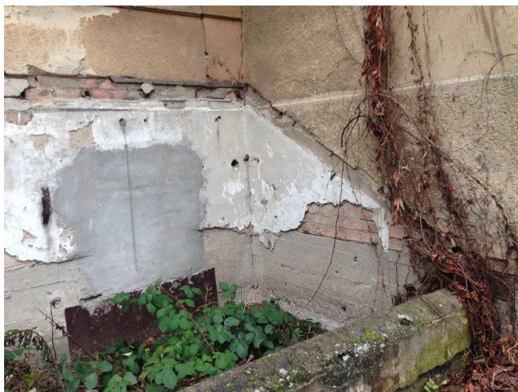
Fot. nr 8. Elewacja zachodnia – pozostałości po szklarni
