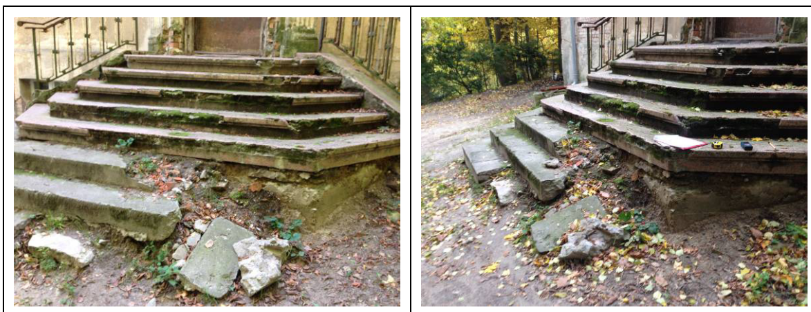
Zniszczona konstrukcja schodów pierwotnych i dobudowanych.
