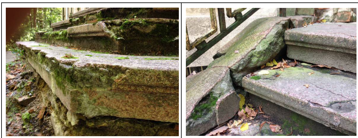
Zniszczona konstrukcja schodów pierwotnych i dobudowanych.
