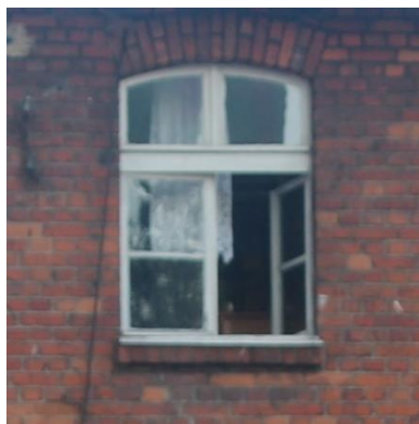
Zachowane okno klatki schodowej
