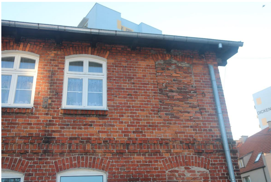
28. Gdańsk, ul. Karola Dickensa 2. Elewacja północno – wschodnia. Fragment górnej kondygnacji z widocznym zamurowaniem otworu okiennego.
