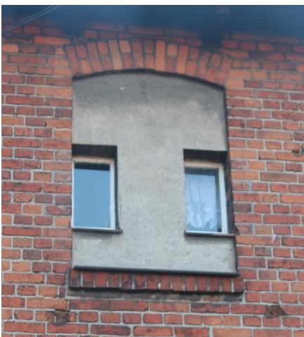
Detale architektoniczne budynku: otynkowany otwór okienny elewacji oraz fryz elewacji
