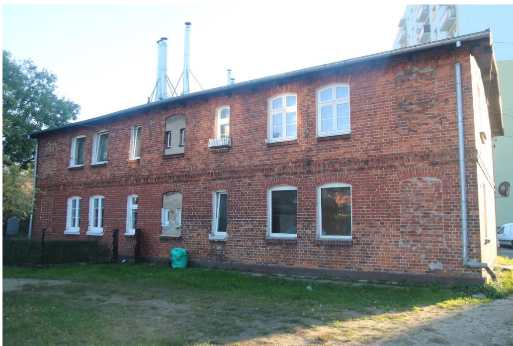
23. Gdańsk, ul. Karłowicza 2. Elewacja północno – wschodnia. Widok ogólny od podwórza.
