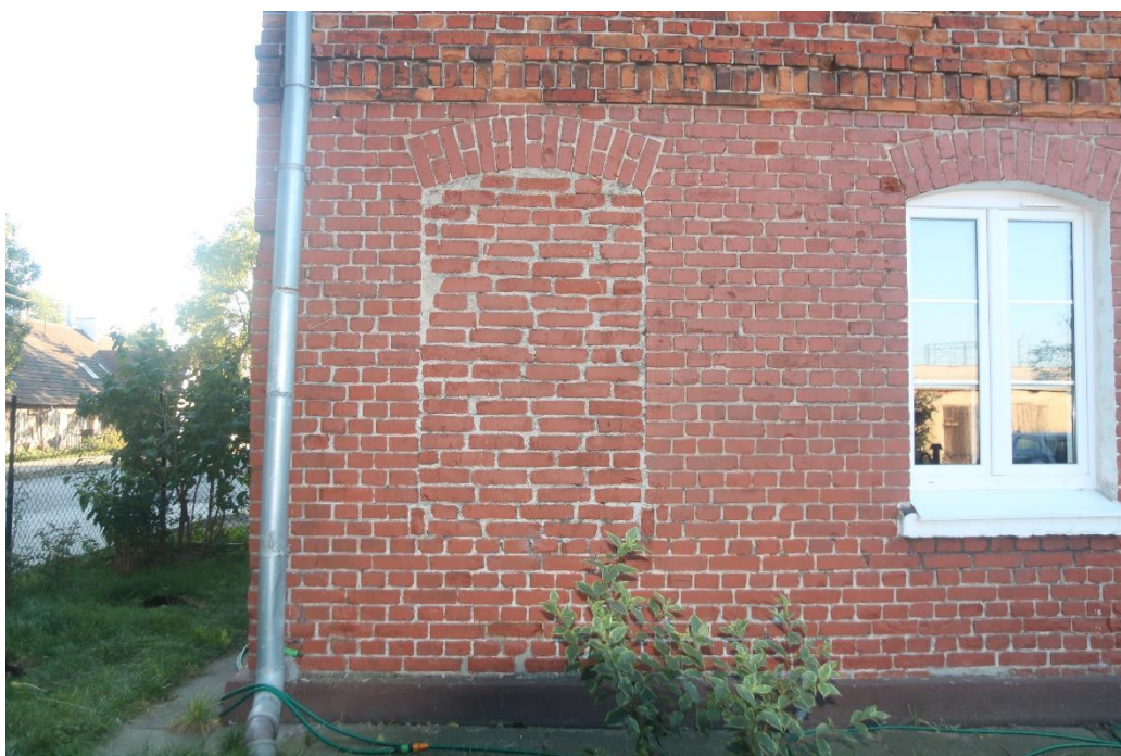
24. Gdańsk, ul. Karłowicza 2. Elewacja północno – wschodnia. Fragment parteru z wtórnie pomalowanym na ciemnoczerwono licem muru.
