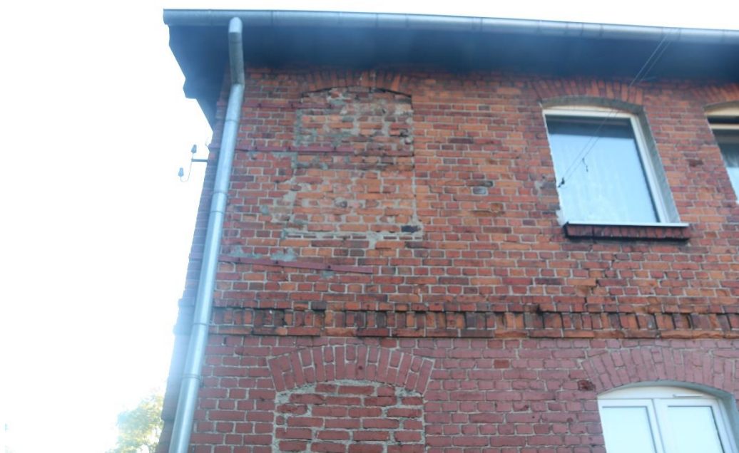
25. Gdańsk, ul. Karola Dickensa 2. Elewacja północno – wschodnia. Widoczne sklamrowanie narożnika, wtórnie zamurowane otwory okienne.
