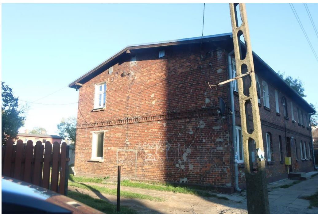
18. Gdańsk, ul. Karola Dickensa 2. Elewacja północno – zachodnia. Widok ogólny od strony ulicy Karola Dickensa.
