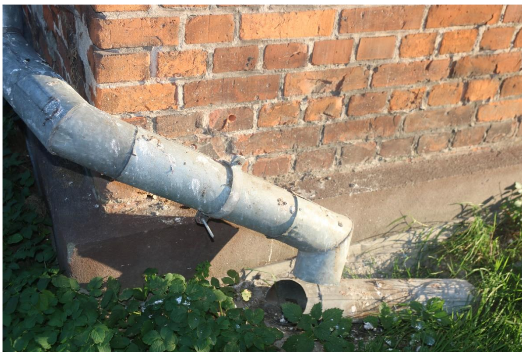
22. Gdańsk, ul. Karola Dickensa 2. Elewacja północno – zachodnia. Widoczna rura spustowa i sposób odprowadzenia wody opadowej.
