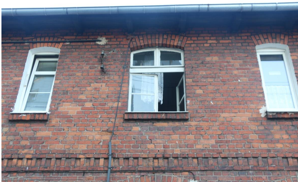
30. Gdańsk, ul. Karola Dickensa 2. Elewacja południowo – zachodnia. Zachowane historyczne okno klatki schodowej.
