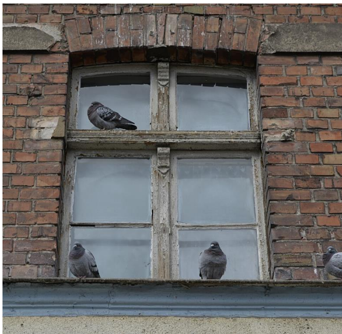
Okno budynku znajdującego się przy ul. Jana Brzechwy 2, w pobliżu ulicy Karola Dickensa.
