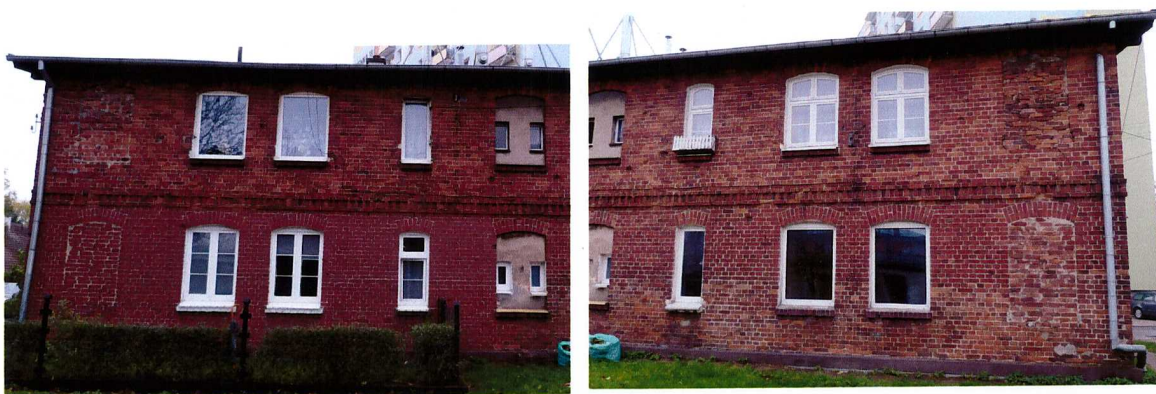
Fot.2 Elewacja tylna północno-wschodnia – widok ogólny
