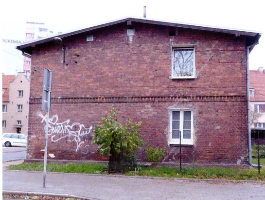
Fot.3 Elewacja szczytowa południowo-wschodnia
