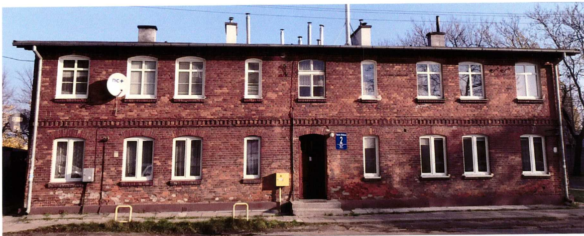
Fot.1 Elewacja frontowa południowo-zachodnia – widok ogólny
