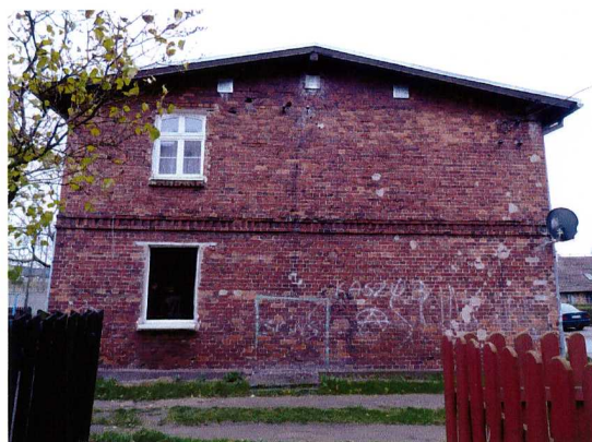
Fot.4 Elewacja szczytowa północno-zachodnia
