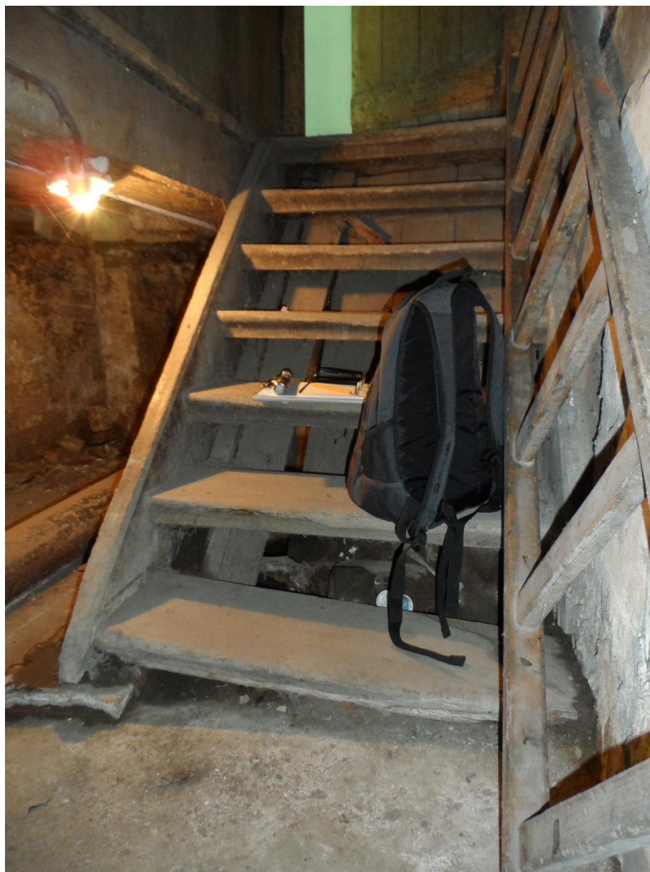
Schody z podpiwniczenia na parter
