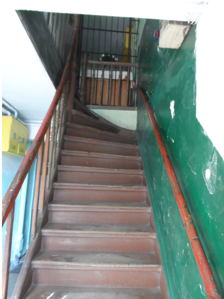
Drewniane schody z parteru na piętro
