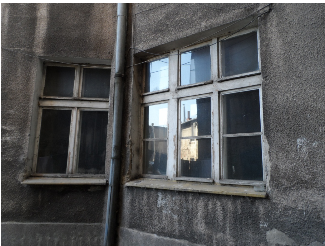
Fot. nr 6 - Okna mieszkania nr 17 – po lewej kuchenne, po prawej pokojowe
