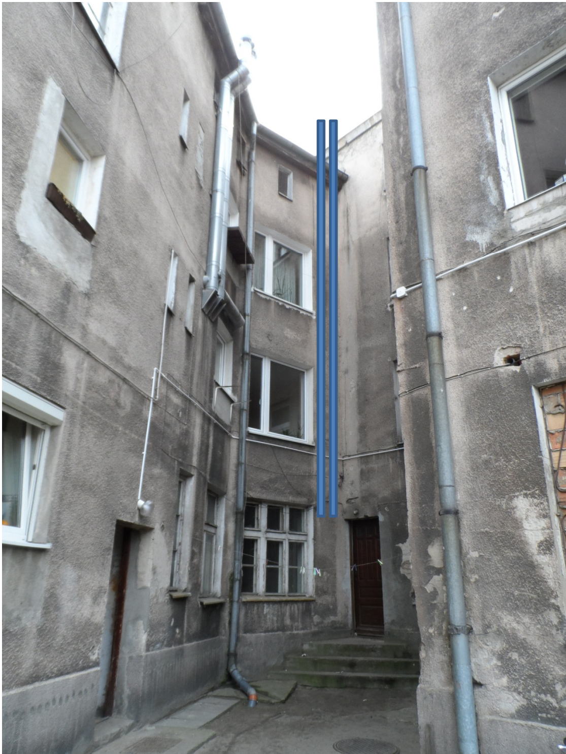
Fot. nr 7 -Tylne elewacja budynku – wewnętrzny „dziejnec” powstały w załamaniu połączenia brył budynku.
