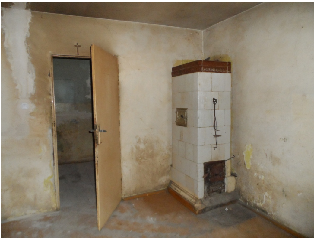
Fot. nr 5 - Pokój, wejście z kuchni; piec kaflowy do rozbiórki
