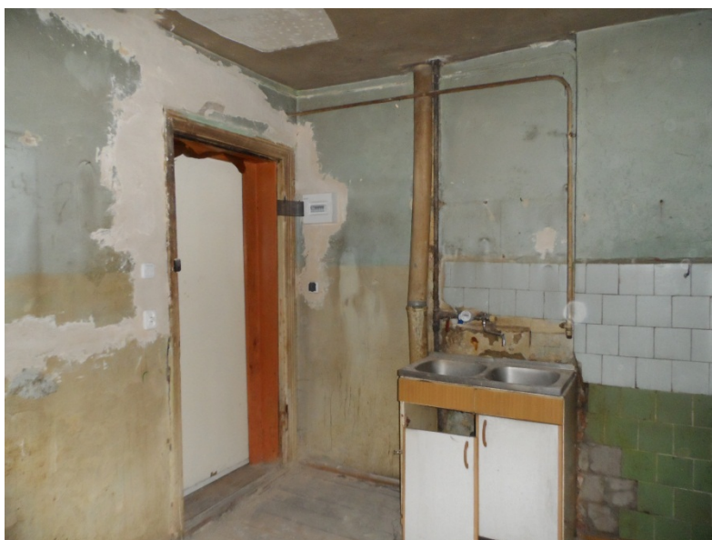
Fot. nr 2 - Kuchnia, drzwi wejściowe do mieszkania
