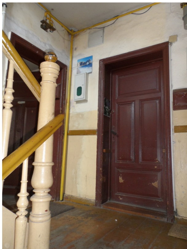
Klatka schodowa – po lewej wejście do przedpokoju mieszkania nr 7, po prawej drzwi do pomieszczenia nr 06 mieszkania nr 7
