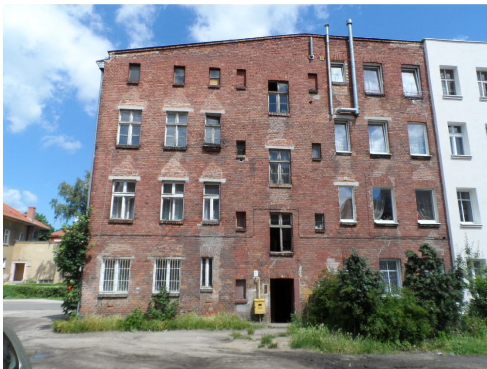
Tylne ściany budynku – trzy okna od lewej strony w poziomie 2 piętra należą do mieszkania nr 7
