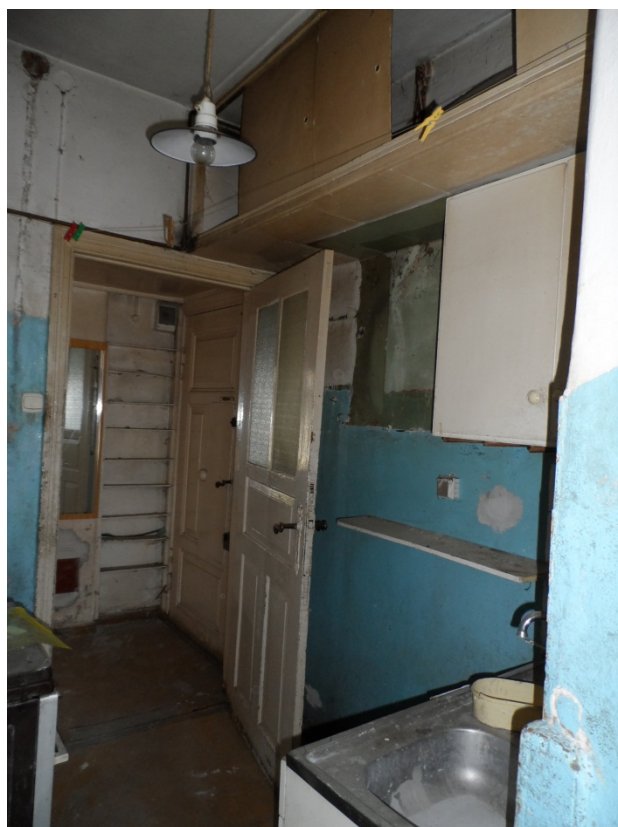
Kuchnia – widok na wejście z przedpokoju
