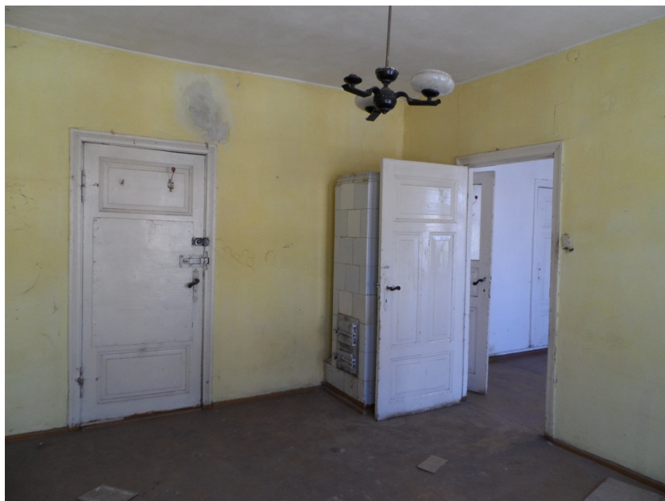
Pokój nr 06 – z lewej strony drzwi na klatkę schodową
