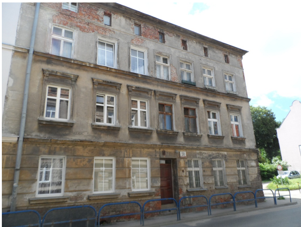
Ściana frontowa budynku – cztery okna z prawej strony na 2 piętrze należą do mieszkania nr 7
