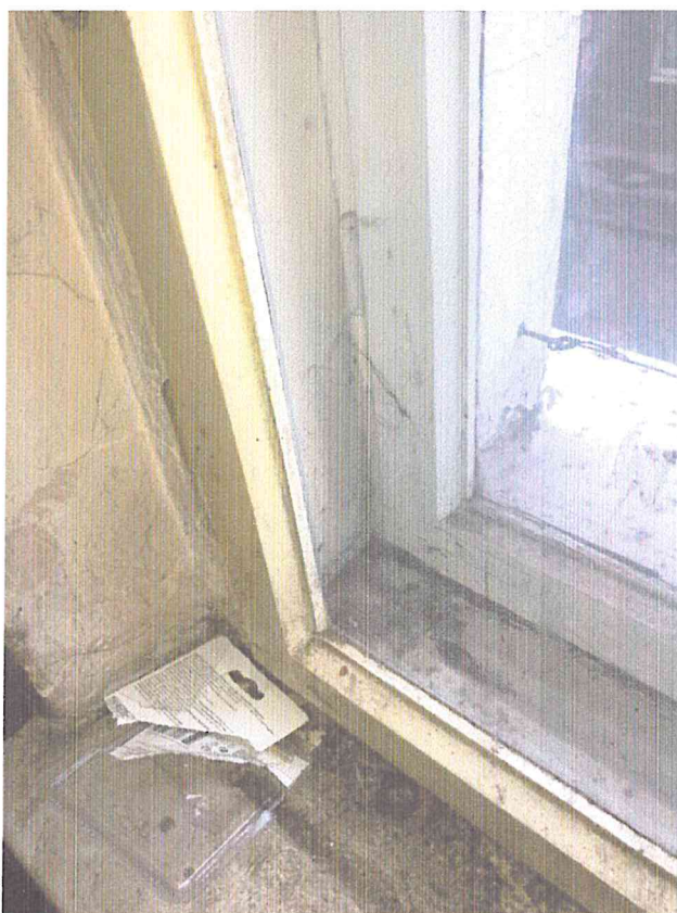
Fot. 4. Szczegół narożnika okna od wewnątrz lokalu
