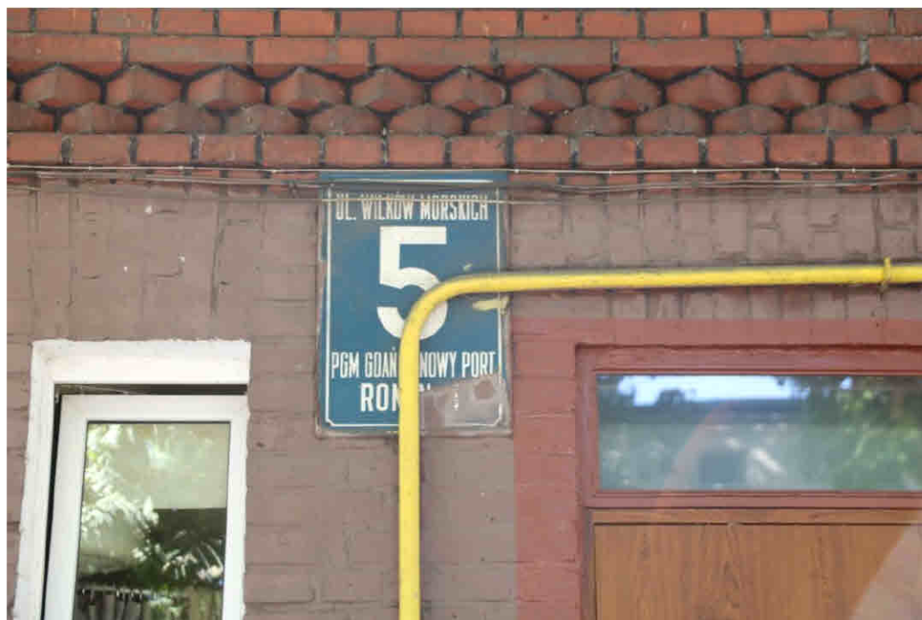
2. Gdańsk, ul. Wilków Morskich 5. Elewacja wschodnia. Widoczne instalacje przebiegające na elewacji, współcześnie pomalowane lico muru w kolorze czerwonym, ościeża otworów okiennych i drzwiowych.
