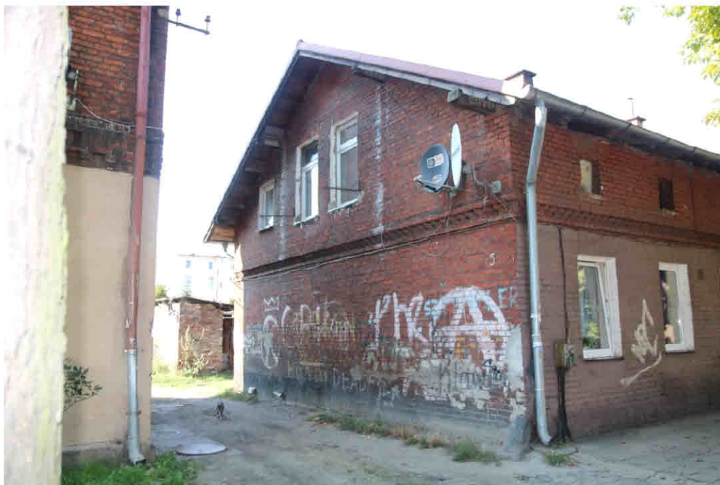
11. Gdańsk, ul. Wilków Morskich 5. Elewacja południowa. Widok ogólny od strony ul. Wilków Morskich.
