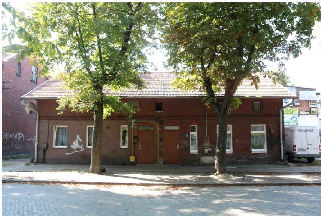
1. Gdańsk, ul. Wilków Morskich 5. Elewacja wschodnia; widok ogólny od strony ulicy Wilków Morskich.
