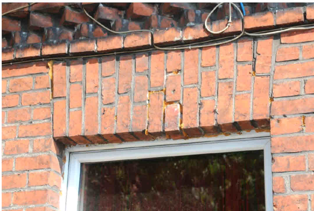
17. Gdańsk, ul. Wilków Morskich 5. Elewacja zachodnia. Widoczne zniszczenia nadproża otworu okiennego, poluzowane cegły, pionowe spękania, czarne nawarstwienia na ceglach fryzu.
