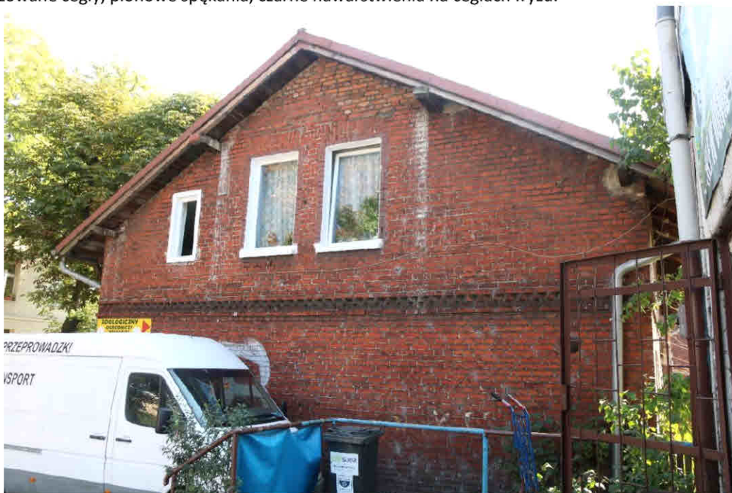
17. Gdańsk, ul. Wilków Morskich 5. Elewacja zachodnia. Widoczne zniszczenia nadproża otworu okiennego, poluzowane cegły, pionowe spękania, czarne nawarstwienia na ceglach fryzu.
