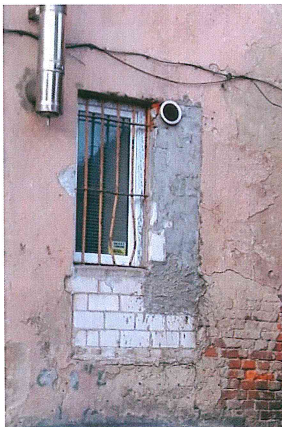
19,20. Przemurowania w obrębie otworów okiennych elewacji od strony podwórza
