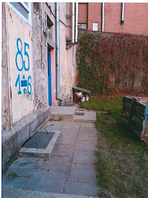
23,24. Szczelne i nieprzepuszczalne dla wody powłoki stykające się z cokołem budynku oraz niewłaściwie odprowadzenie wody deszczowej przyczynia się do zawilgocenia murów piwnicznych
