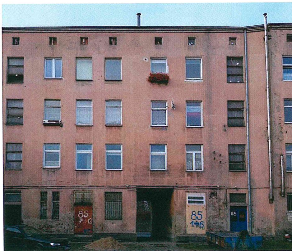
5. Widok na elewację od strony podwórza (od otworu przejazdu po prawej stronie)
