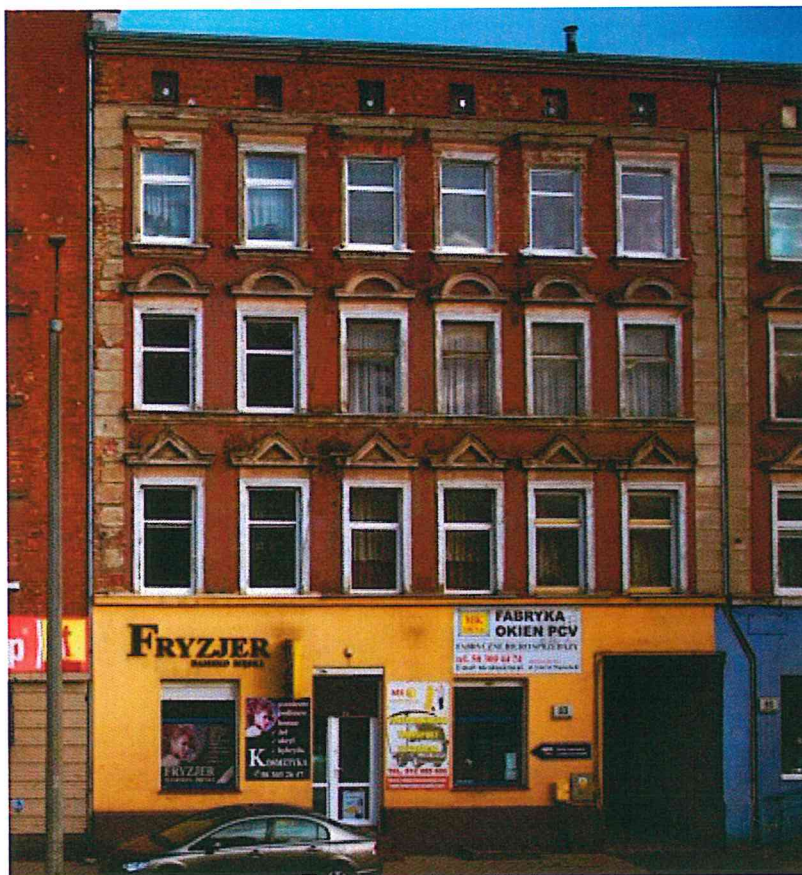
4. Widok na elewację frontową
