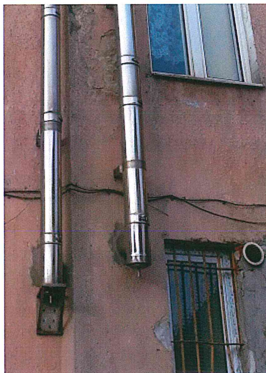
18. Wtórne otwory pod instalacje wentylacji
