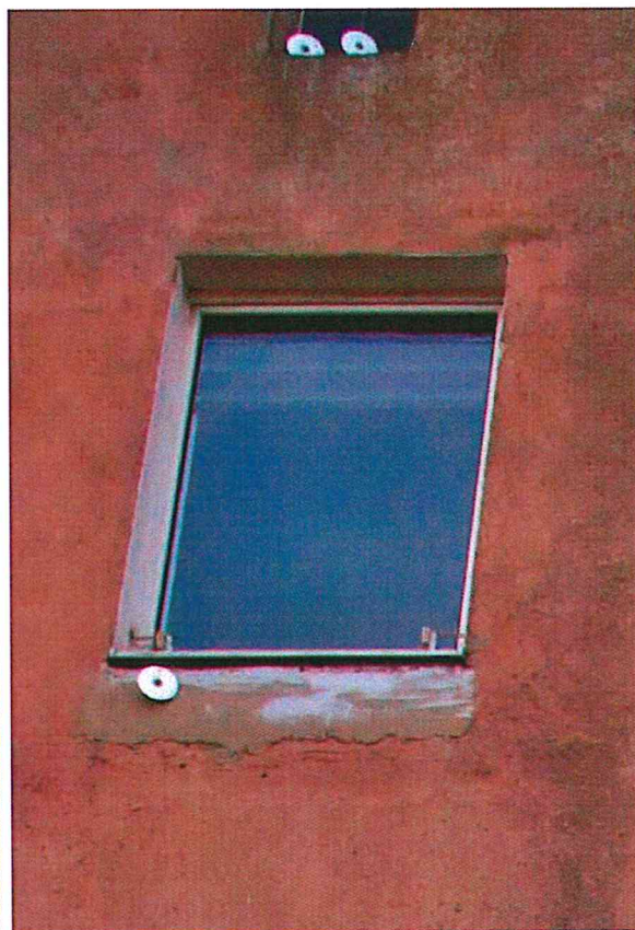
19,20. Przemurowania w obrębie otworów okiennych elewacji od strony podwórza
