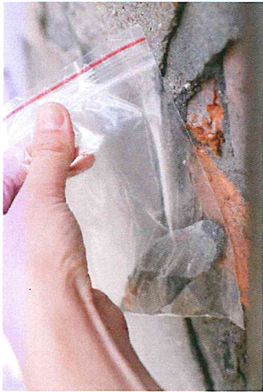
Miejsce pobrania próbki – elewacja frontowa na poziomie parteru
