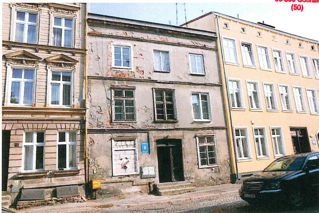
1. Gdańsk, Plac Wałowy 9, elewacja północno-zachodnia. Widok ogólny od strony Placu Wałowego.
