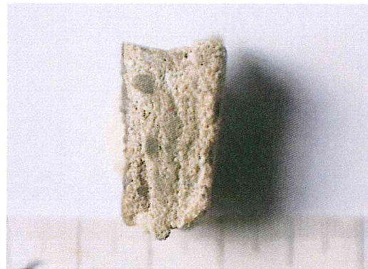
Próbka tynku pobrana spod opaski okiennej
