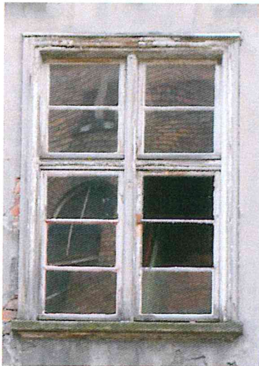
Fot. Zachowane pierwotne okno klatki schodowej pierwszego piętra
