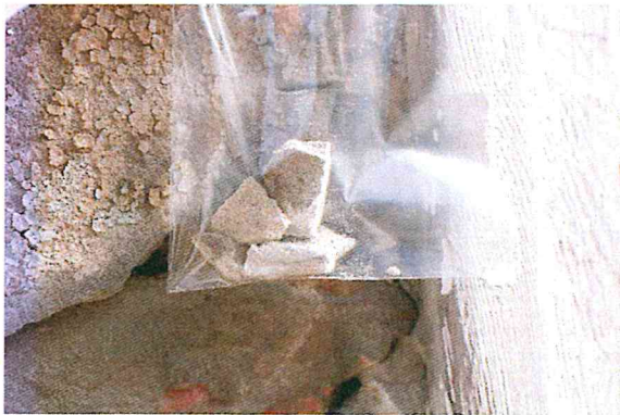
Miejsce pobrania próbki pierwotnej zaprawy tynkarskiej – pod drewnianą opaską okienną
