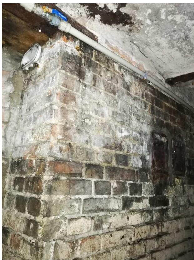
Zagrzybione ściany w mieszkaniach min. na skutek wymiany okien na PCV bez nawietrzników i nieskuteczną wentylację budynku – należy przeprowadzić prace naprawcze zgodnie z projektem budowlanym
