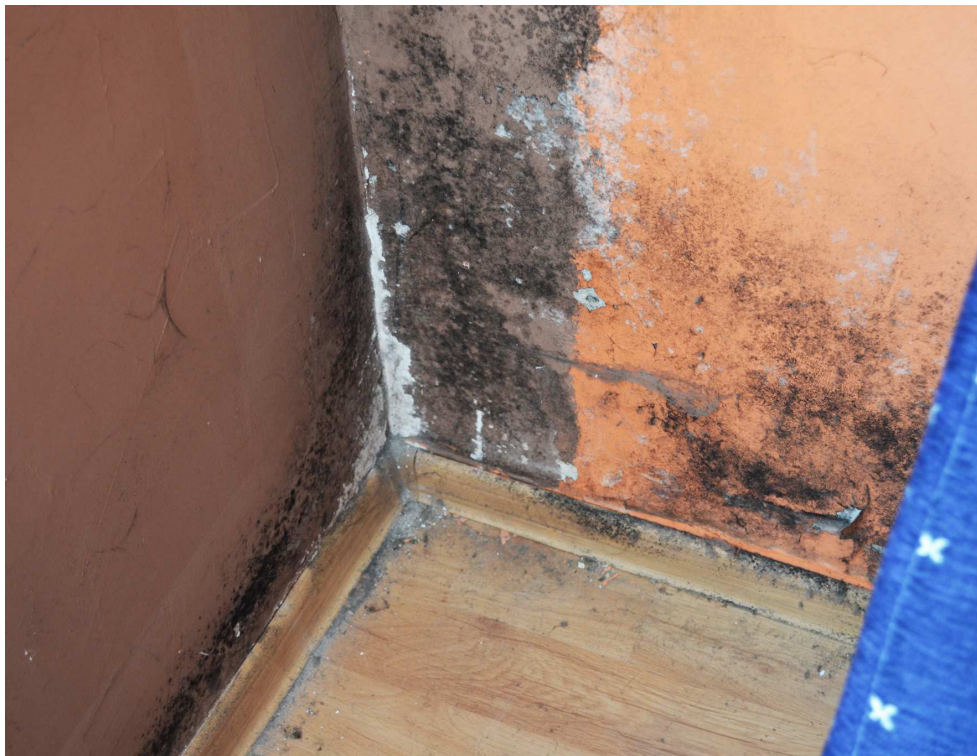
Zagrzybione ściany w mieszkaniach min. na skutek wymiany okien na PCV bez nawietrzników i nieskuteczną wentylację budynku – należy przeprowadzić prace naprawcze zgodnie z projektem budowlanym
