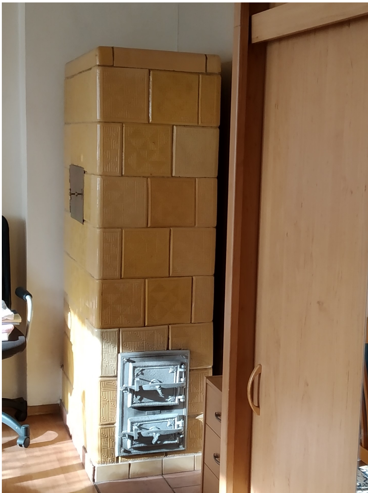
Piec (2) w pokoju mieszkalnym nr 04 (wg rysunku inwentaryzacji) - bardzo ostrożna rozbiórka oblicowania z kafli
