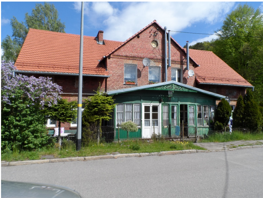
Południowa ściana budynku (od strony ulicy Kościerskiej) okna na piętrze nad werandą należą do mieszkania nr 6 (pokoju oraz kuchni)- zewnętrzne kanały wentylacyjne do usunięcia
