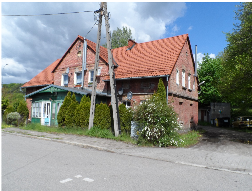
Widok budynku od strony narożnika południowo – wschodniego - zewnętrzne kanały wentylacyjne do usunięcia
