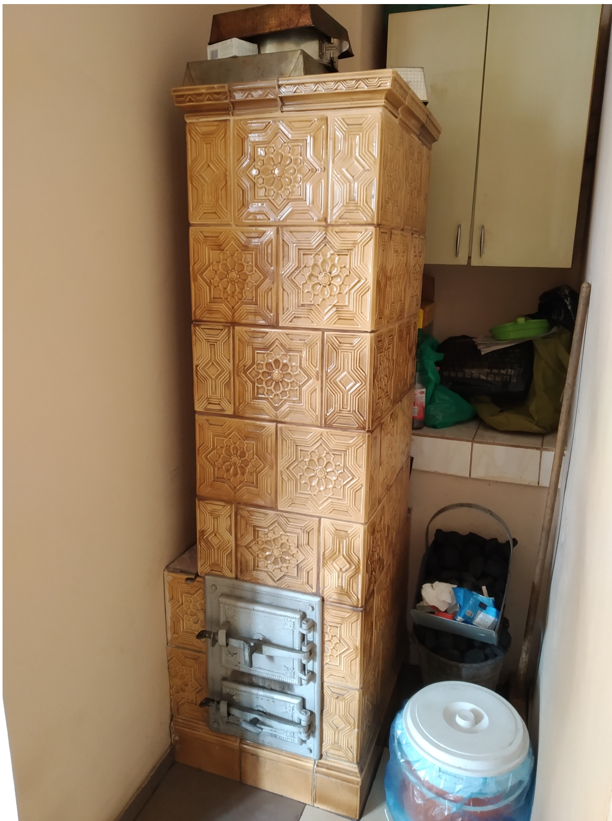
Piec (1) w miejscu projektowanej łazienki z WC - bardzo ostrożna rozbiórka oblicowania z kaflami
