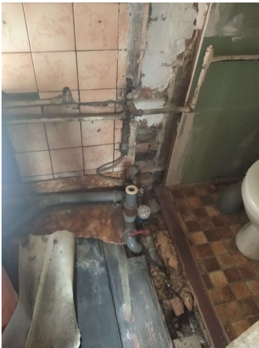
Zdjęcie nr 3. Lokalu nr 2, podejście do pionu wod.-kan. oraz lokalizacja wodomierza.
