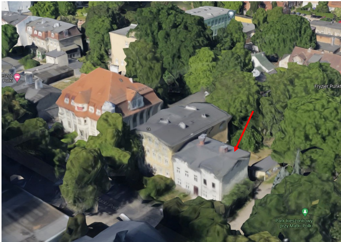
Lokalizacja budynku, widok od strony pñ.-wsch. – Źródło: Mapy Google 3D.
