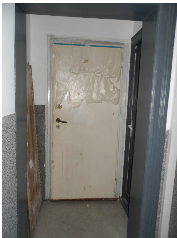
Istniejące 1-sze drzwi wejściowe do mieszkania – do usunięcia
