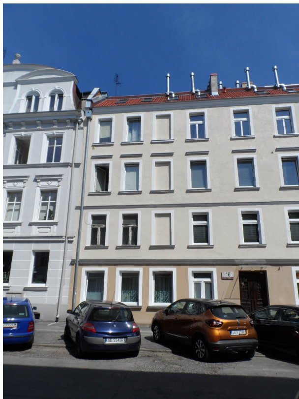
Frontowa elewacja budynku – okna mieszkania nr 7 – 1-sze piętro, na prawo od rury spustowej
