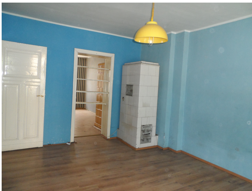
Pokój 2/03 – w głębi piec kaflowy do rozbiórki, na lewo od piec otwór drzwiowy do zabudowania (z pozostawieniem wnęki od strony pokoju 2/02)
