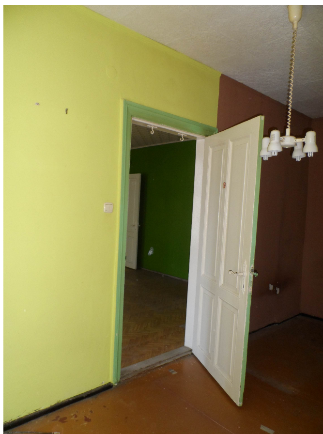
Drzwi pomiędzy pokojami – do renowacji
