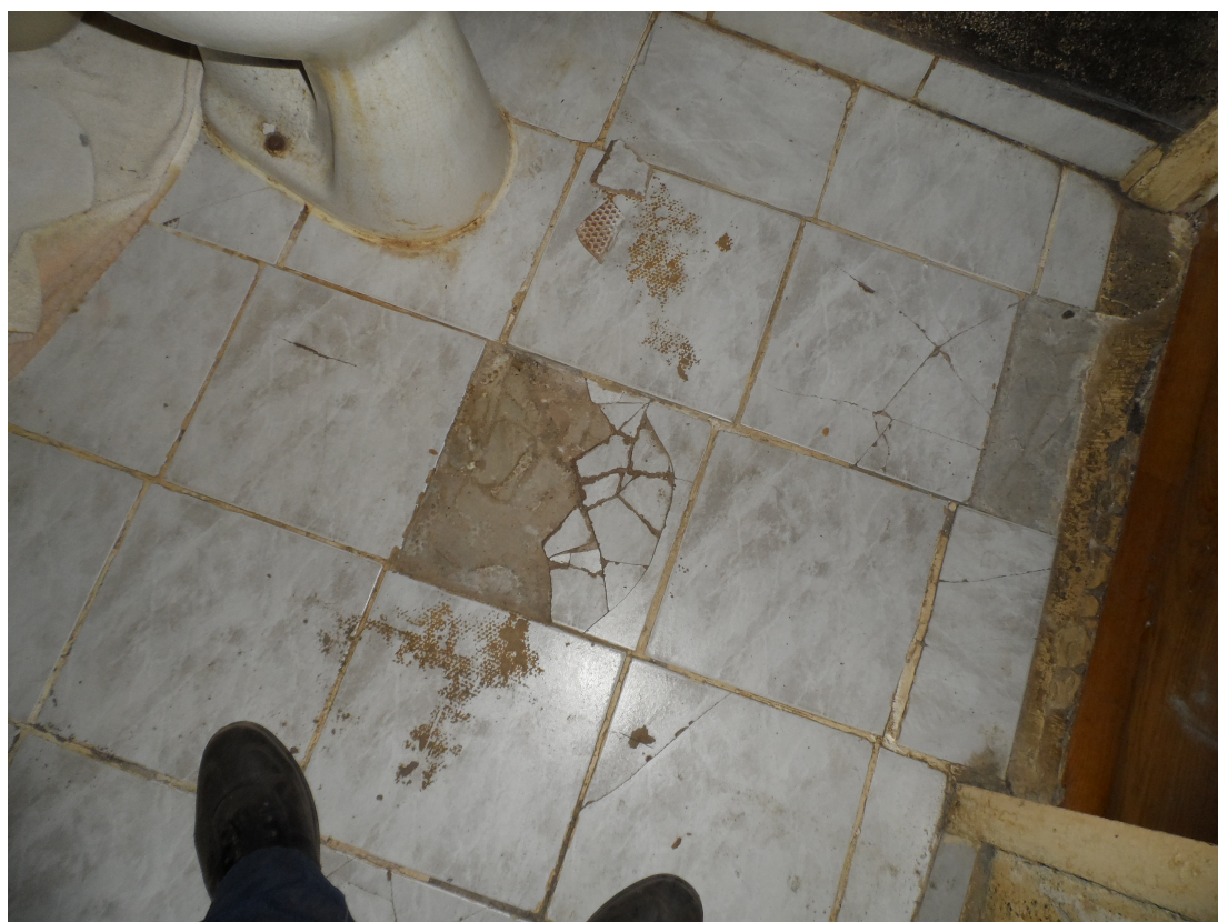
Posadzka łazienki z WC
