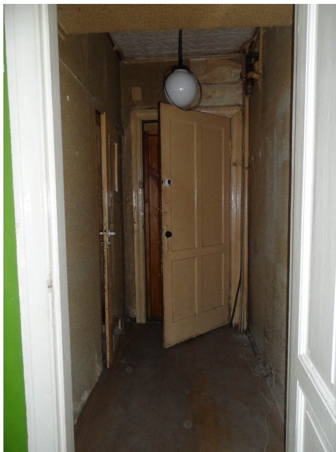
Wewnętrzne drzwi wejściowe do mieszkania („2-gie drzwi”) do renowacji wraz z ościeżnicą
