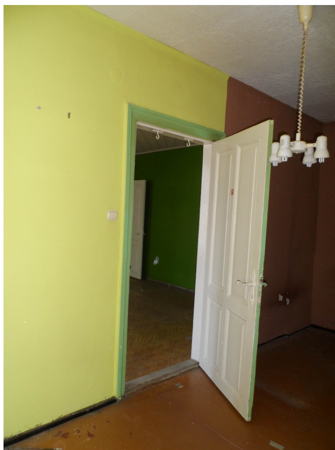
Drzwi pomiędzy pokojami – do renowacji
