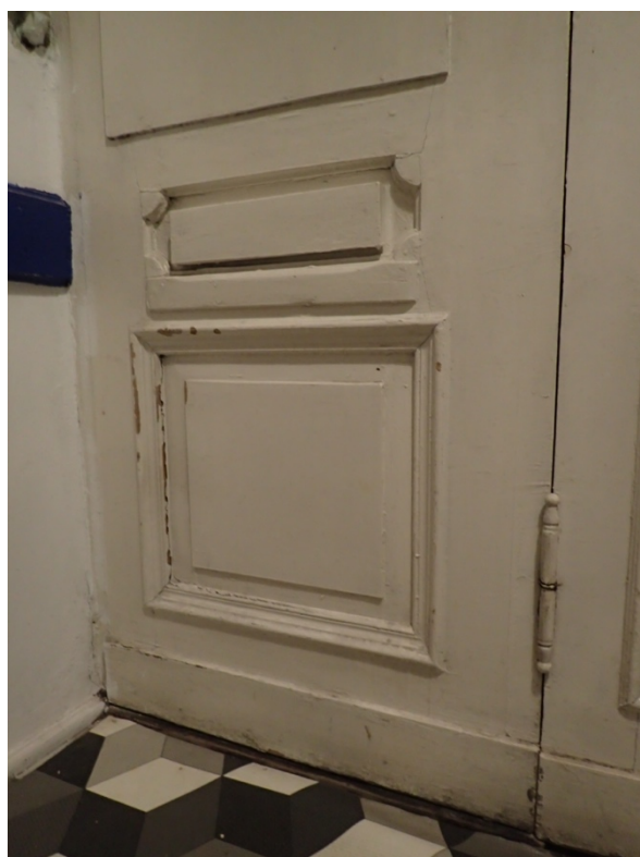
Fot. 56. II piętro, opracowanie dolnych partii skrzydeł drzwiowych.
