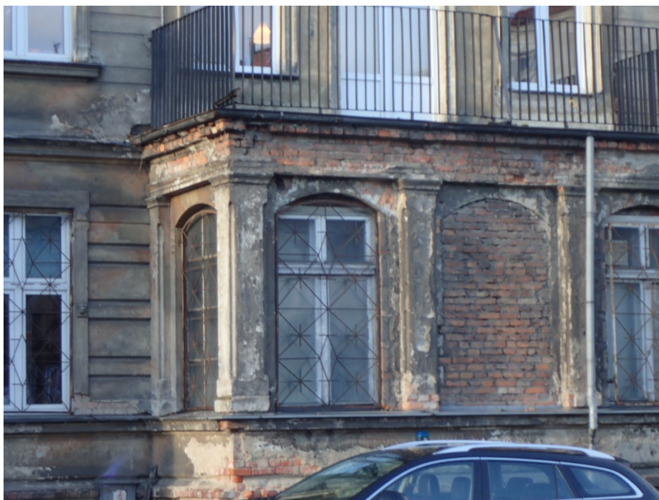
Fot. 21. Elewacja frontowa, loggia - stan zachowania. Środkowe przeprucie wtórnie zamurowane. Okna od frontu drewniane, wtórne.
