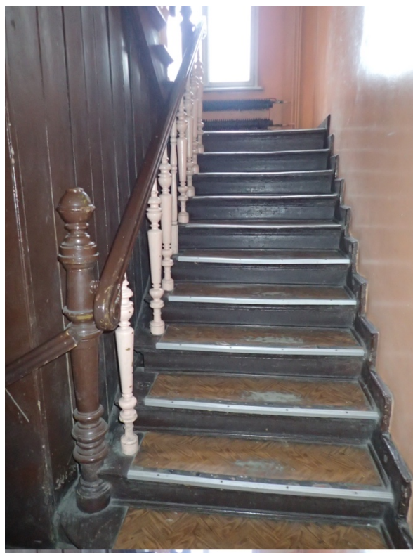
Fot. 43. Klatka schodowa, bieg schodów pokryty wtórne linoleum mocowanym aluminium kątownikami.
