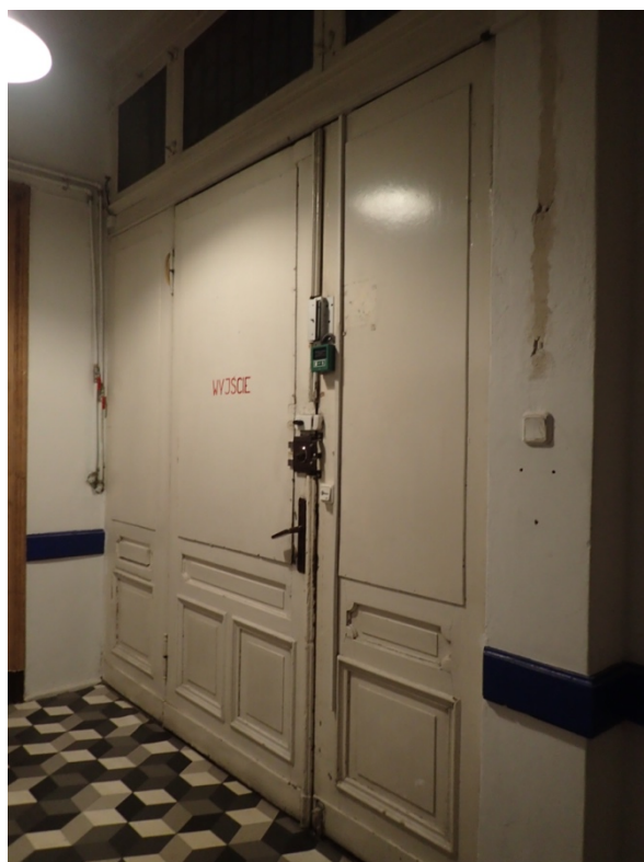
Fot. 55. II piętro, drzwi wejściowe od strony wewnętrznej.
