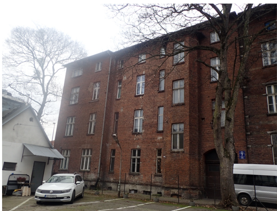
Fot. 30. Elewacja tylna, widok ogólny.
