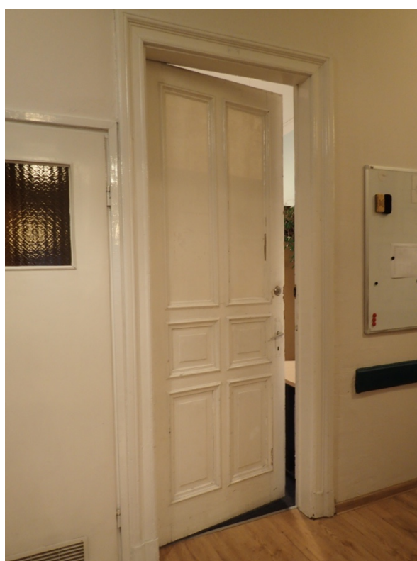
Fot. 60. I piętro - drewniane, płycinowo-ramowe drzwi wewnętrzne z profilowanymi odrzwiami.
