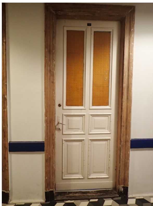
Fot. 58. II piętro, pływino-ramowe drzwi wewnętrzne. Przeszklenie jest elementem wtórnym.
