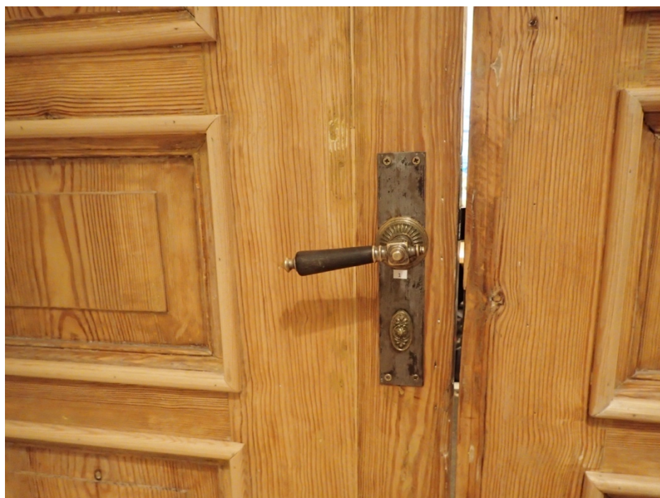
Fot. 61. I piętro - drewniane, płycinowo-ramowe drzwi wewnętrzne z płycinowo-ramowymi odzrzewami.
