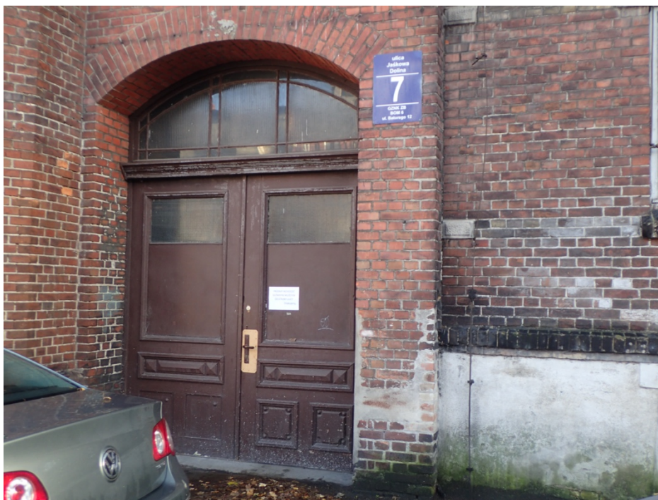
Fot. 33. Elewacja tylna, drzwi wejściowe.
