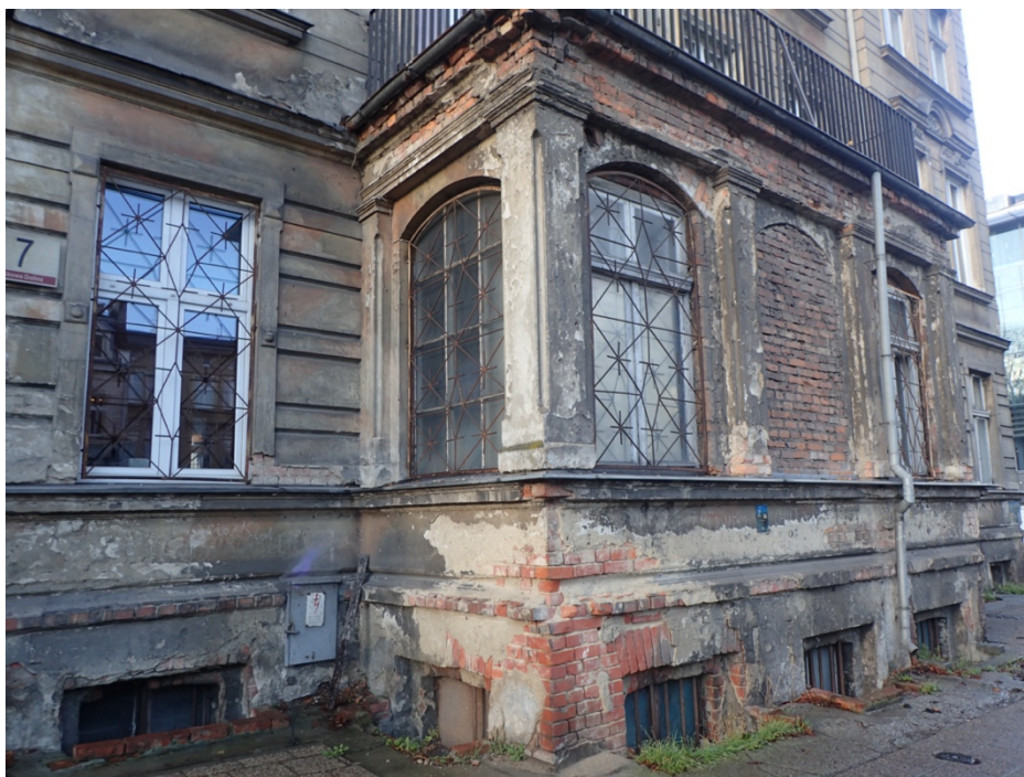
Fot. 19. Elewacja frontowa, loggia – stan zachowania.
