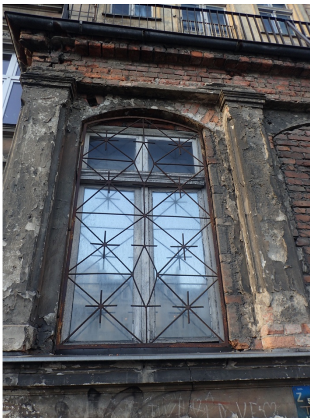
Fot. 21. Elewacja frontowa, loggia - stan zachowania. Środkowe przeprucie wtórnie zamurowane. Okna od frontu drewniane, wtórne.
