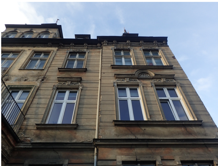
Fot. 7. Elewacja frontowa, wtórne okna PCV na I piętrze, na II piętrze zachowane drewniane okna oryginalne.
