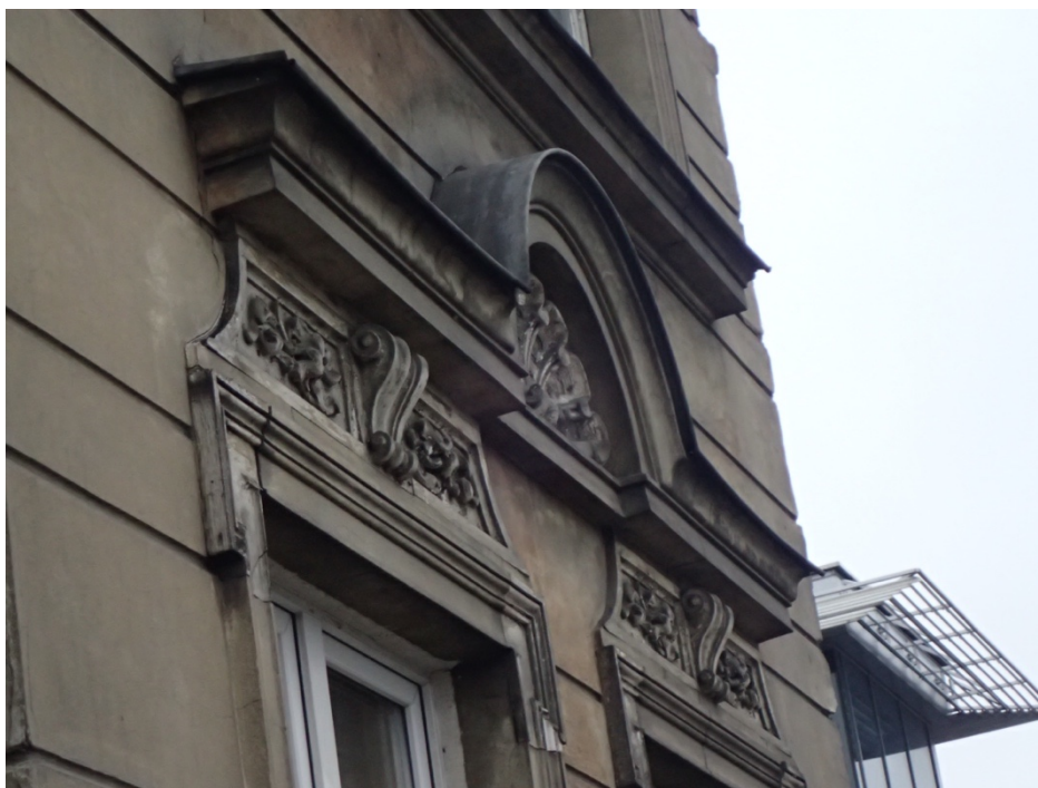
Fot. 13. Elewacja frontowa, detal architektoniczny nadproży okien I piętra.
