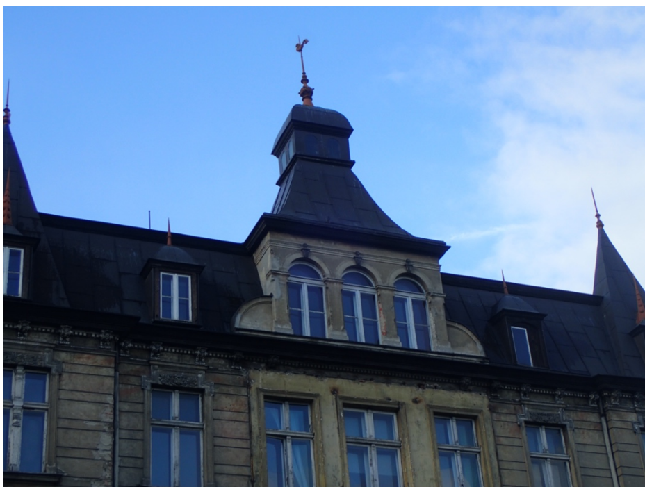
Fot. 2. Elewacja frontowa, facjata.
