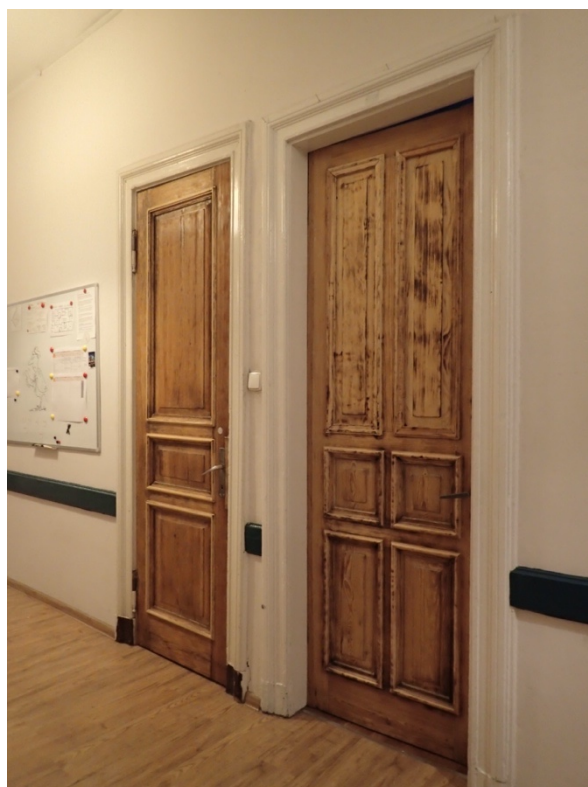
Fot. 63. I piętro, drewniane – płycinowo-ramowe drzwi o zróżnicowanej aranżacji, ujęte profilowanymi odrzwiami.
