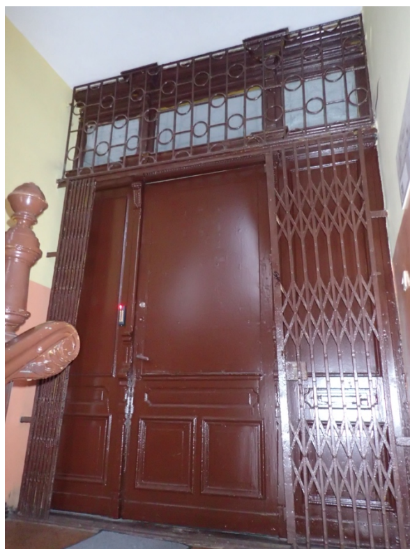
Fot. 53. Klatka schodowa, drzwi wejściowe do mieszkania na II piętrze.
