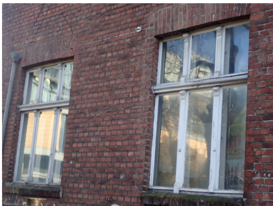
Fot. 32. Elewacja tylna, okna skrajnej osi ryzalitu.
