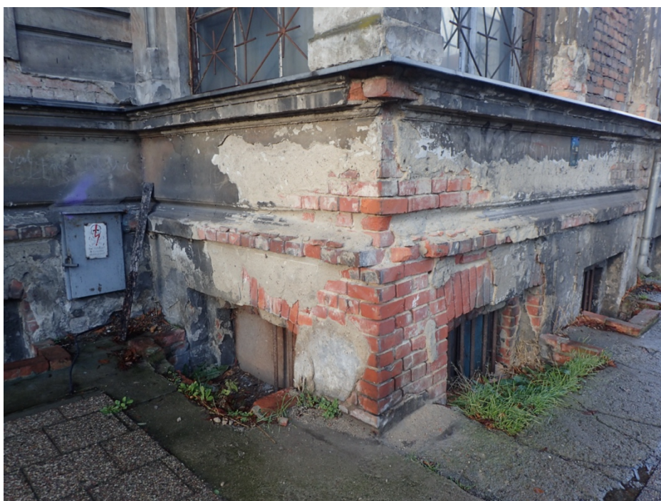
Fot. 23. Elewacja frontowa, stan zachowania przyziemia loggii. Widoczne zniszczenia wypraw tynkarskich, artykulacji architektonicznej oraz struktury murów. Wtórne obmurowania studzienek okienek piwnicznych. Wylewki cementowe i chodnik porażone mikroorganizmami.
