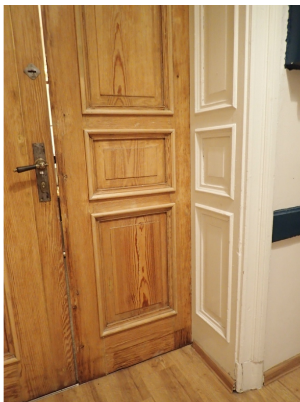
Fot. 64. I piętro – drzwi drewniane, wewnętrzne. Konstrukcja płycinowo ramowa skrzydeł drzwiowych i odrzwi – skrzydło oczyszczone do drewna.
