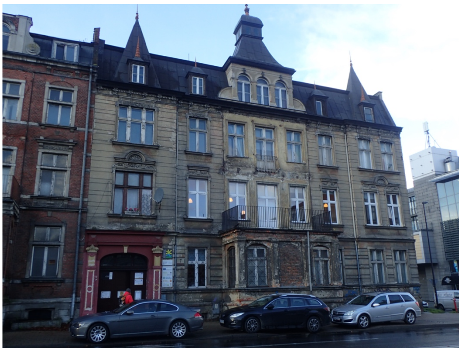
Fot.1. Elewacja frontowa, widok ogólny.
