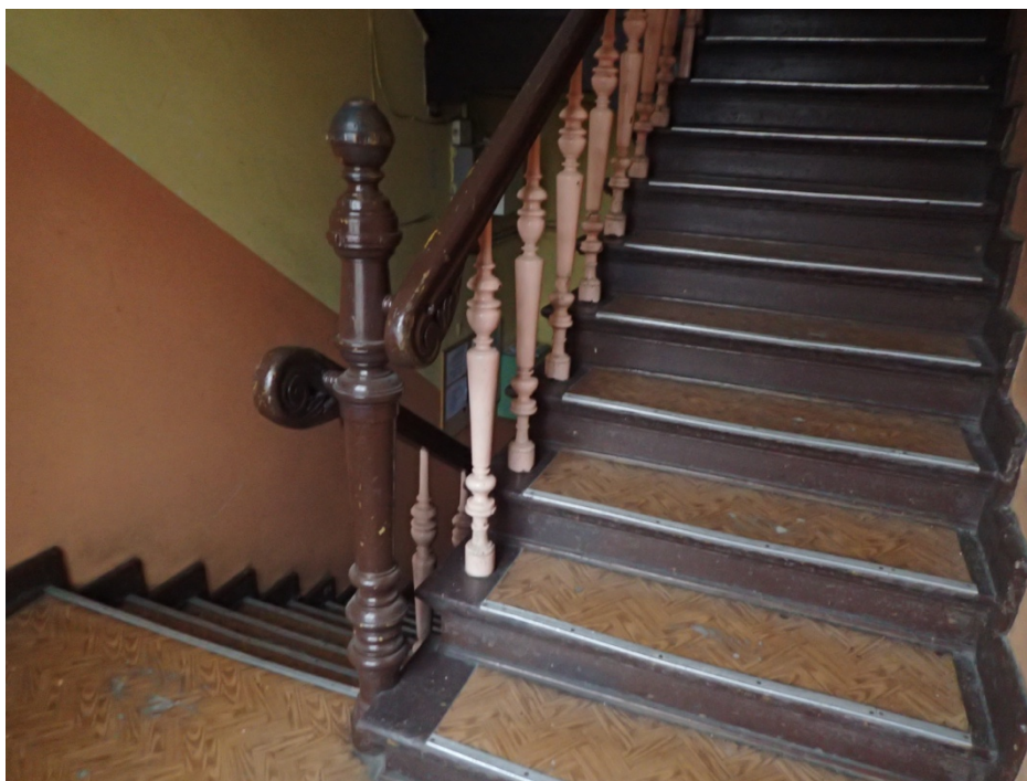
Fot. 45. Klatka schodowa, balustrada tralkowa ze słupkiem pośrednim i profilowanym, zakończonym esownicą i motywem liścia pochwytem.
