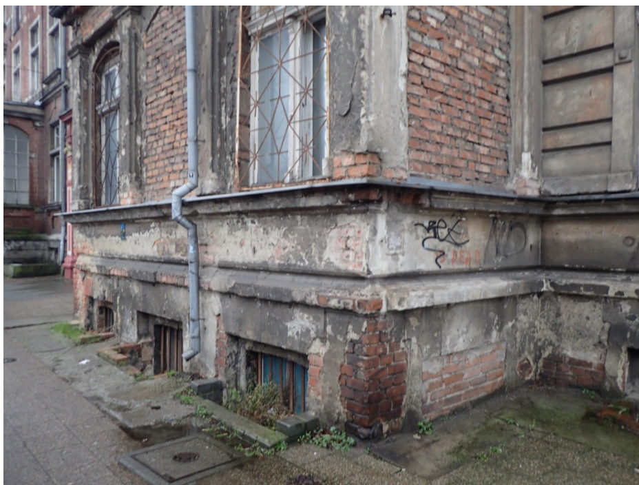
Fot. 23. Elewacja frontowa, stan zachowania przyziemia loggii. Widoczne zniszczenia wypraw tynkarskich, artykulacji architektonicznej oraz struktury murów. Wtórne obmurowania studzienek okienek piwnicznych. Wylewki cementowe i chodnik porażone mikroorganizmami.
