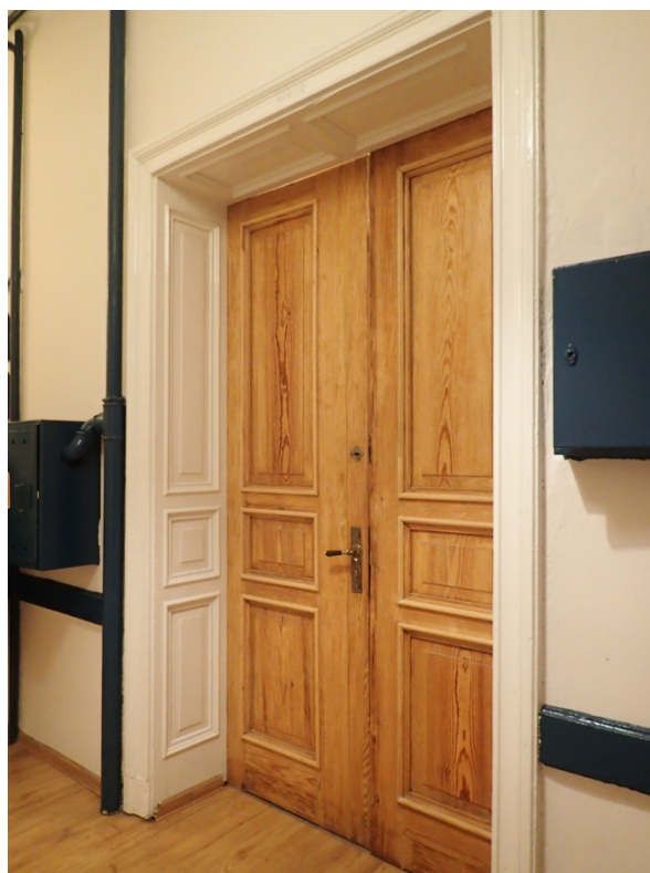
Fot. 61. I piętro - drewniane, płycinowo-ramowe drzwi wewnętrzne z płycinowo-ramowymi odzrzewami.
