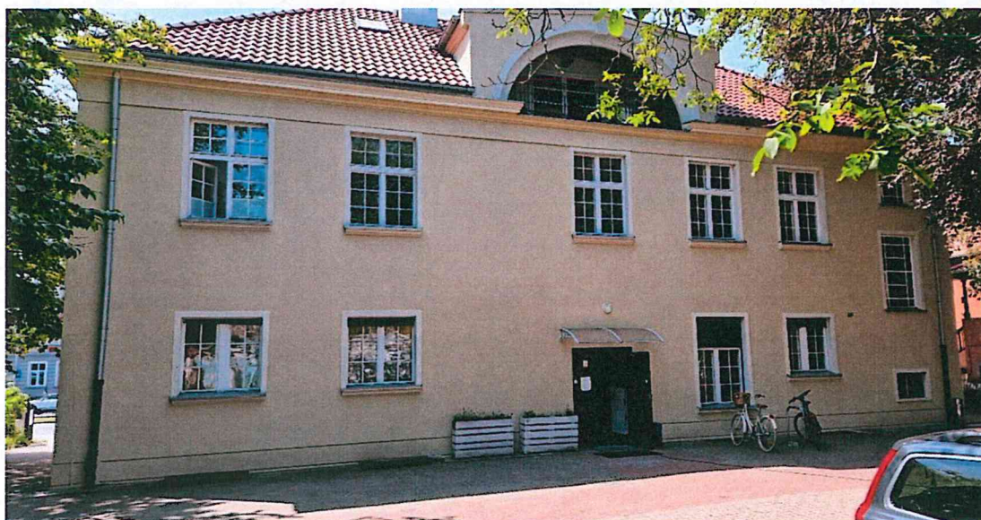
Elewacja ogrodowa, stan obecny
