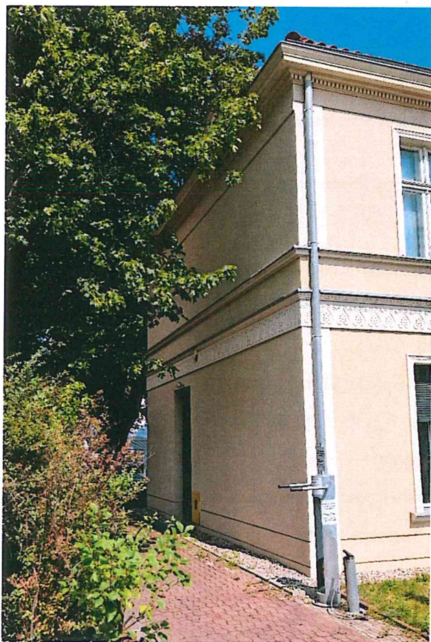
Elewacja zachodnia, stan obecny
