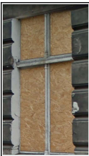
Zdj. nr 1 – zachowana stolarka okienna (wzór projektowanej stolarki) – oryginalna przy ul Szczygłej 7
