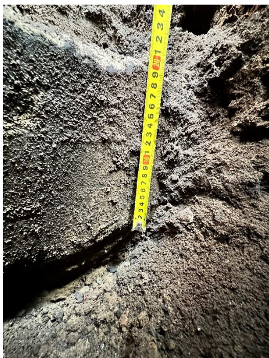
zdjęcie (zasoby własne) nr 2 - odkrywka fundamentów O1. Wysokość ławy 20 cm.
