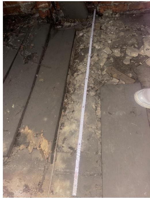
zdjęcie (zasoby własne) nr 28 – odkrywka O5 stropu międzykondygnacyjnego.
