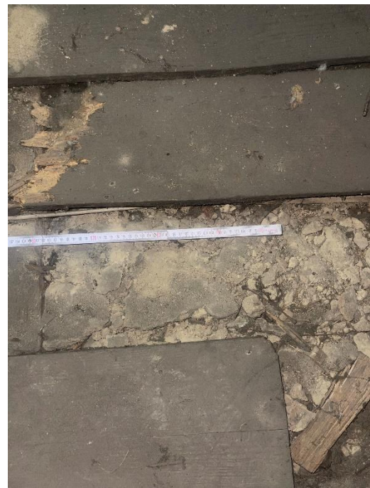
zdjęcie (zasoby własne) nr 30 – odkrywka O6 stropu międzykondygnacyjnego.
