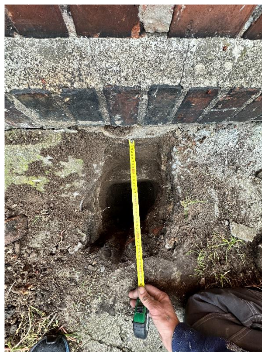
zdjęcie (zasoby własne) nr 3– odkrywka fundamentów O1..
