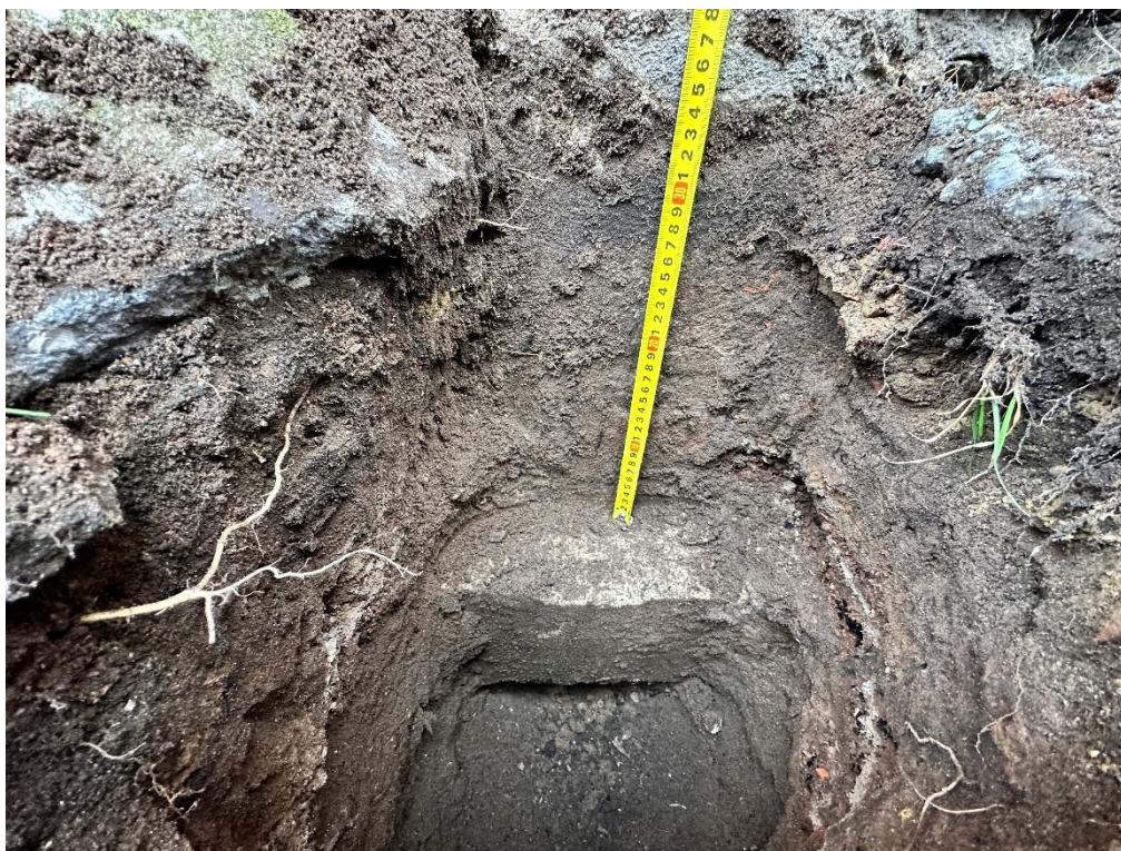
zdjęcie (zasoby własne) nr 1 – odkrywka fundamentów O1. Widoczna odsadzka ławy fundamentowej wykończona powłoką cementową.
