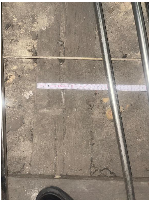
zdjęcie (zasoby własne) nr 29 – odkrywka O6 stropu międzykondygnacyjnego. Pomiar szerokości belki stropowej -16 cm.
