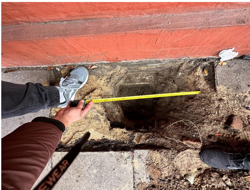
zdjęcie (zasoby własne) nr 4 – odkrywka fundamentów O2.
