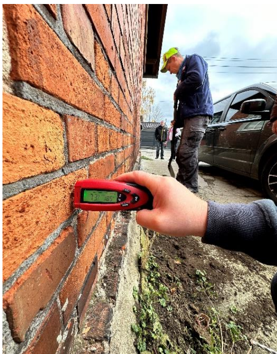
Fotografia 4 Miejsce wykonania pomiaru M4.
