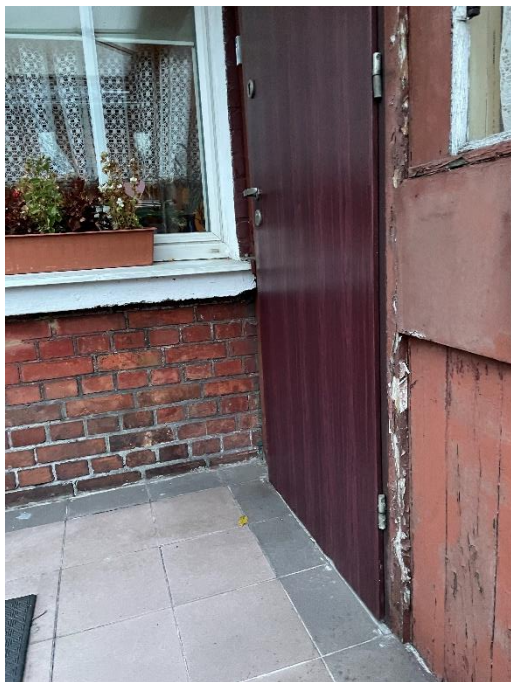
zdjęcie (zasoby własne) nr 17 – widok na fragment ściany dobudówki w elewacji wschodniej.
