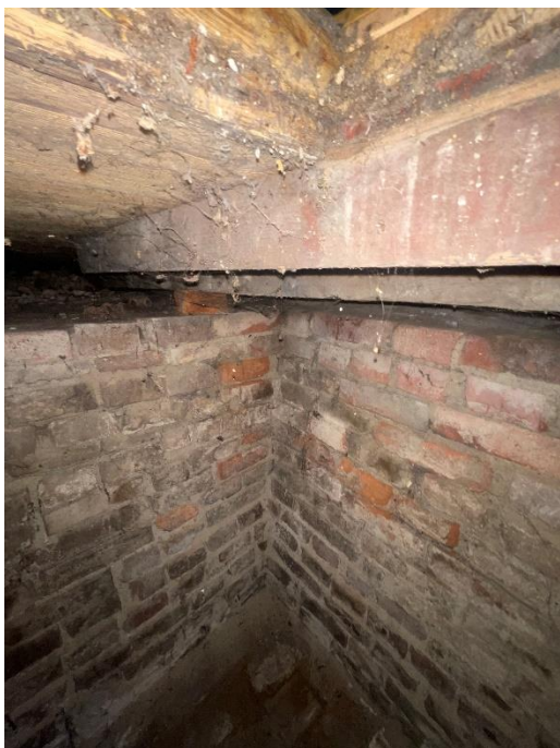
zdjęcie (zasoby własne) nr 15– widok na stan zachowania deskowania oraz belek stropowych w podpiwniczeniu.
