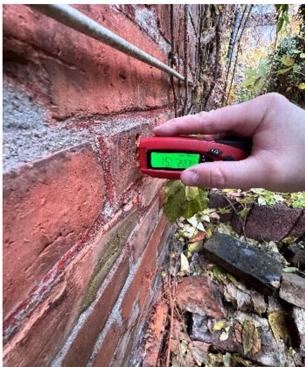
Fotografia 3 Miejsce wykonania pomiaru M3.
