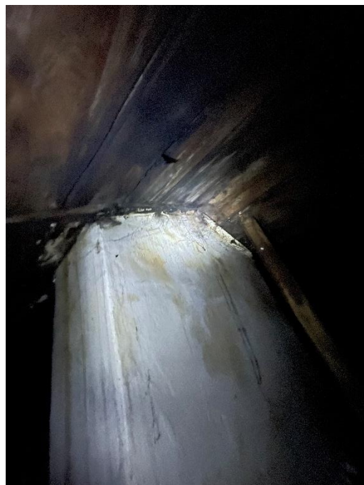
zdjęcie (zasoby własne) nr 34 – więźba dachowa – miejsce przejścia komina przez połać dachu. Widoczne odpowietrzenie pionu kanalizacyjnego.
