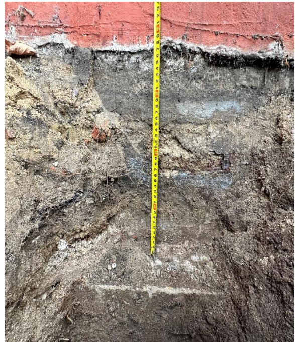
zdjęcie (zasoby własne) nr 6 – odkrywka fundamentów O2 – pomiary.
