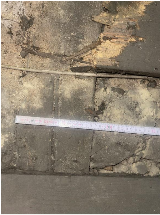
zdjęcie (zasoby własne) nr 27 – odkrywka O5 stropu międzykondygnacyjnego.
