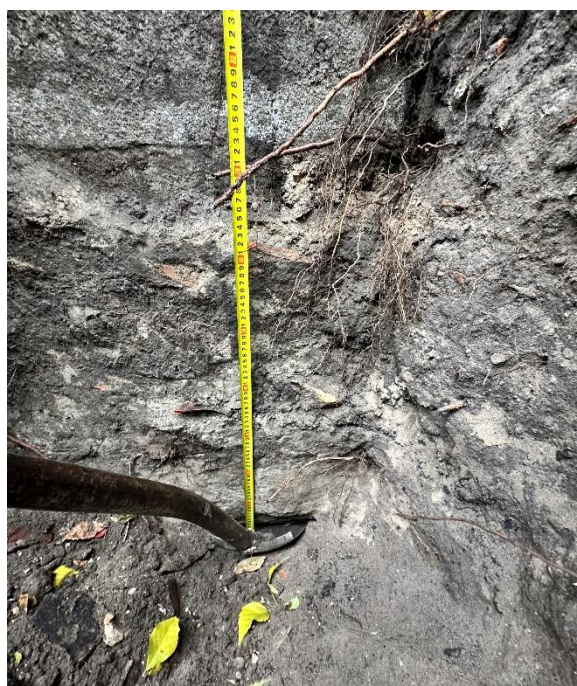
zdjęcie (zasoby własne) nr 8 – odkrywka fundamentów O3.
