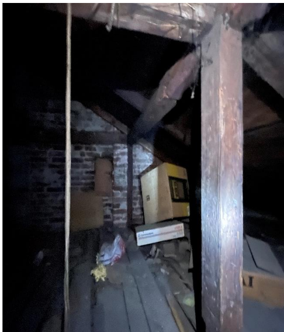
zdjęcie (zasoby własne) nr 35 – więźba dachowa.
