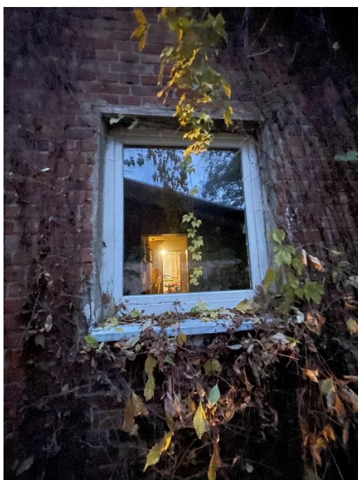
zdjęcie (zasoby własne) nr 21 – drewniane nadproże – elewacja północna.
