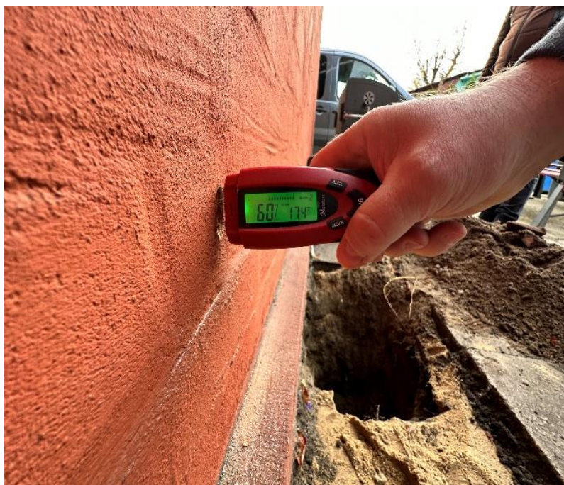
Fotografia 1 Miejsce wykonania pomiaru M1.
