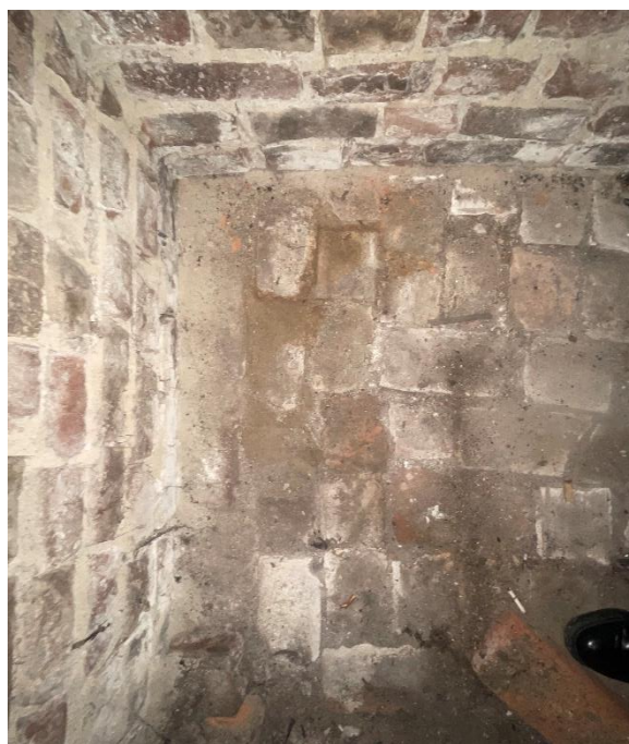
zdjęcie (zasoby własne) nr 16 – podłoga na gruncie w podpiwniczeniu – ceglana.
