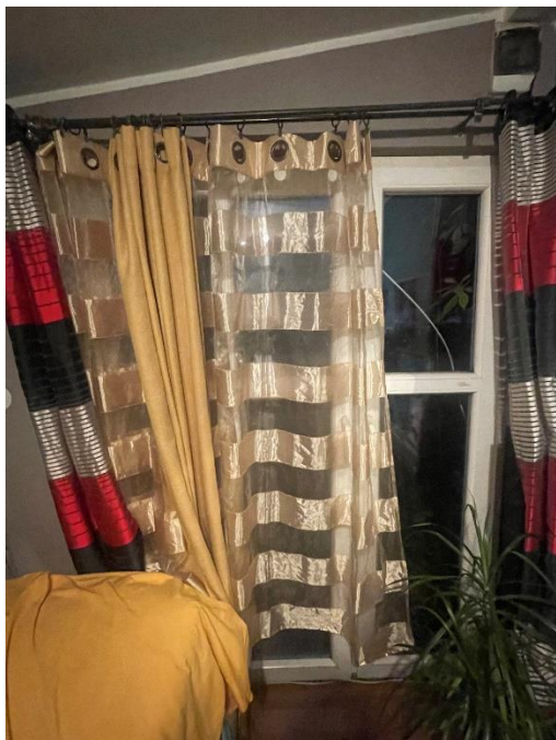
zdjęcie (zasoby własne) nr 40 – pokój 2.02 – w narożniku nad oknem widoczna rozdzielnia elektryczna.
