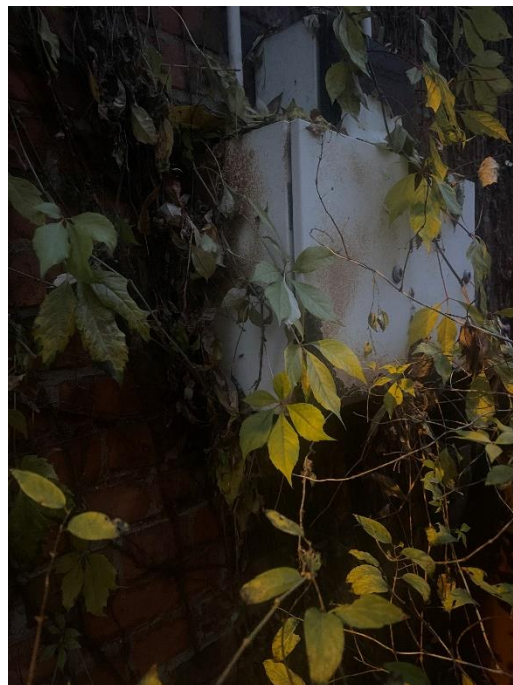
zdjęcie (zasoby własne) nr 41 – elewacja północna – widoczne skrzynki elektryczne.
