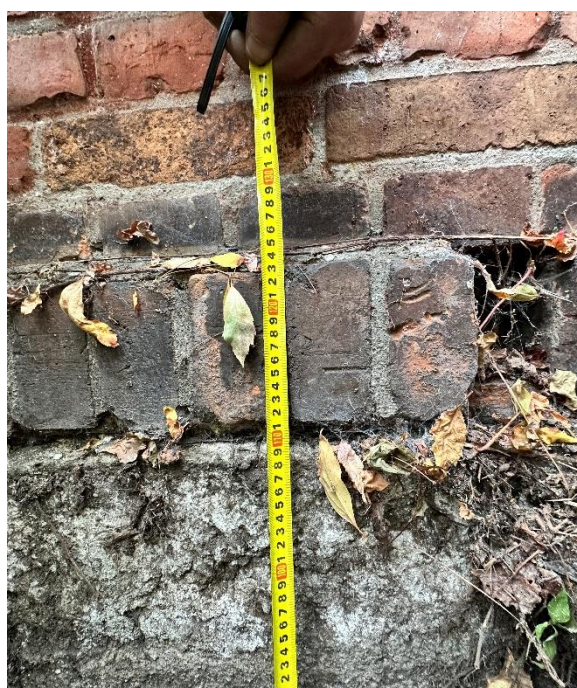
zdjęcie (zasoby własne) nr 10 – odkrywka fundamentów O3.
