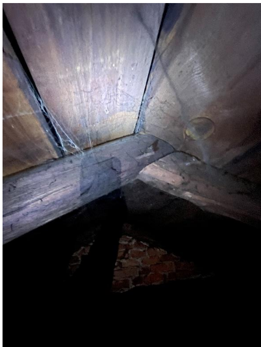
zdjęcie (zasoby własne) nr 31 – więźba dachowa – detal łączenia krokwii.
