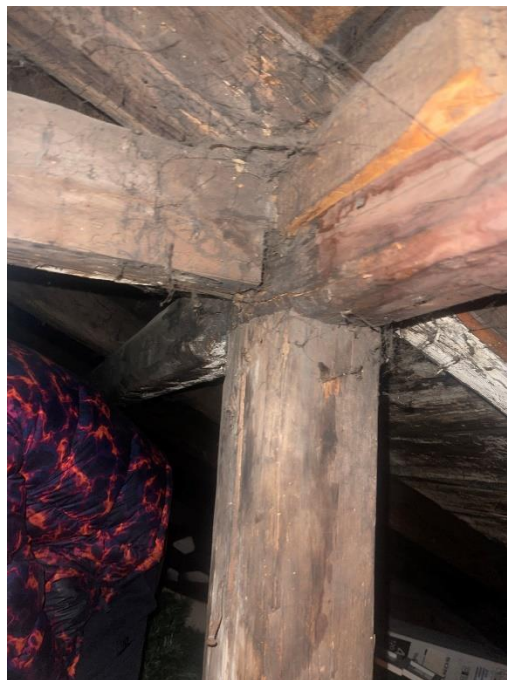
zdjęcie (zasoby własne) nr 36 – więźba dachowa – połączenie słupa, jętki, połaci i krokwi..
