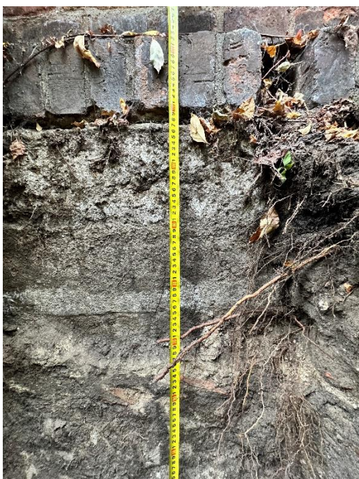
zdjęcie (zasoby własne) nr 9 – odkrywka fundamentów O3 – zagłębienie fundamentów ok. 100 cm.
