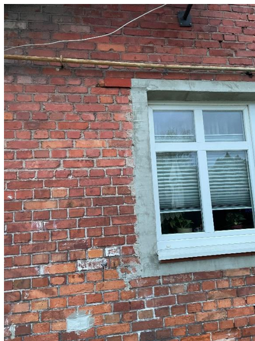
zdjęcie (zasoby własne) nr 20 – drewniane nadproże okienne. Widoczne ślady po obróbce otworu okiennego.
