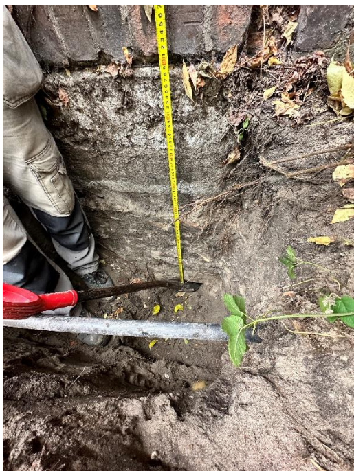
zdjęcie (zasoby własne) nr 7 – odkrywka fundamentów O3.
