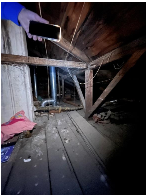
zdjęcie (zasoby własne) nr 33 – więźba dachowa – widoczny słup, miecze, jętka, połać, krokiew.
