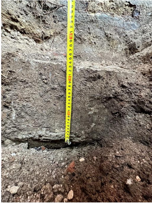
zdjęcie (zasoby własne) nr 5 – odkrywka fundamentów O2.
