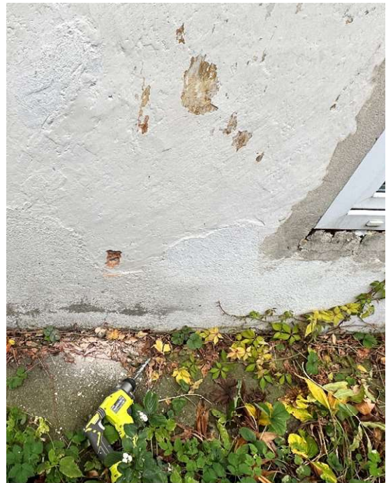
zdjęcie (zasoby własne) nr 20 – elewacja południowa – odkrywka O5 ściany zewnętrznej.
