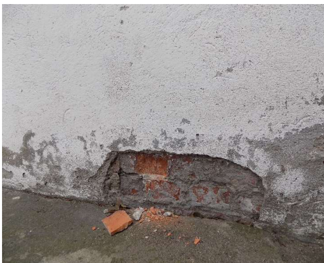
zdjęcie (zasoby własne) nr 21 – elewacja północna – odkrywka ściany zewnętrznej O6.
