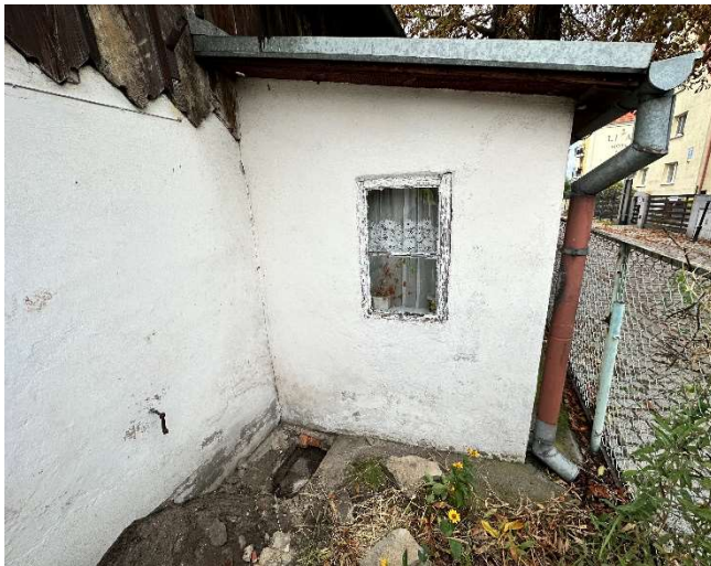
zdjęcie (zasoby własne) nr 7 – odkrywka fundamentów O3.
