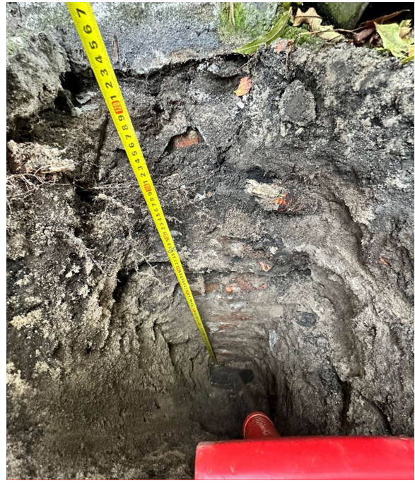
zdjęcie (zasoby własne) nr 5 – odkrywka fundamentów O2 – pomiary.
