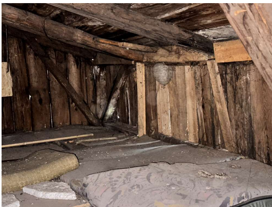
zdjęcie (zasoby własne) nr 38 – więźba dachowa.
