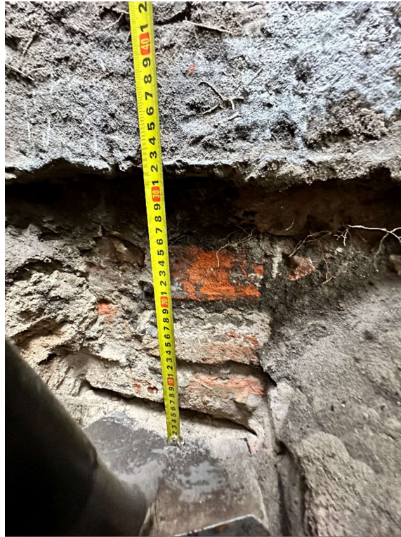
zdjęcie (zasoby własne) nr 1 - odkrywka fundamentów O1.
