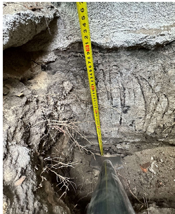
zdjęcie (zasoby własne) nr 8 – odkrywka fundamentów O3.
