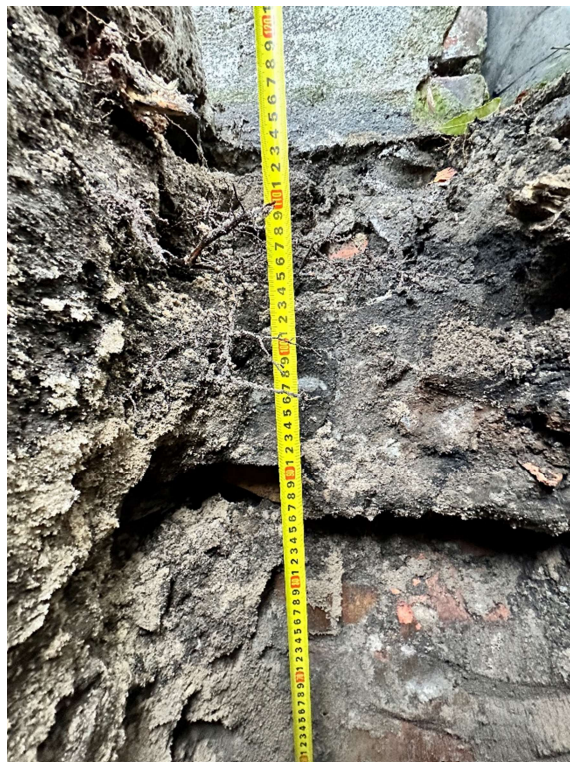
zdjęcie (zasoby własne) nr 6 - odkrywka fundamentów O2 – pomiary.
