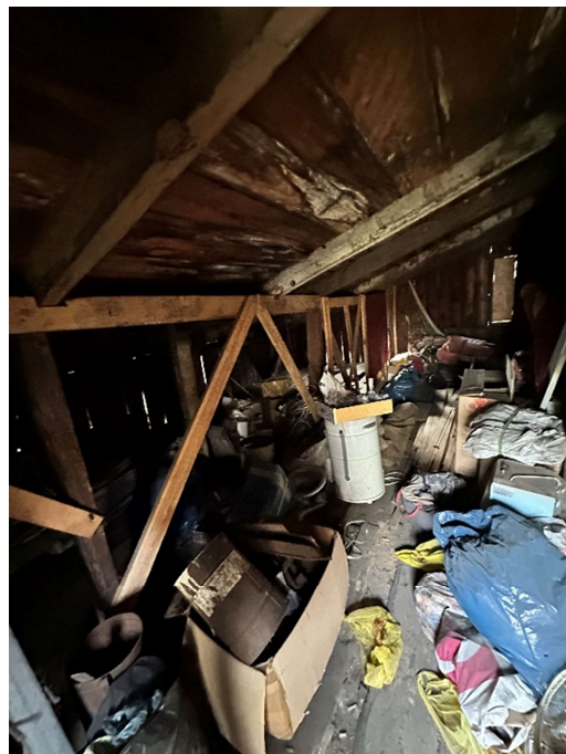
zdjęcie (zasoby własne) nr 34 – więźba dachowa.
