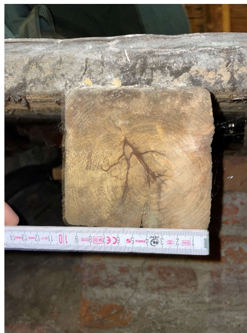
zdjęcie (zasoby własne) nr 14 – odkrywka O4 stropu nad podpiwniczeniem.
