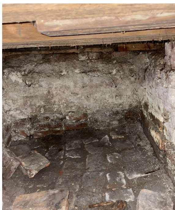
zdjęcie (zasoby własne) nr 16 – podłoga na gruncie w podpiwniczeniu – ułożona kosta kamienna.
