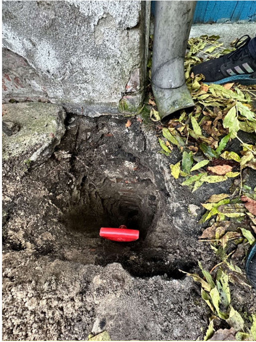
zdjęcie (zasoby własne) nr 4 – odkrywka fundamentów O2.
