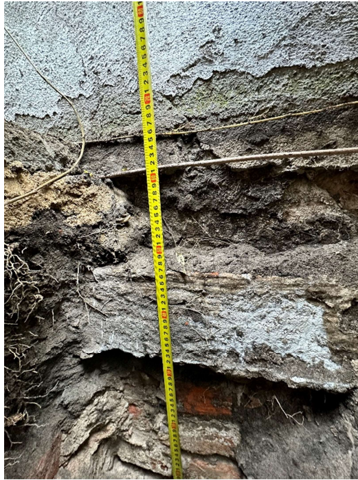
zdjęcie (zasoby własne) nr 3 – odkrywka fundamentów O1.
