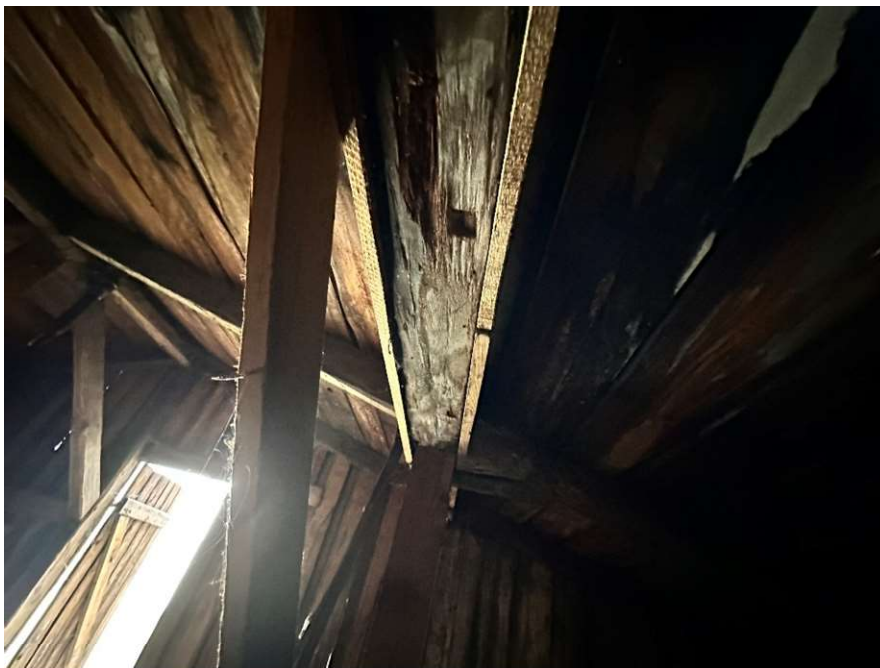
zdjęcie (zasoby własne) nr 39 – więźba dachowa – widok na belkę potłaciową.
