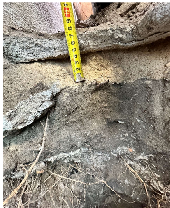
zdjęcie (zasoby własne) nr 10 – odkrywka fundamentów O3 – wylewka betonowa wokół budynku.
