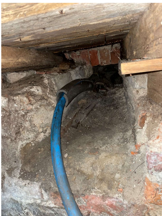
zdjęcie (zasoby własne) nr 15 – wiok na stan zachowania deskowania oraz belek stropowych w podpiwniczeniu.
