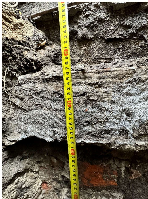
zdjęcie (zasoby własne) nr 2 - odkrywka fundamentów O1.
