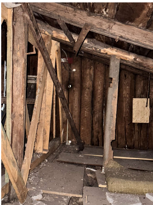
zdjęcie (zasoby własne) nr 35 – więźba dachowa.
