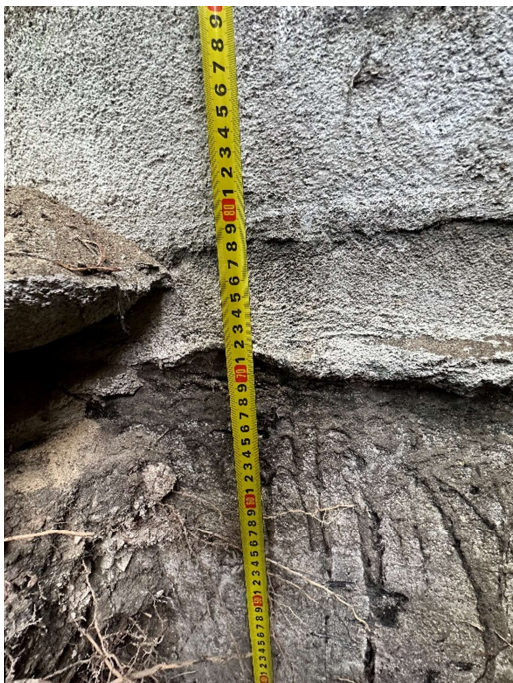
zdjęcie (zasoby własne) nr 9 – odkrywka fundamentów O3.
