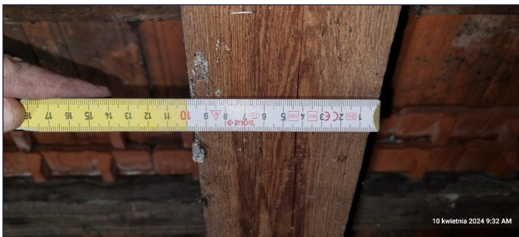
Foto 108. Widok stanu technicznego konstrukcji więźby dachowej; Pomiar szerokości krokwi dachu; Wizja wykonana z przestrzeni części nieużytkowej poddasza (strych) – odkrywka OW-1;
