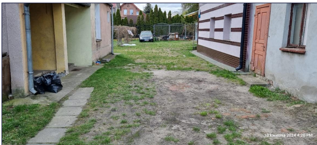
Foto 9. Widok terenu między obiektami budowlanymi od strony północnej;
