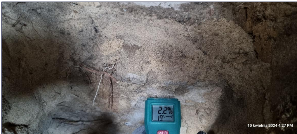
Foto 135. Widok odkrywki ściany fundamentowej i fundamentu od strony południowej budynku; Odkrywka zrealizowana przy południowej ścianie zewnętrznej bliźniaka – budynek 12B; Pomiar wilgotności ławy betonowej;
