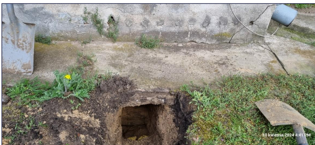
Foto 143. Widok odkrywki ściany fundamentowej i fundamentu od strony wschodniej budynku; Odkrywka zrealizowana przy wschodniej ścianie zewnętrznej bliźniaka – budynek 12B;
