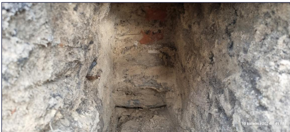
Foto 141. Widok odkrywki ściany fundamentowej i fundamentu od strony wschodniej budynku; Odkrywka zrealizowana przy wschodniej ścianie zewnętrznej bliźniaka – budynek 12B;
