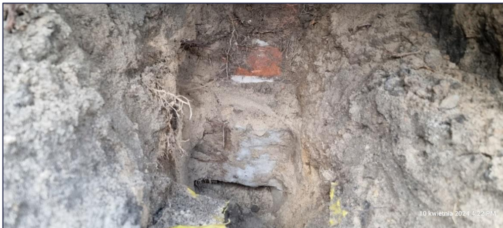
Foto 132. Widok odkrywki ściany fundamentowej i fundamentu od strony południowej budynku; Odkrywka zrealizowana przy południowej ścianie zewnętrznej bliźniaka – budynek 12B;
