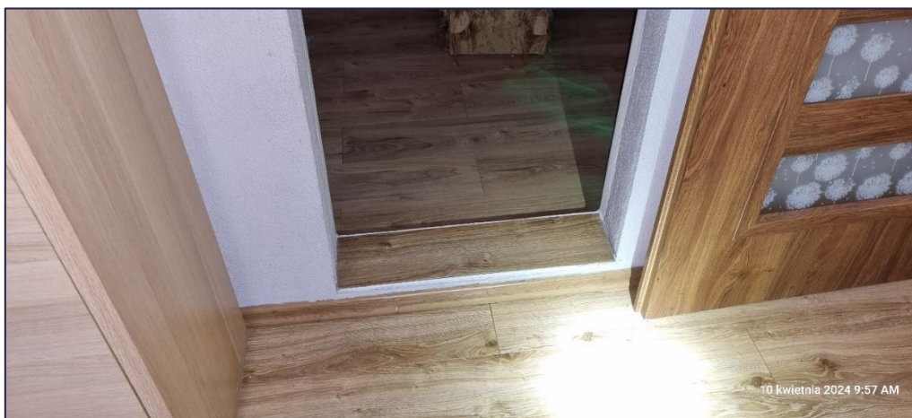
Foto 130. Widok podwaliny więzara płatwiowo-kleszczowego; Widok z pomieszczenia M3.05;
