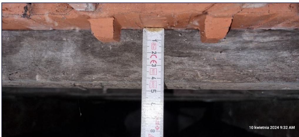
Foto 115. Widok stanu technicznego konstrukcji więźby dachowej; Pomiar geometrii łąty dachowej; Wizja wykonana z przestrzeni części nieużytkowej poddasza (strych) – odkrywka OW-1;
