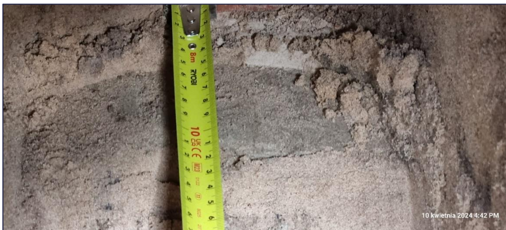
Foto 144. Widok odkrywki ściany fundamentowej i fundamentu od strony wschodniej budynku; Odkrywka zrealizowana przy wschodniej ścianie zewnętrznej bliźniaka – budynek 12B; Pomiar odsadзки ławy fundamentowej;
