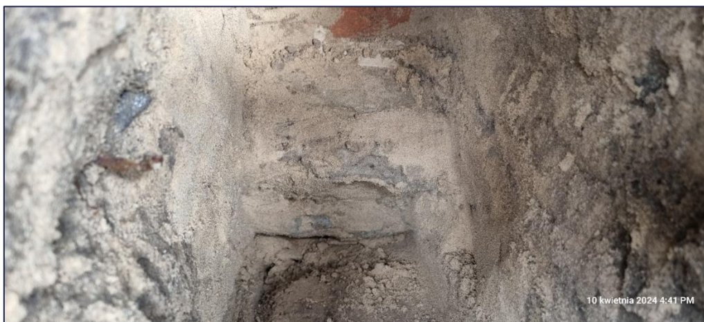
Foto 142. Widok odkrywki ściany fundamentowej i fundamentu od strony wschodniej budynku; Odkrywka zrealizowana przy wschodniej ścianie zewnętrznej bliźniaka – budynek 12B;
