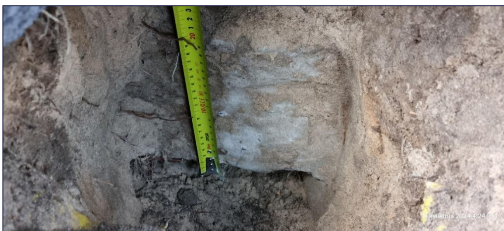
Foto 134. Widok odkrywki ściany fundamentowej i fundamentu od strony południowej budynku; Odkrywka zrealizowana przy południowej ścianie zewnętrznej bliźniaka – budynek 12B; Pomiar wysokości ławy fundamentowej;
