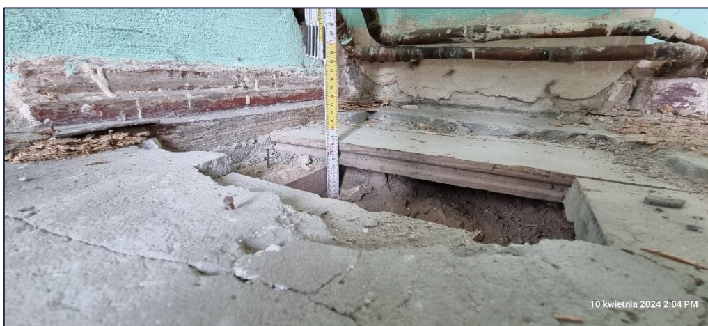
Foto 44. Widok stanu technicznego posadzki na gruncie w pomieszczeniu M2.04; Odkrywanie posadzki na gruncie - odkrywka OP-1;
