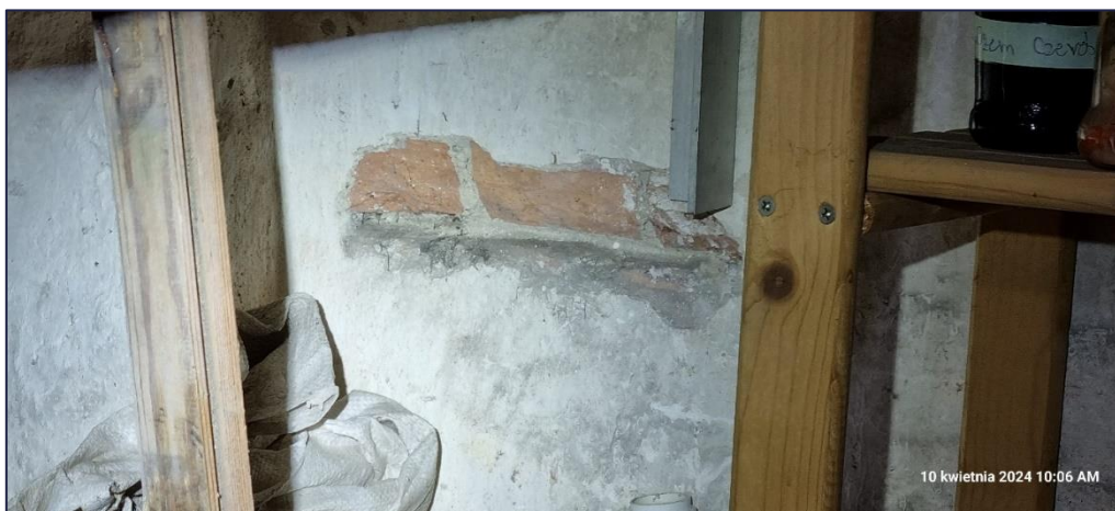
Foto 41. Widok stanu technicznego zewnętrznej ściany nośnej budynku; Odkrywa ściany zewnętrznej - odkrywka OSZ-1;
