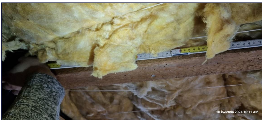
Foto 24. Widok stanu technicznego konstrukcji stropu nad piwnicą; Odkrywką przepony poziomej OS-1; Pomiar rozpiętości między belkami;
