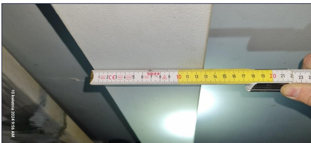
Foto 128. Pomiar geometrii stolców więzara dachowego w pomieszczeniu M3.06;
