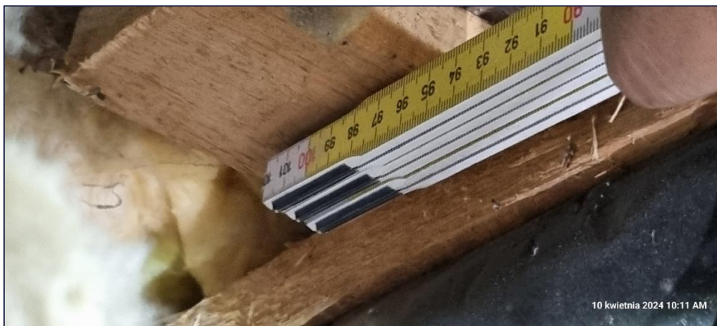
Foto 25. Widok stanu technicznego konstrukcji stropu nad piwnicą; Odkrywką przepony poziomej OS-1; Pomiar rozpiętości między belkami;
