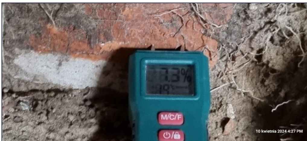
Foto 137. Widok odkrywki ściany fundamentowej i fundamentu od strony południowej budynku; Odkrywka zrealizowana przy południowej ścianie zewnętrznej bliźniaka – budynek 12B; Pomiar wilgotności ściany fundamentowej;
