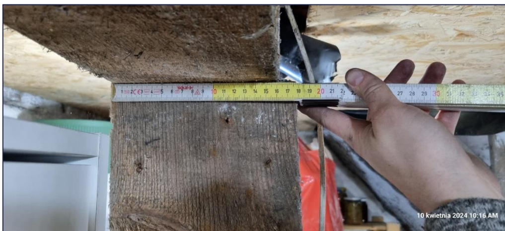
Foto 38. Widok konstrukcji podpierającej główne elementy nośne stropu; Pomiar geometrii elementów konstrukcji wsporczej;
