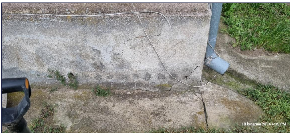
Foto 139. Widok odkrywki ściany fundamentowej i fundamentu od strony wschodniej budynku; Odkrywka zrealizowana przy wschodniej ścianie zewnętrznej bliźniaka – budynek 12B;
