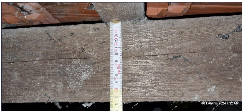
Foto 109. Widok stanu technicznego konstrukcji więźby dachowej; Pomiar wysokości krokwi dachu; Wizja wykonana z przestrzeni części nieużytkowej poddasza (strych) – odkrywka OW-1;
