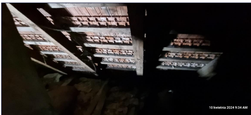
Foto 81. Widok stanu technicznego konstrukcji więźby dachowej; Wizja wykonana z przestrzeni części nieużytkowej poddasza (strych) – odkrywka OW-1;
