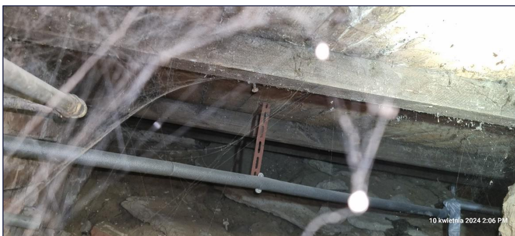
Foto 78. Widok stanu technicznego posadzki na gruncie w pomieszczeniu M2.03; Odkrywanie posadzki na gruncie – odkrywka OP-2;
