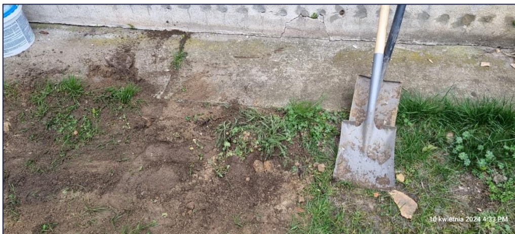
Foto 138. Widok odkrywki ściany fundamentowej i fundamentu od strony południowej budynku; Odkrywka zrealizowana przy południowej ścianie zewnętrznej bliźniaka – budynek 12B;
