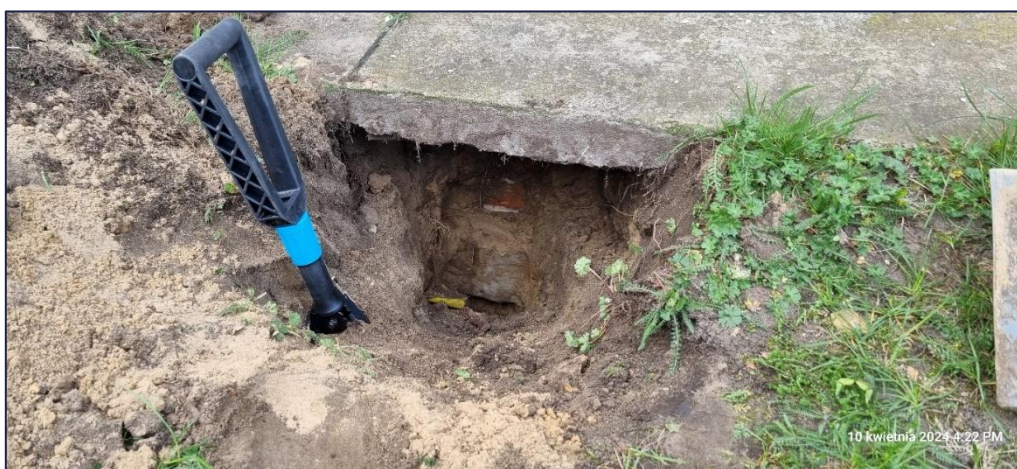
Foto 131. Widok odkrywki ściany fundamentowej i fundamentu od strony południowej budynku; Odkrywka zrealizowana przy południowej ścianie zewnętrznej bliźniaka – budynek 12B;
