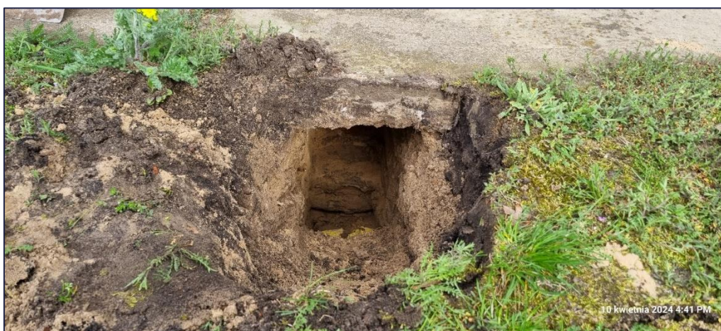
Foto 140. Widok odkrywki ściany fundamentowej i fundamentu od strony wschodniej budynku; Odkrywka zrealizowana przy wschodniej ścianie zewnętrznej bliźniaka – budynek 12B;
