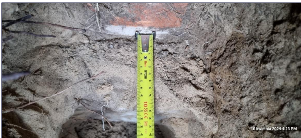
Foto 133. Widok odkrywki ściany fundamentowej i fundamentu od strony południowej budynku; Odkrywka zrealizowana przy południowej ścianie zewnętrznej bliźniaka – budynek 12B; Pomiar odsadzki ławy fundamentowej;
