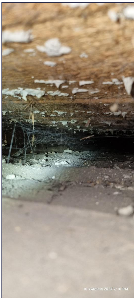
Foto 61. Widok stanu technicznego przestrzeni stropu nad parterem – odkrywka OS-1;
