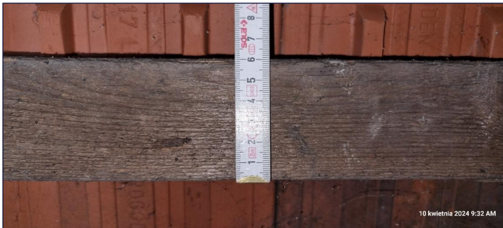
Foto 116. Widok stanu technicznego konstrukcji więźby dachowej; Pomiar geometrii łąty dachowej; Wizja wykonana z przestrzeni części nieużytkowej poddasza (strych) – odkrywka OW-1;
