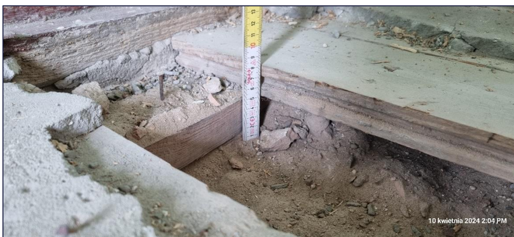
Foto 45. Widok stanu technicznego posadzki na gruncie w pomieszczeniu M2.04; Odkrywanie posadzki na gruncie - odkrywka OP-1;
