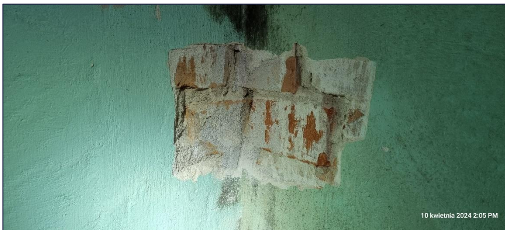
Foto 48. Widok stanu technicznego ściany zewnętrznej budynku; Odkrywka ściany zewnętrznej – odkrywka OSZ-2;
