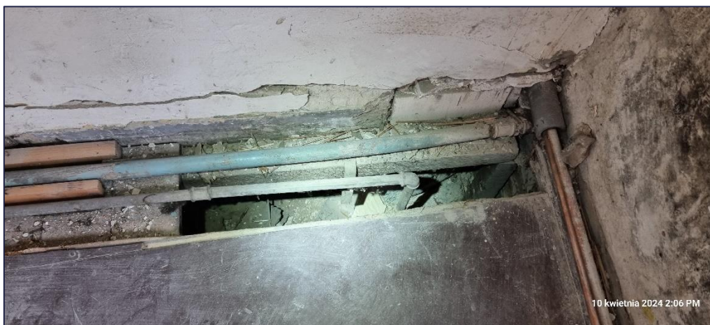
Foto 77. Widok stanu technicznego posadzki na gruncie w pomieszczeniu M2.03; Odkrywanie posadzki na gruncie – odkrywka OP-2;
