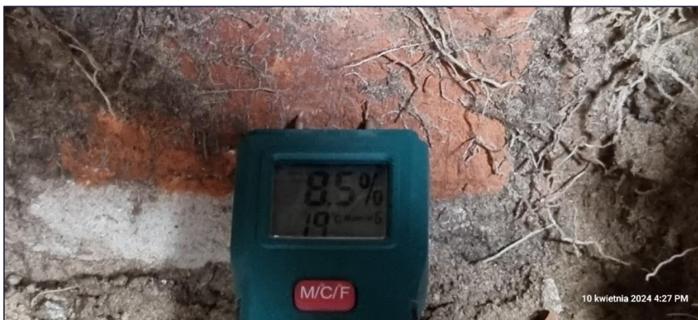
Foto 136. Widok odkrywki ściany fundamentowej i fundamentu od strony południowej budynku; Odkrywka zrealizowana przy południowej ścianie zewnętrznej bliźniaka – budynek 12B; Pomiar wilgotności ściany fundamentowej;
