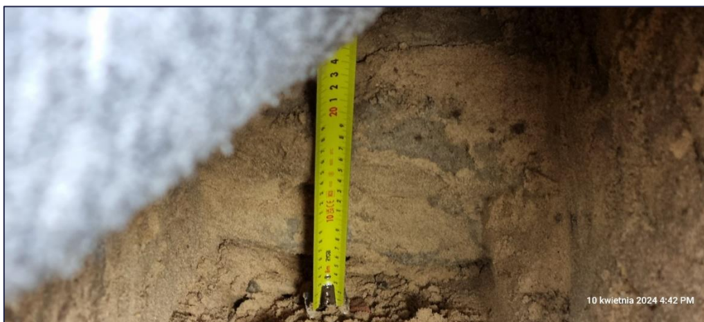
Foto 145. Widok odkrywki ściany fundamentowej i fundamentu od strony wschodniej budynku; Odkrywka zrealizowana przy wschodniej ścianie zewnętrznej bliźniaka – budynek 12B; Pomiar wysokości ławy fundamentowej;
