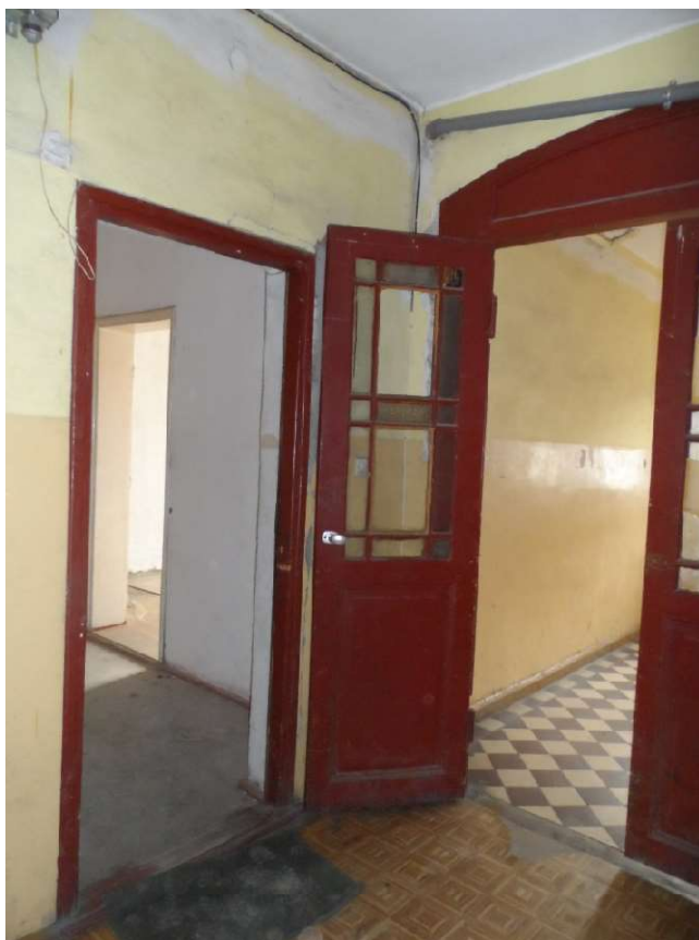
Wejście do mieszkania (po lewej) i drzwi dzielące klatkę schodową na dwie części
