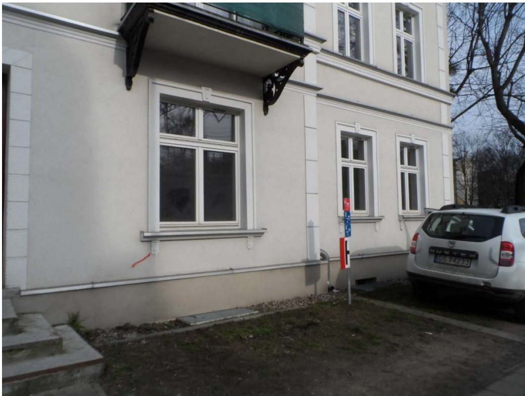
Fragment elewacji frontowej budynku od strony ul. Białej – widoczne okna na parterze należą do mieszkania nr 1
