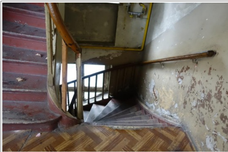
Zdj. nr 11 klatka schodowa kamienicy
