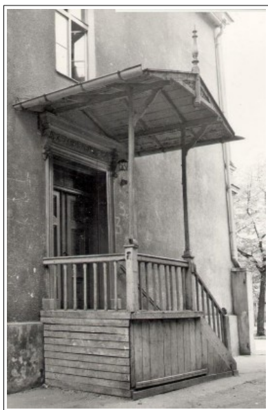
Zdj. nr historyczne zadaszenie wejścia do budynku głównego
