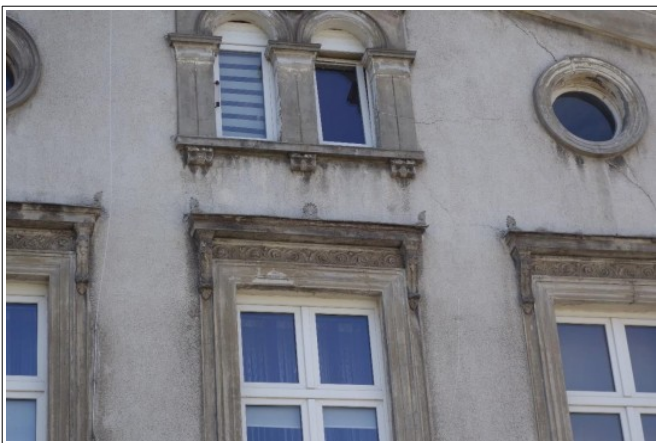
Zdj. nr 8 fasada kamienicy z wtórnym tynkiem i przemalowane sztukaterie
