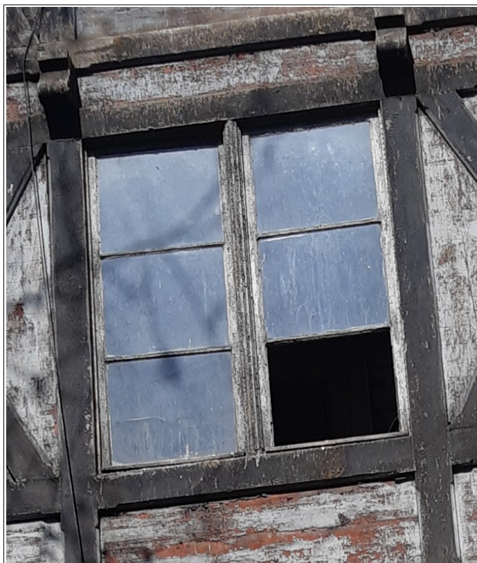
Zdj. nr 3 – Zachowana stolarka okienna w ryzalicie oficyny.
