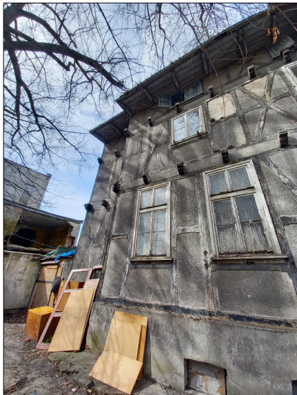
Zdj. nr 9 elewacja z muru pruskiego oficyny
