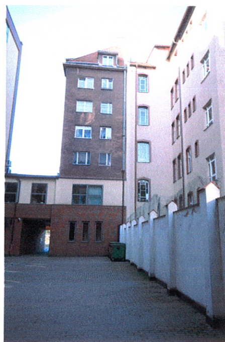
Fot. 2 Elewacja tylna 2 dolne kondygnacje należą do Centromoru
