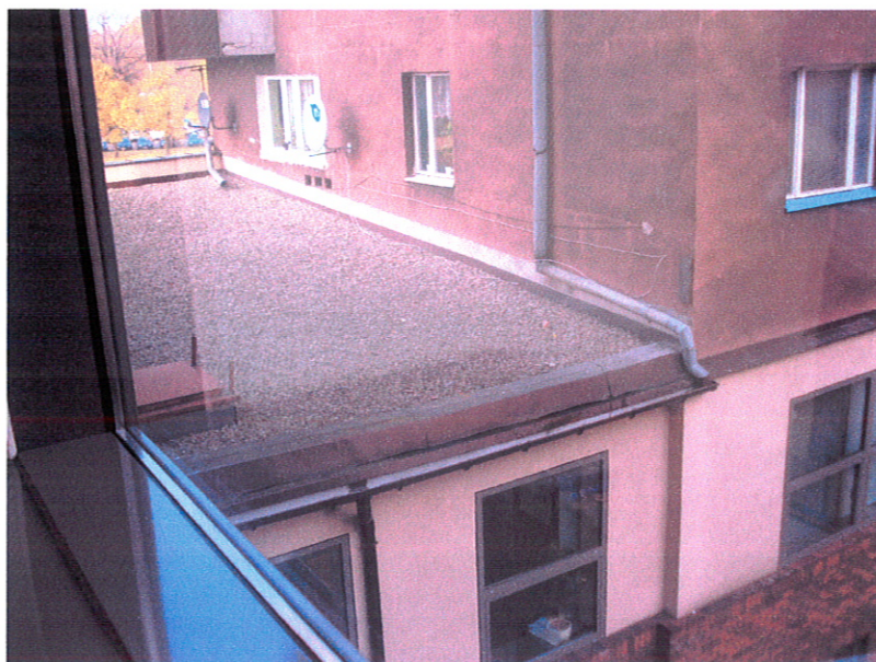
foto. 16. ODPROWADZENIE WODY DESZCZOWEJ NA STROPODACH BUDYNKU CENTROMORU
