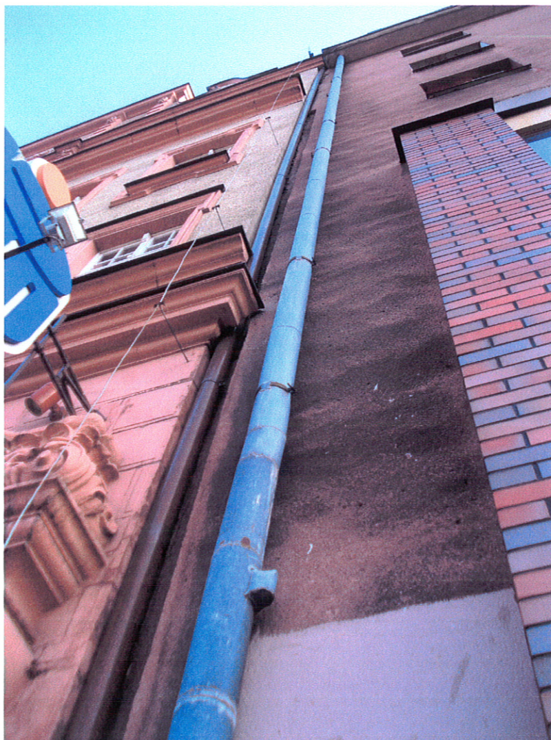
fol. 18. RURA SPUSTOWA NA ŚCIANIE ZACHODNIEJ Odprowadza wody opadowe do kanalizacji deszczowej
