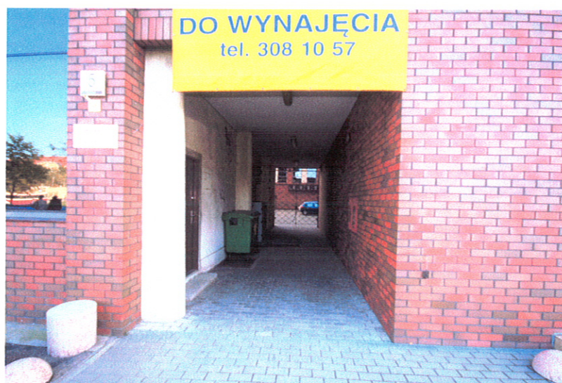
foto. 5. PRZEJŚCIE Z ULICY OKOPOWEJ NA WEWNĘTRZNY DZIEDZINIEC
