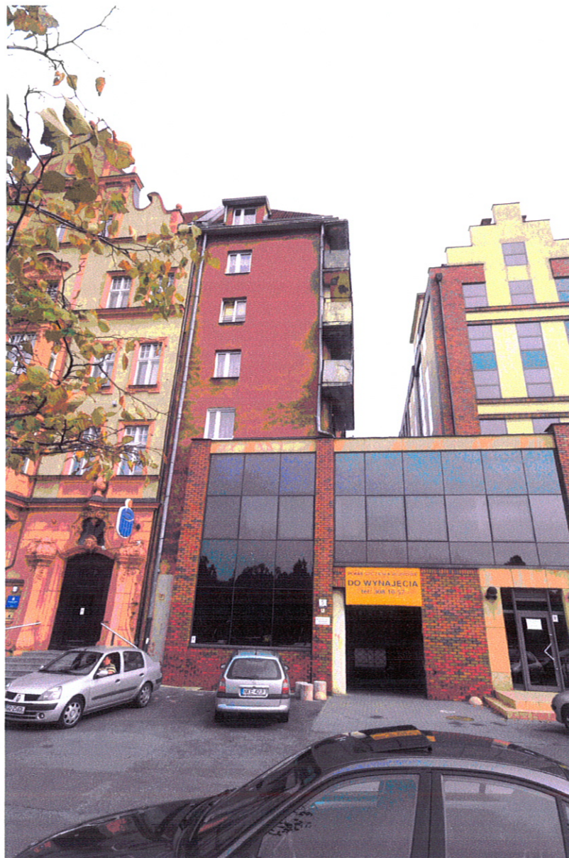
foto. 1. ELEWACJA ZACHODNIA – FRONTOWA
