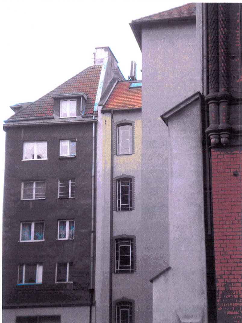
foť. 4. FRAGMENT ELEWACJI PÓŁNOCNEJ – BOCZNEJ (PONAD DACHEM BUDYNKU SĄSIEDNIEGO)
